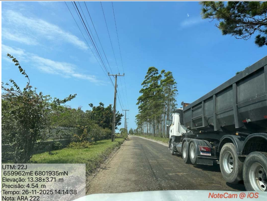
Legenda: Tráfego de Veículos Pesados - Rodovia ARA-222
