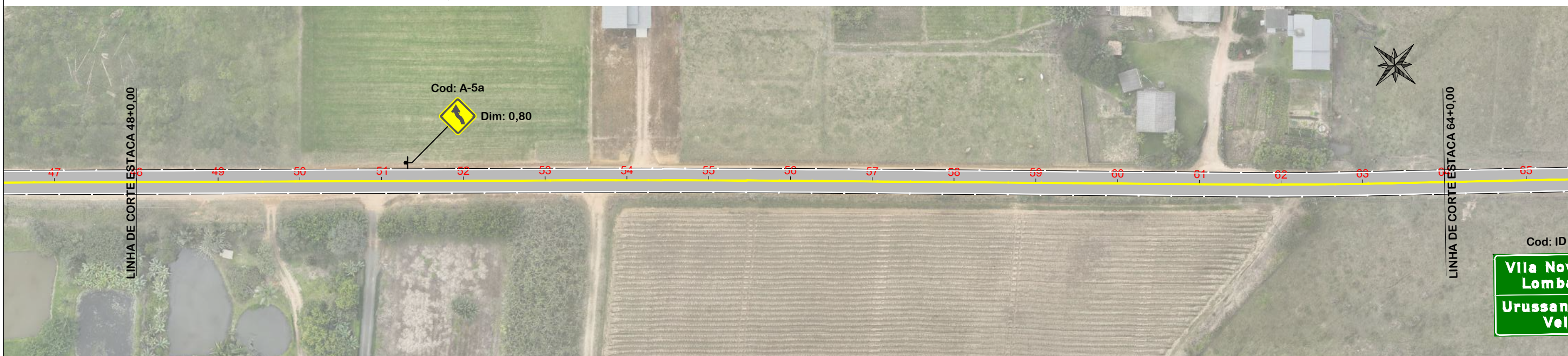
RODOVIA HILDEBRANDO JOSÉ DA LUZ - TRECHO 01 NOTA: IMAGEM AÉREA OBTIDA ATRAVÉS DE DRONE DJI MAVIC 3 ENTERPRISE, UTILIZADA SEM FINS CARTOGRÁFICOS.
