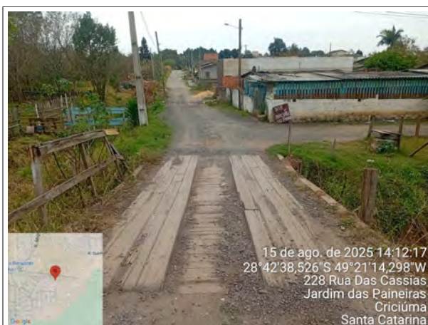
Figura 8.1 - Ponte de madeira existente – Rua das Acácias
