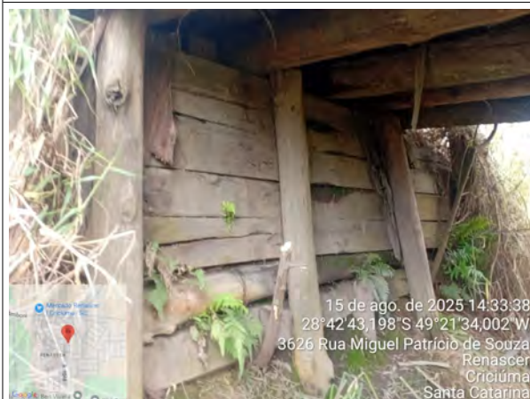
Figura 8.2 - Cabeceira da ponte da Rua das Acácias
