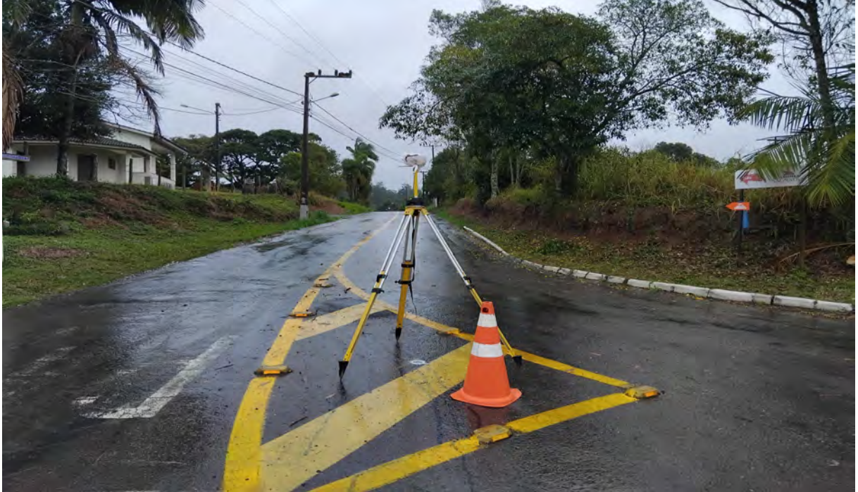
Figura 3.9 – Implantação e georreferenciamento de marco geodésico
