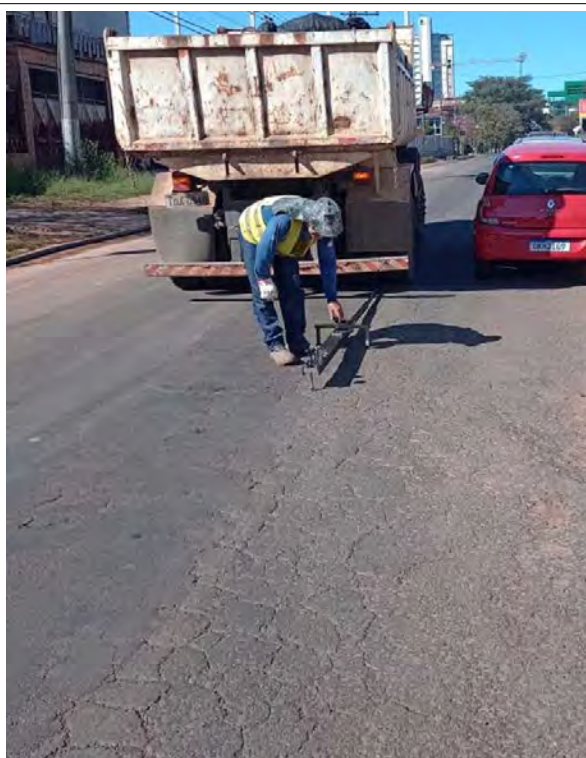
Figura 4.13 - Levantamento com Viga Benkelman
