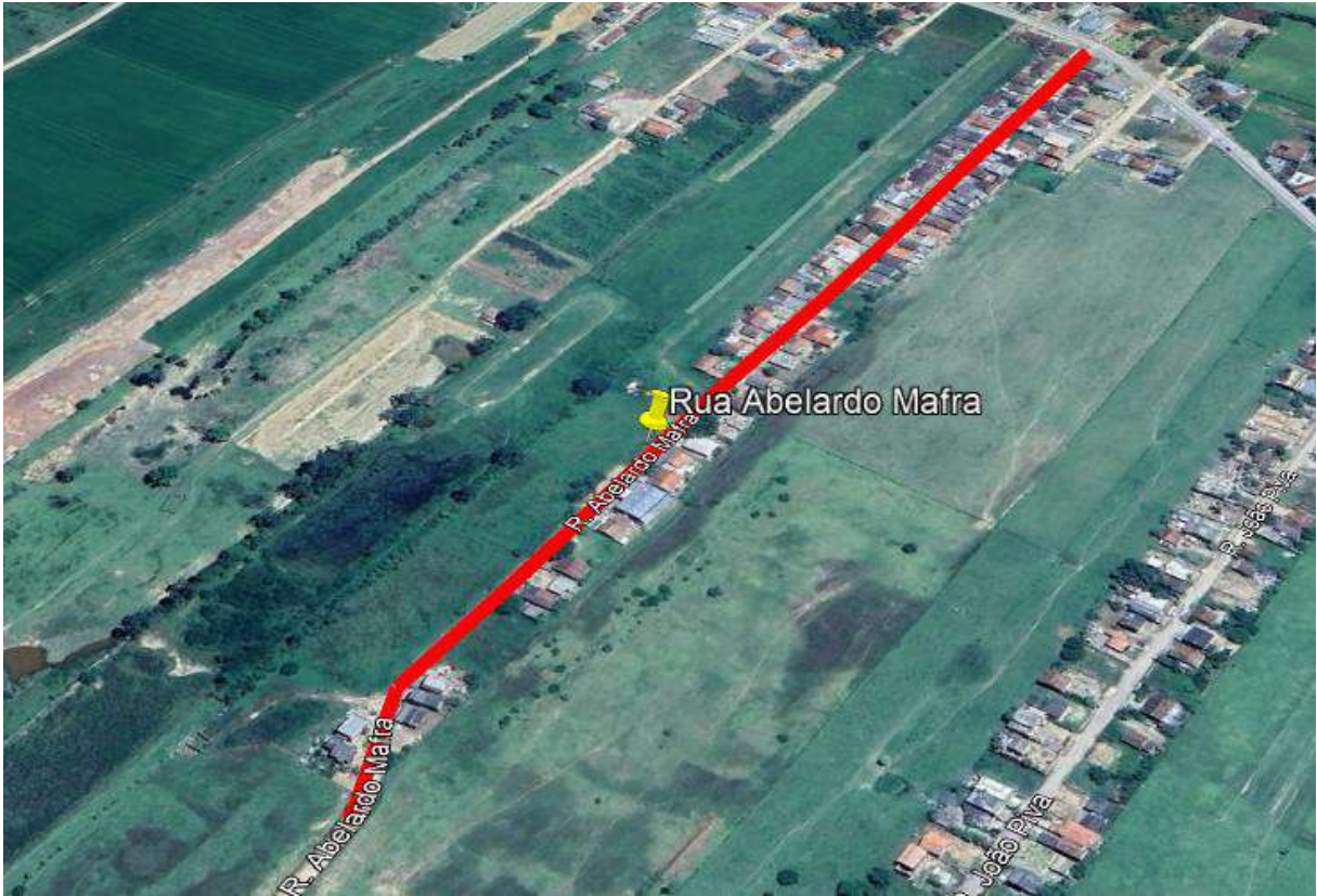
Figura 2.1 – Imagem Aérea do Empreendimento
