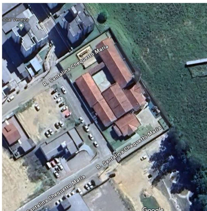
Figura 1: imagem aérea da edificação
