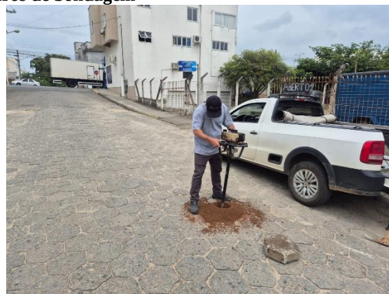
Figuras 3 e 4 – Furos de Sondagem
