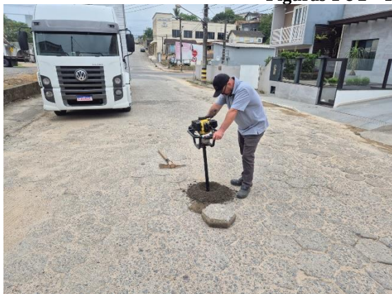
Figuras 1 e 2 – Furos de Sondagem
