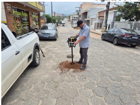
Figuras 3 e 4 – Furos de Sondagem
