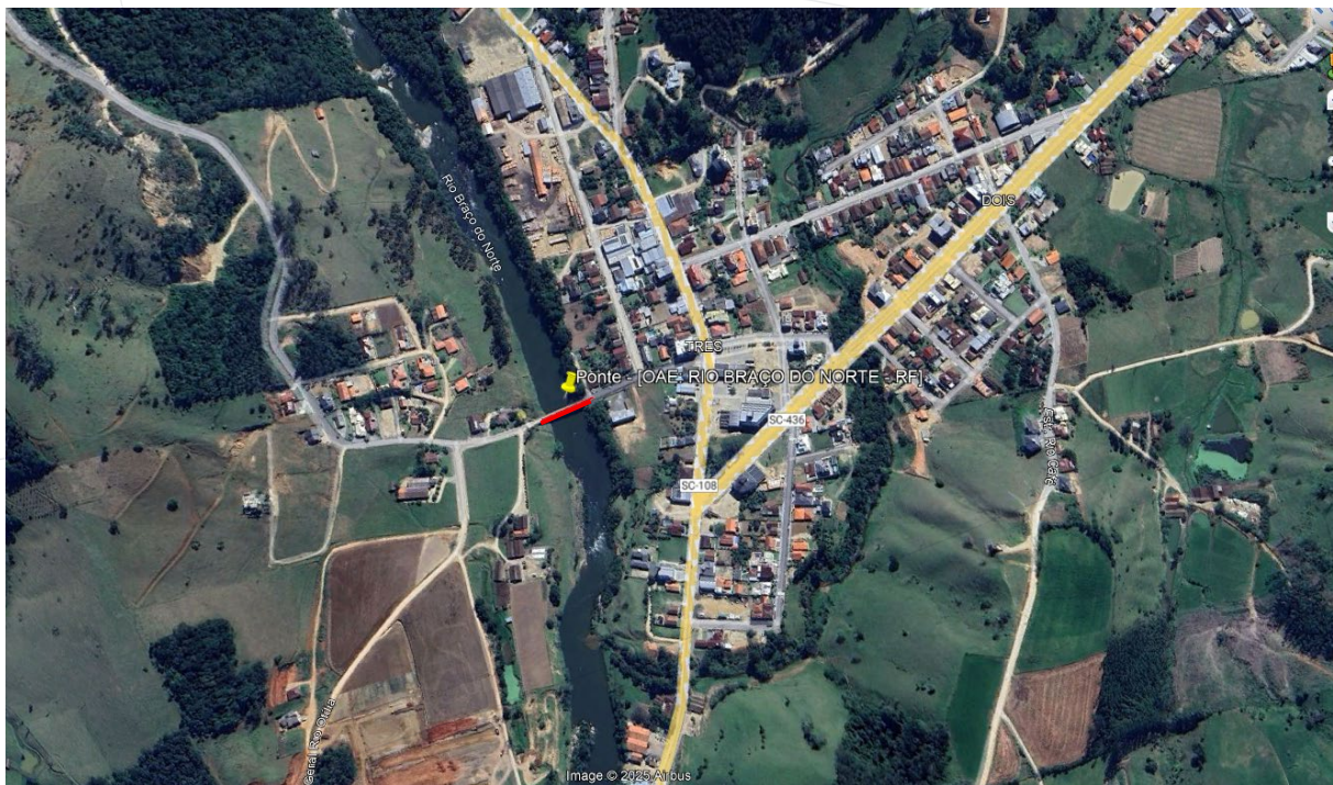
Figura 1 - Localização da Obra de Arte Especial em Rio Fortuna.
