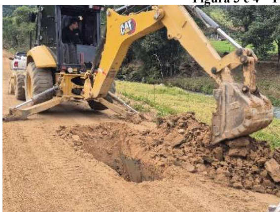
Figura 5 e 6 – Furos de Sondagem
