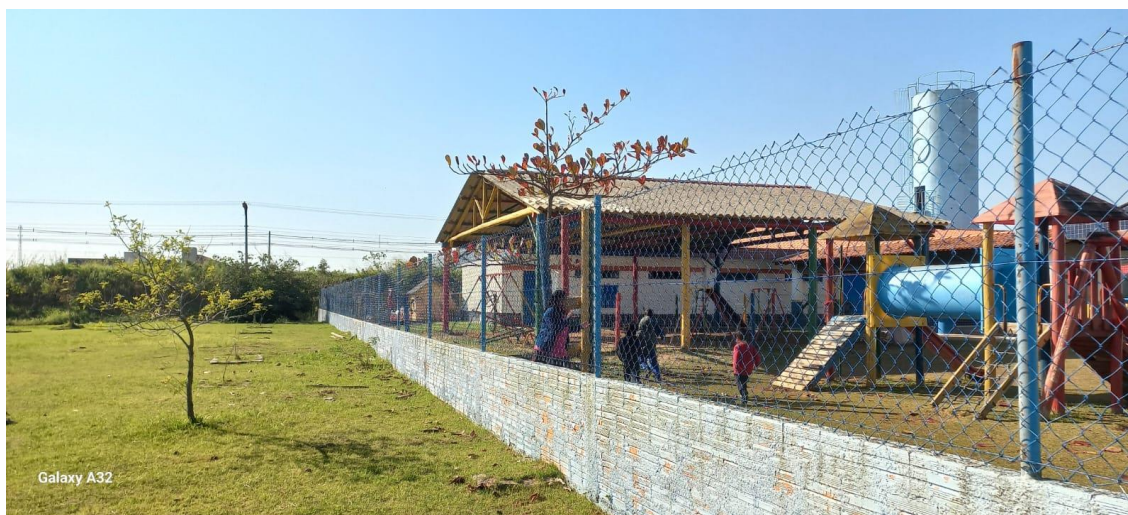
Figura 2 – Parque em madeira à retirar e muro para ampliação.
