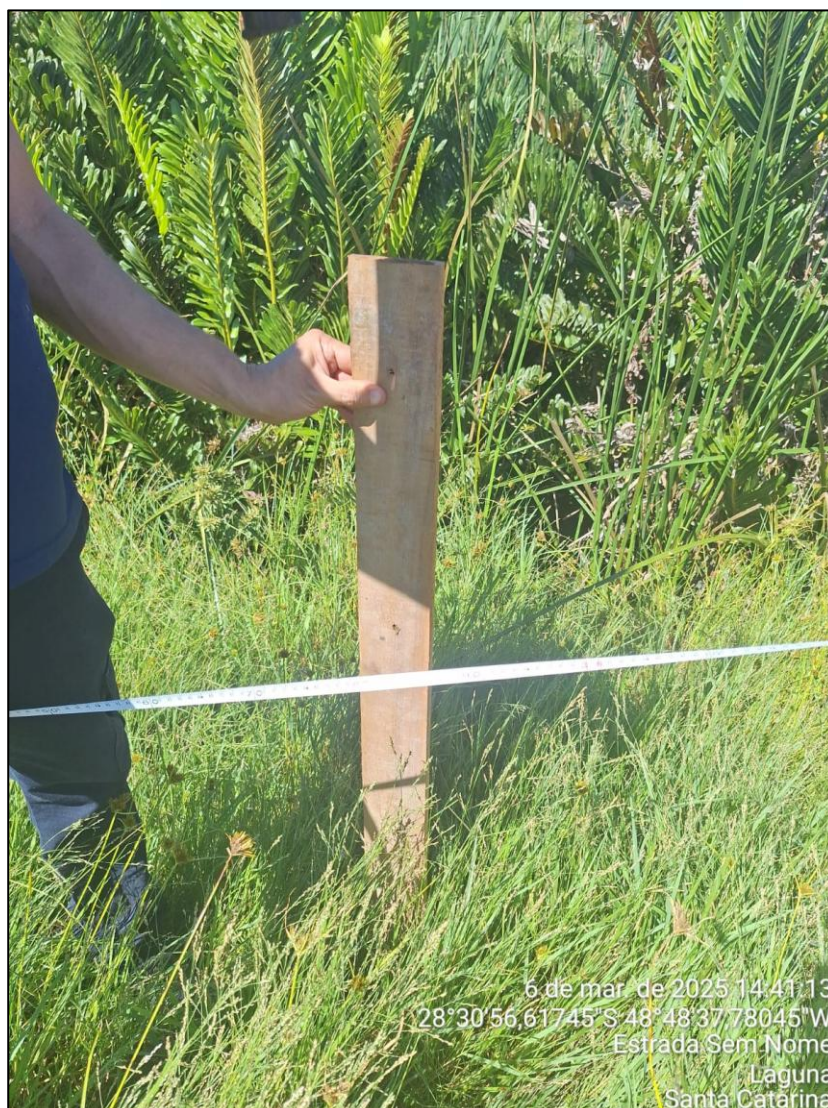
Figura 6: Implantação das estacas na ilha. Fonte: Sepagri, 2025.
