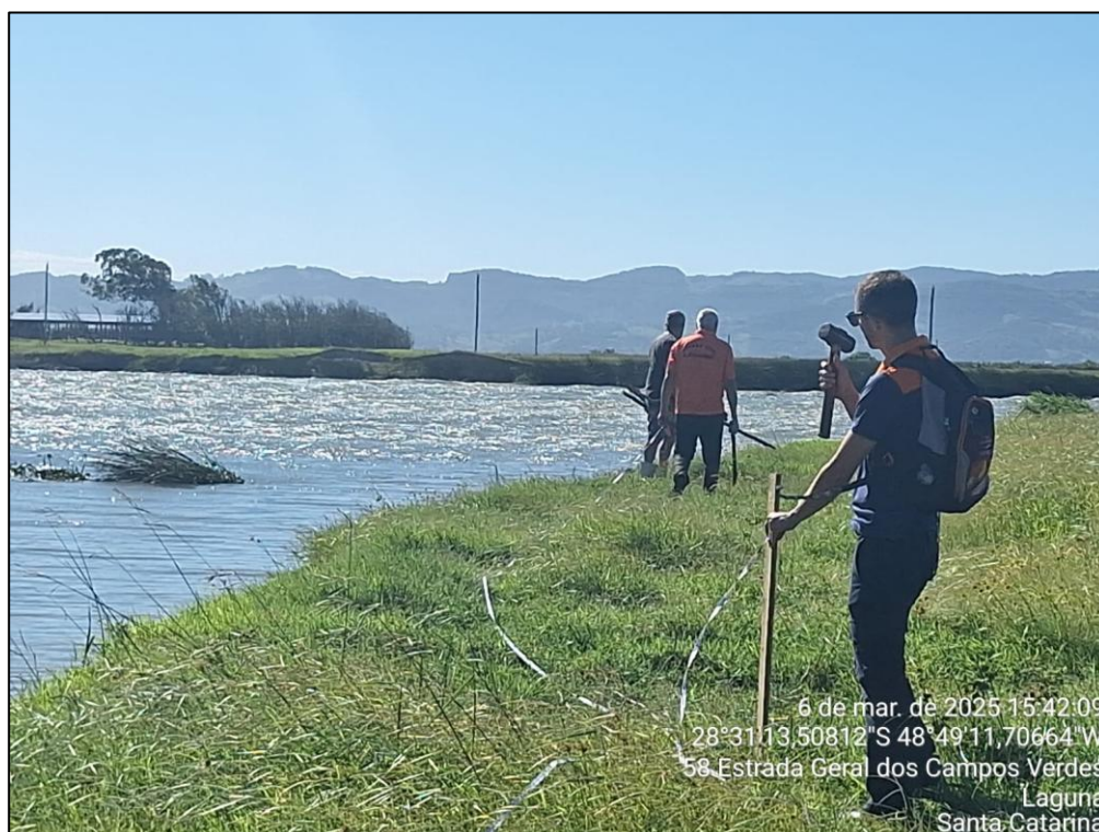
Figura 4: Implantação das estacas na ilha. Fonte: Sepagri, 2025.
