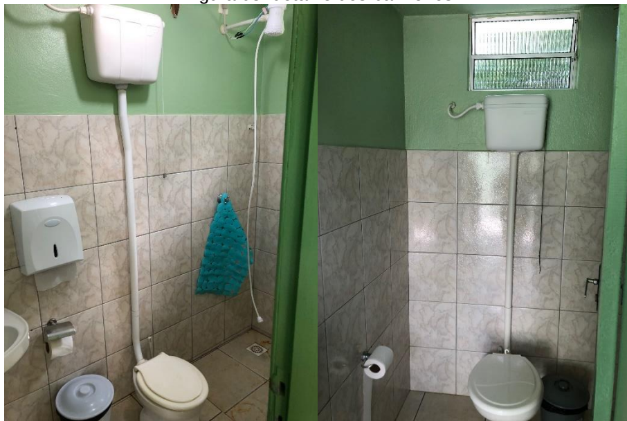
Figura 08: detalhe dos banheiros
