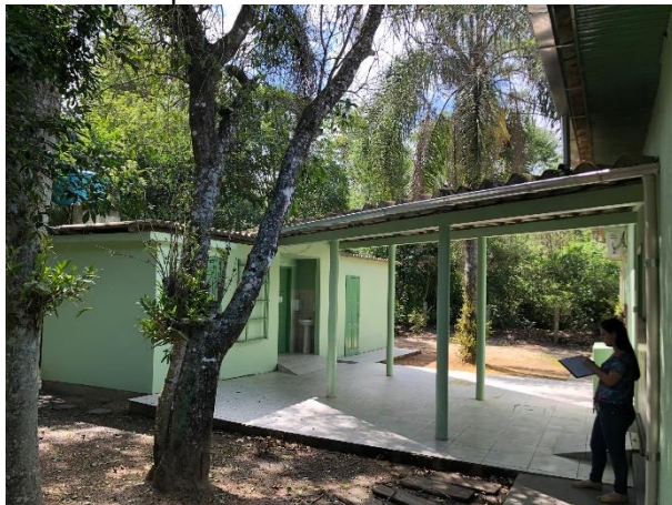
Figura 02: vista do pátio coberto onde localizam-se os banheiros
