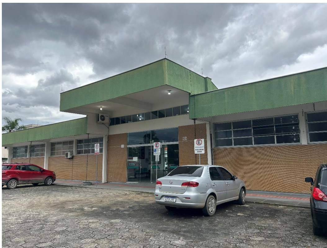
Figura 01: Vista frontal da edificação. Fonte: Diretoria de Planejamento, 2025.
