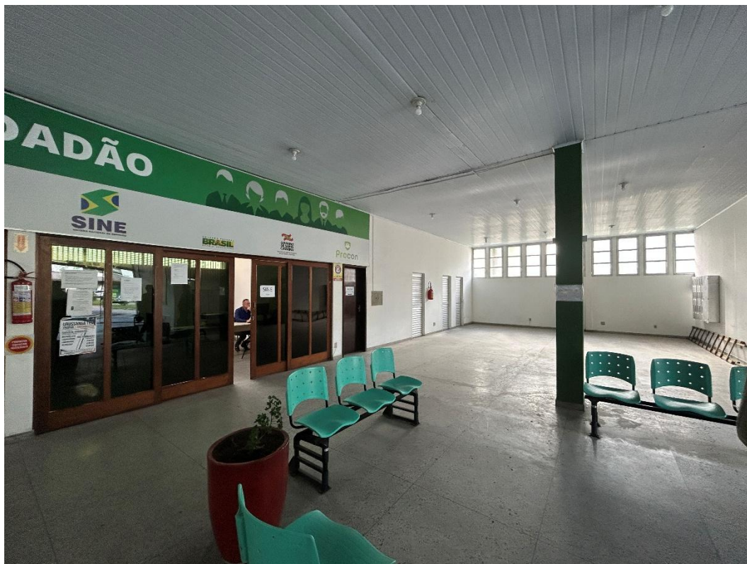
Figura 02: vista interna da edificação. Fonte: Diretoria de Planejamento, 2025.
