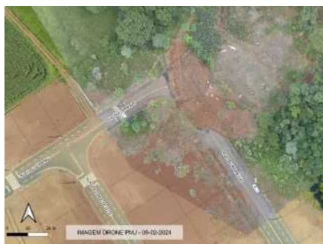
Figura 09 – Após rompimento e deslizamento do talude de aterro (Prefeitura Municipal de Joaçaba, 09 de fevereiro de 2024)
