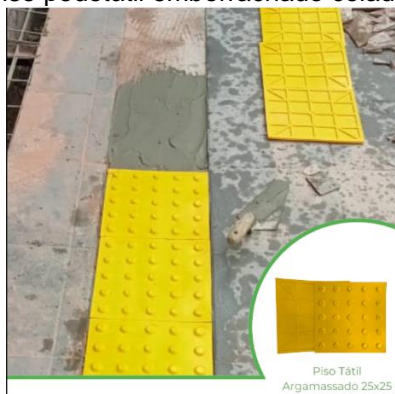
Fotografia 06 – piso podotátil emborrachado colado com argamassa
