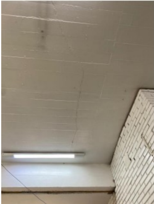
Figura 19 - Fissuras laje do ambiente utilizado como copa e na viga V7
