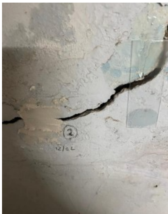
Figura 26 - – Monitoramento rachadura 45 graus parede do banheiro feminino em 12/01
