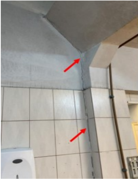
Figura 15 - Rachadura entre alvenaria e estrutura banheiro feminino
