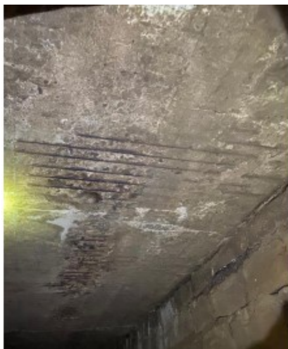
Figura 55- Armadura exposta
