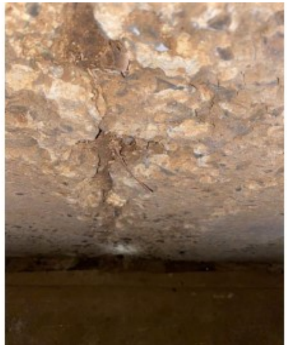
Figura 51- Segregação do concreto na laje da galeria
