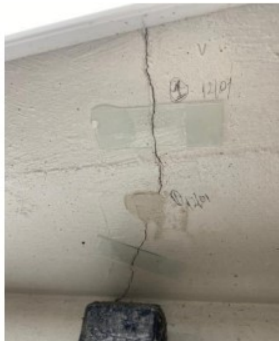
Figura 25 – Monitoramento rachadura 45 graus parede do banheiro feminino em 12/01
