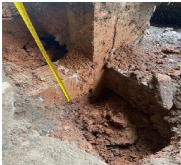
Figura 43- Escavação da fundação
