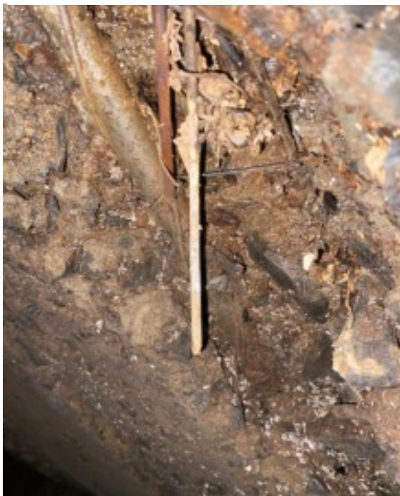
Figura 51- Segregação do concreto na laje da galeria
