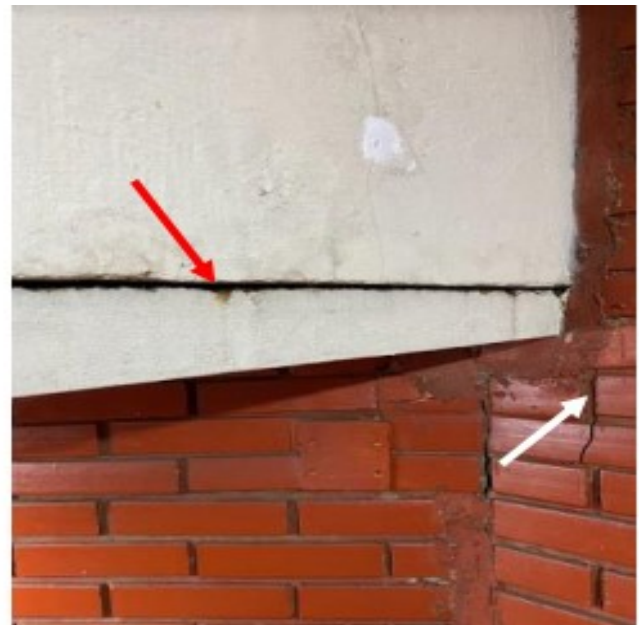
Figura 38 Desmembramento viga V7 com a laje e fissura na alvenaria do depósito de materiais
