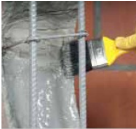
Figura 68- aplicação da resina para promover a aderência do concreto.
