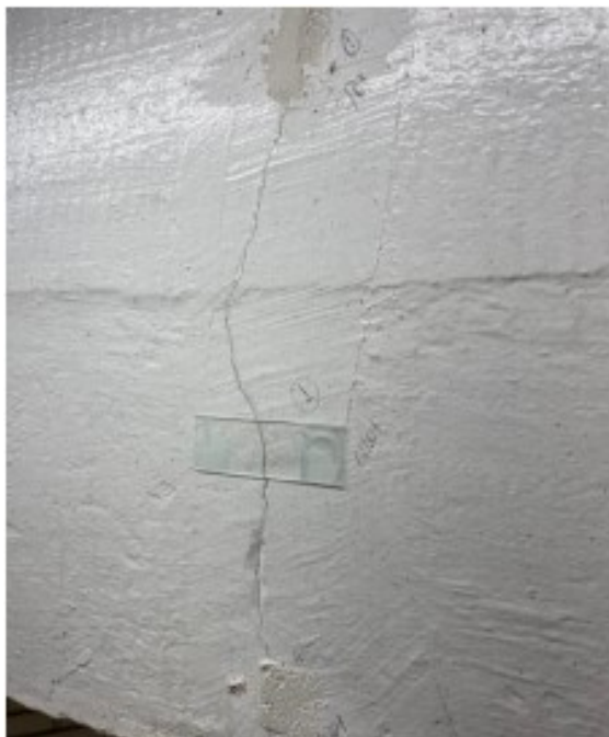
Figura 25 – Monitoramento rachadura 45 graus parede do banheiro feminino em 12/01
