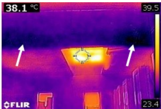
Figura 44 - Presença de umidade elementos estruturais do banheiro feminino
