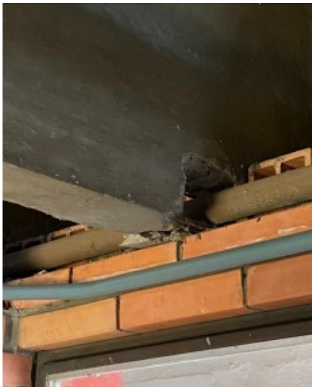
Figura 40 - Furação na viga V2 dentro do mezanino
