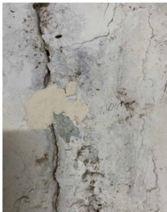
Figura 26 - – Monitoramento rachadura 45 graus parede do banheiro feminino em 12/01
