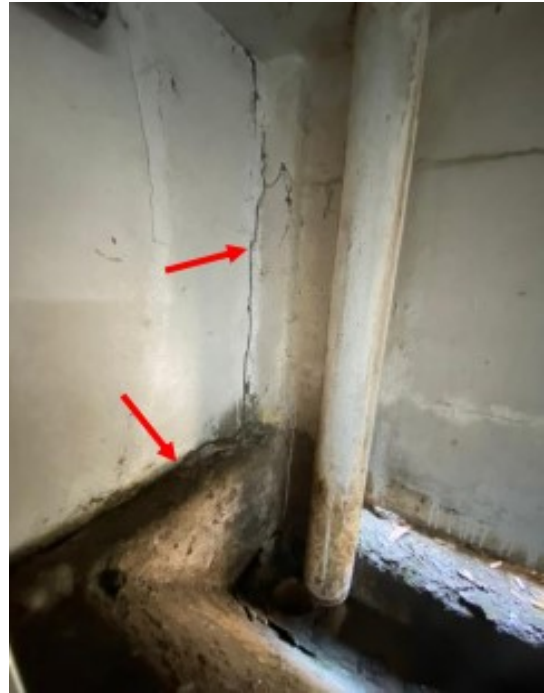
Figura 15 - Rachadura entre alvenaria e estrutura banheiro feminino
