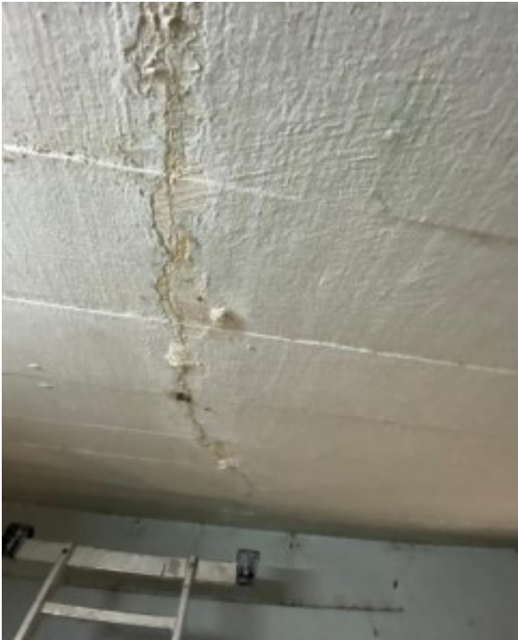
Figura 28 - Monitoramento rachadura 45 graus parede do banheiro feminino em 12/01
