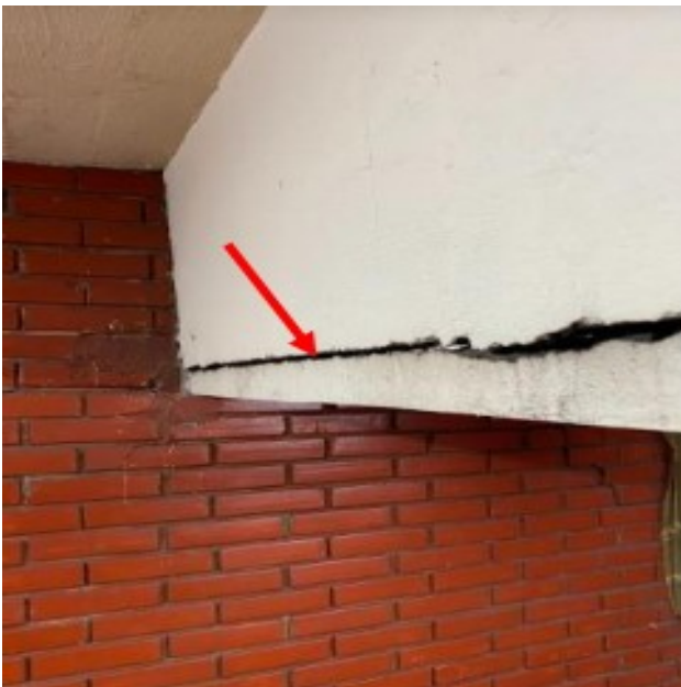
Figura 38 Desmembramento viga V7 com a laje e fissura na alvenaria do depósito de materiais
