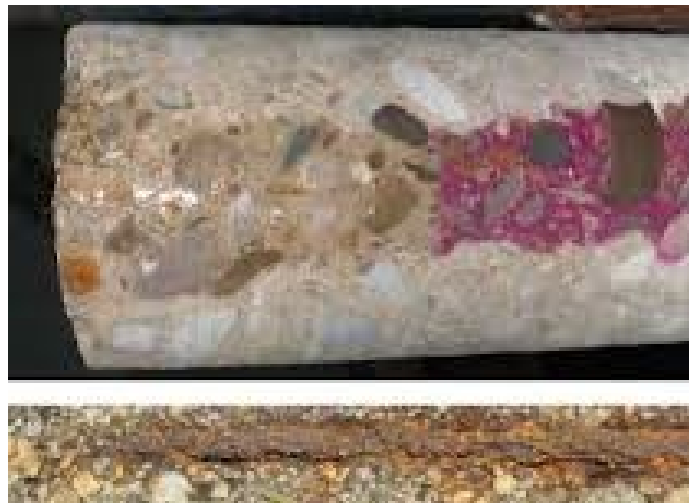
Figura 60 - Aplicação de indicadores no concreto para determinação da qualidade do concreto
