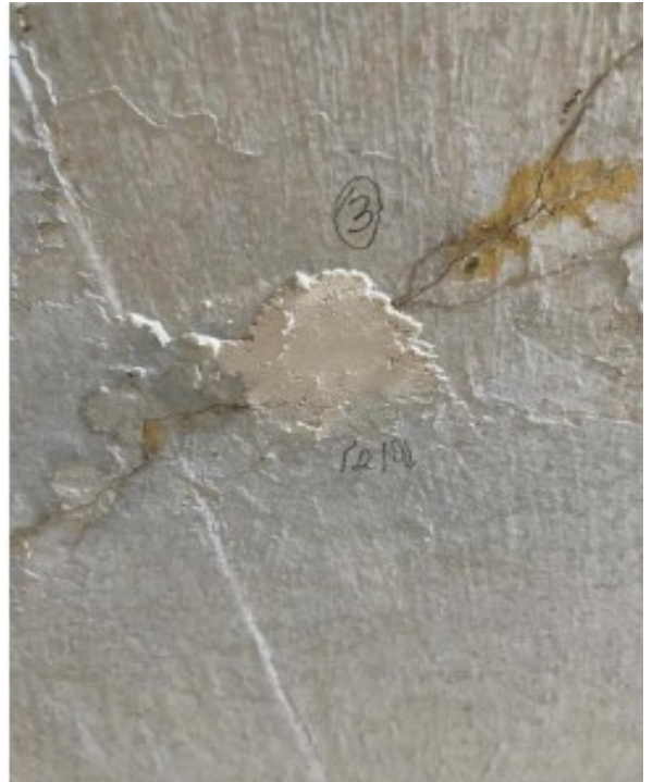
Figura 28 - Monitoramento rachadura 45 graus parede do banheiro feminino em 12/01
