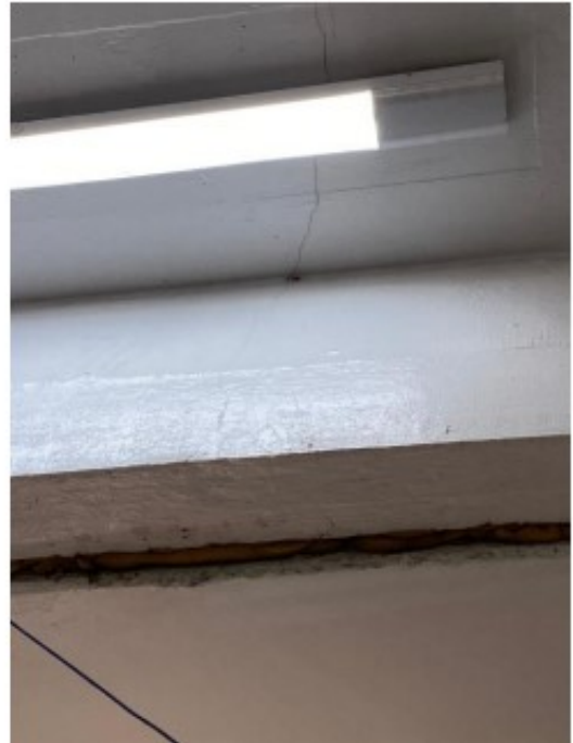
Figura 19 - Fissuras laje do ambiente utilizado como copa e na viga V7
