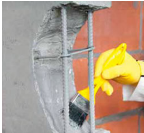
Figura 68- aplicação da resina para promover a aderência do concreto.
