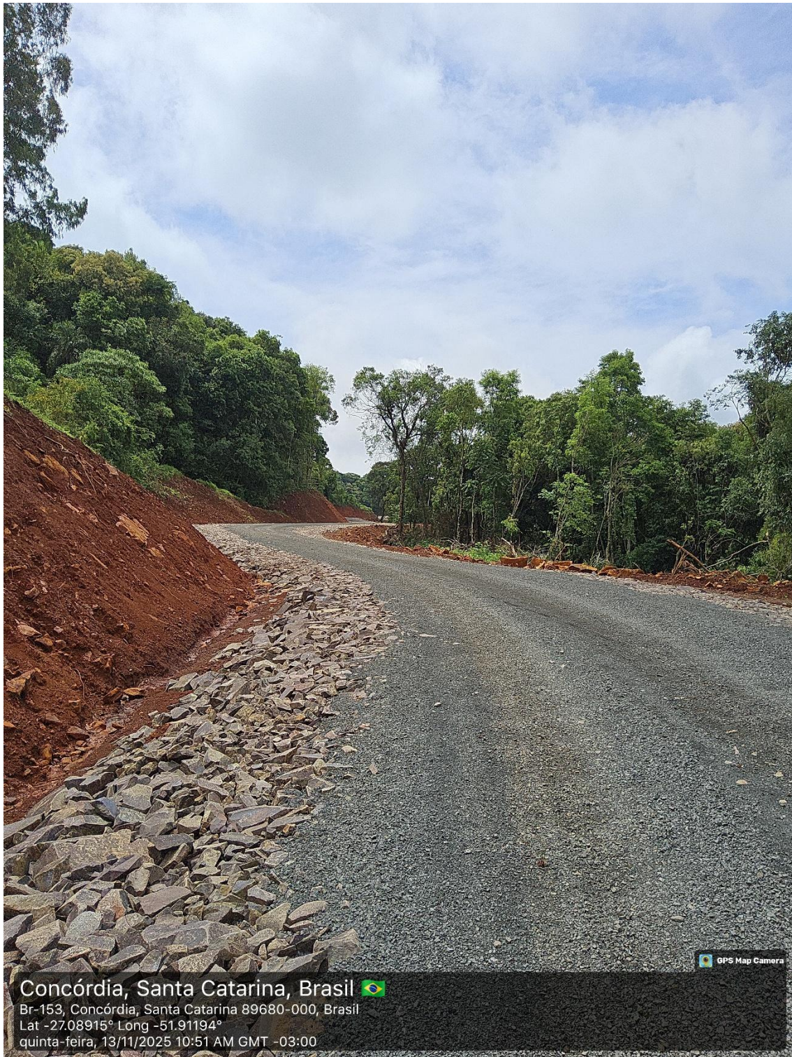
Imagem 08: Trecho da estrada sentido Lajeado do Meio situação atual.
