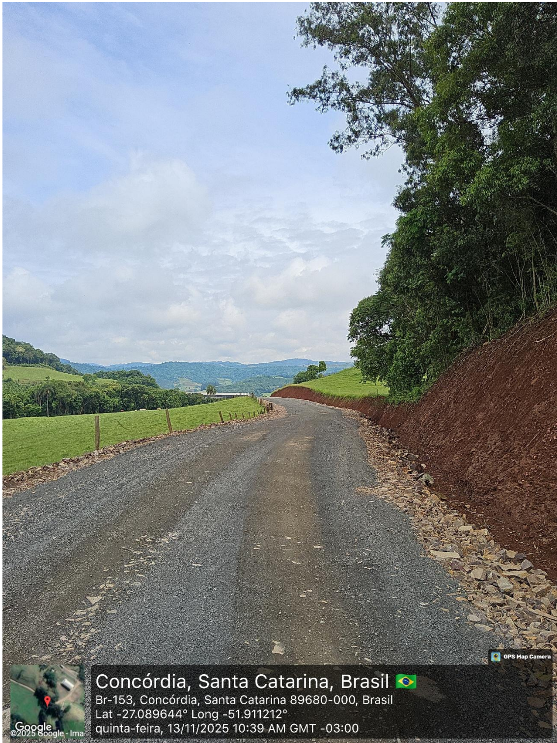
Imagem 07: Trecho da estrada sentido Lajeado do Meio situação atual.
