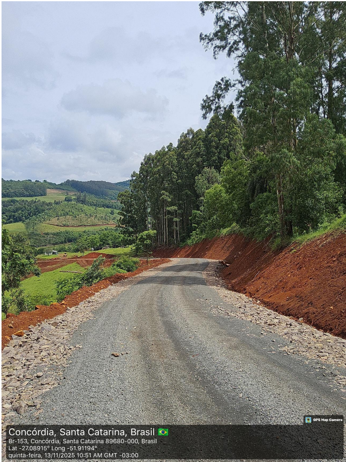
Imagem 09: Trecho da estrada sentido Lajeado do Meio situação atual.
