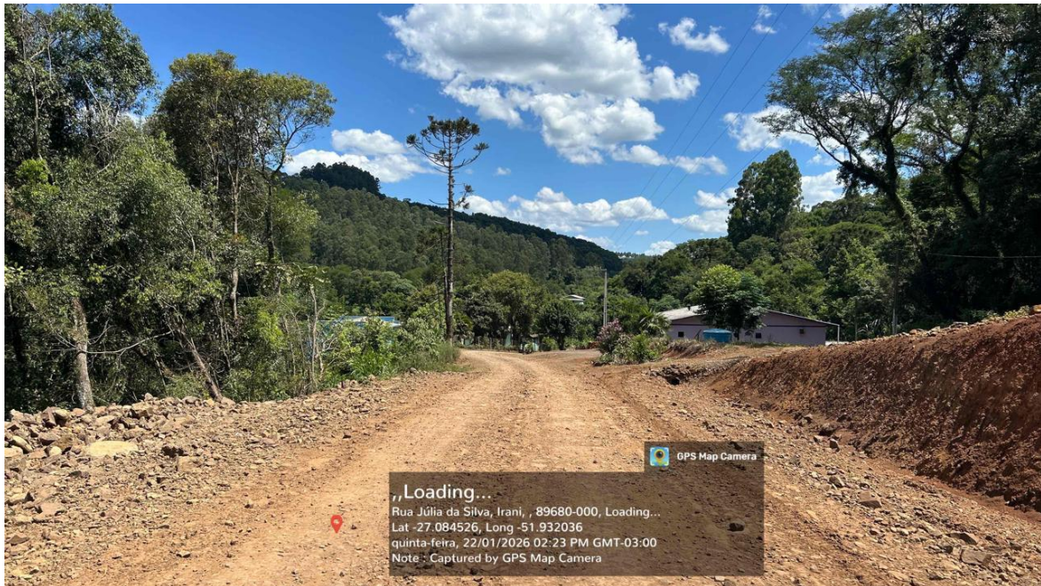
Imagem 13: Trecho da estrada sentido Lajeado do Meio situação atual.
