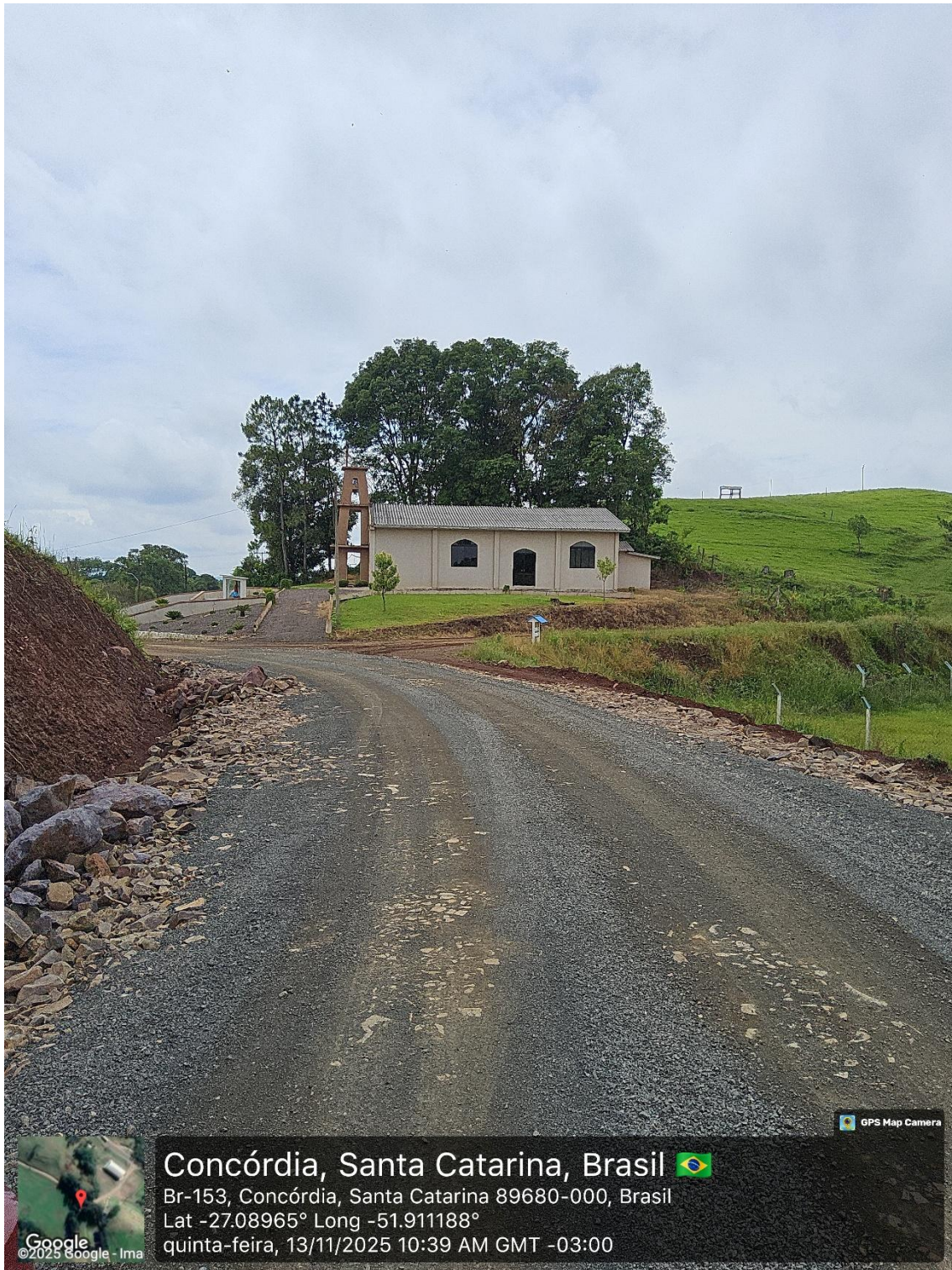
Imagem 06: Trecho inicial da estrada sentido Lajeado do Meio situação atual.
