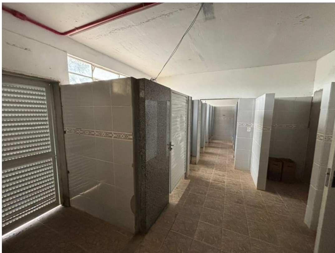
Figura – revestimentos a serem removidos
