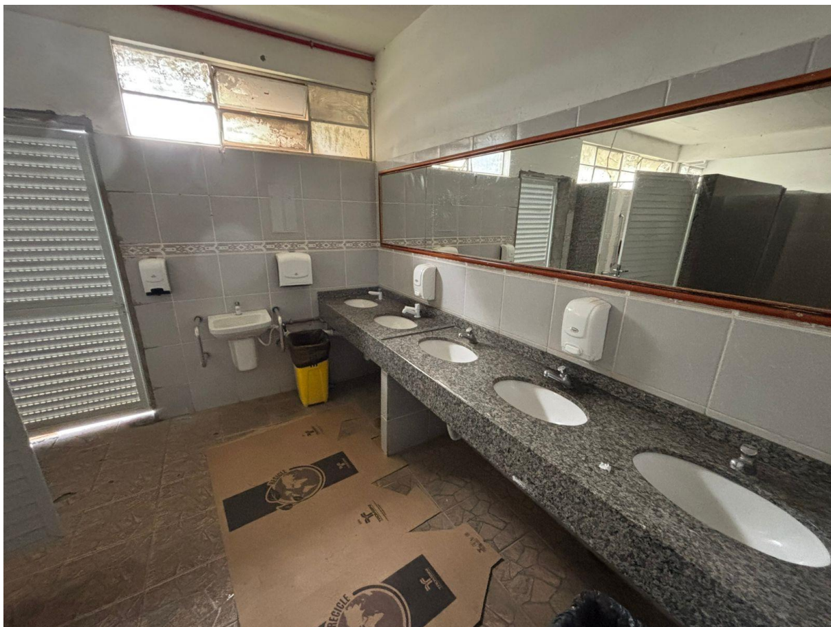
Figura – banheiro feminino - revestimentos a serem removidos
