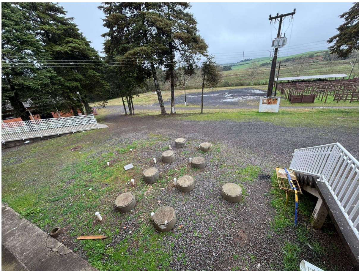
Figura – Local de construção de mureta de proteção do sistema de tratamento de esgoto
