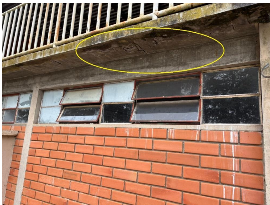
Figura – grauteamento de armaduras expostas
