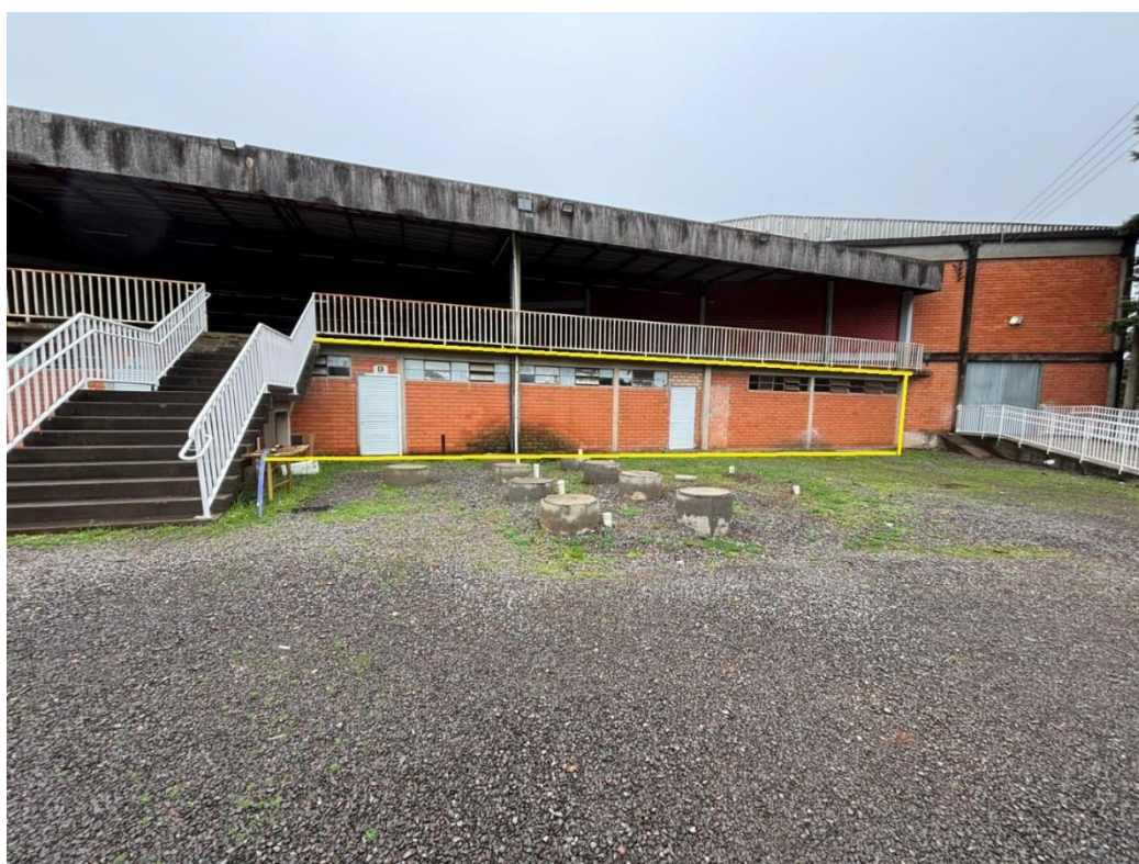
Figura – área da fachada externa a ser revestida
