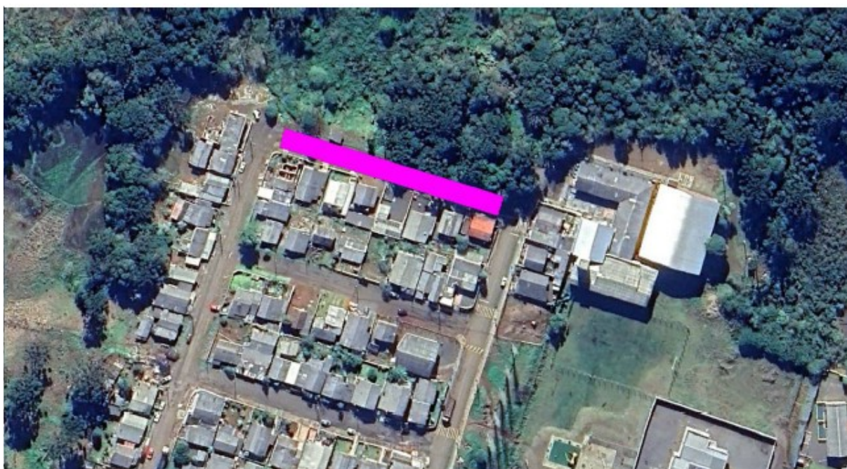
Figura – Rua a pavimentar
