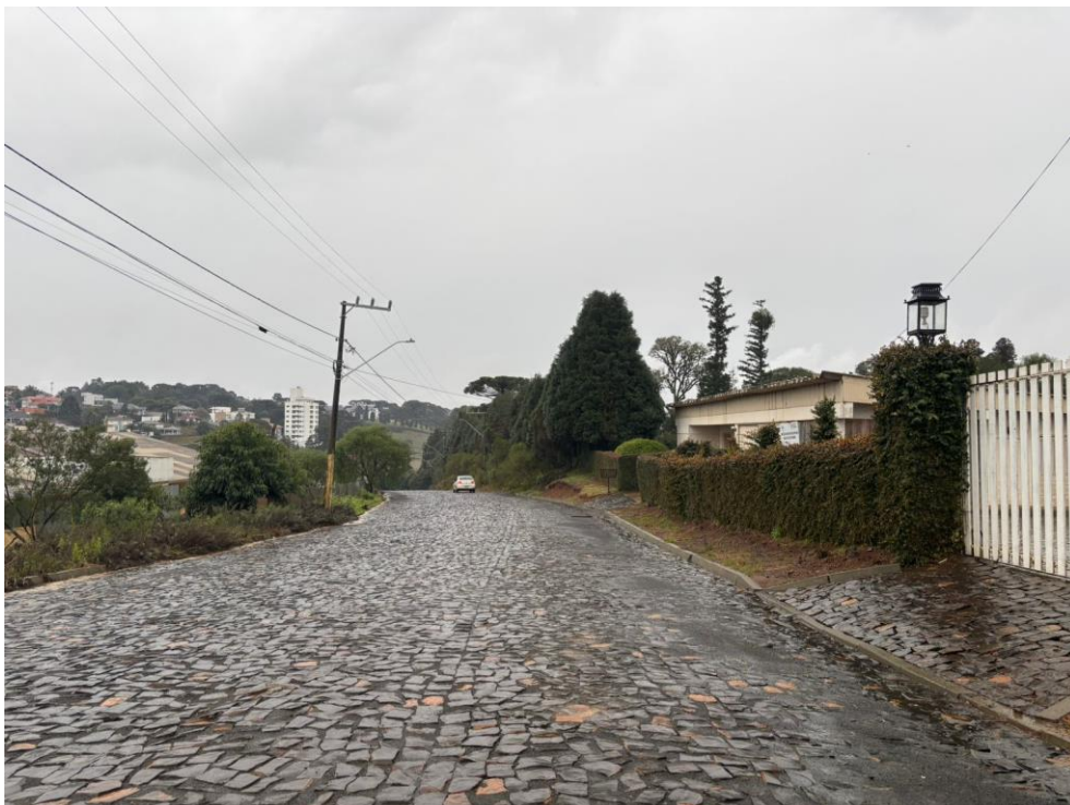
Figura 3 – Trecho existente-pavimento em pedras poliédricas irregulares
