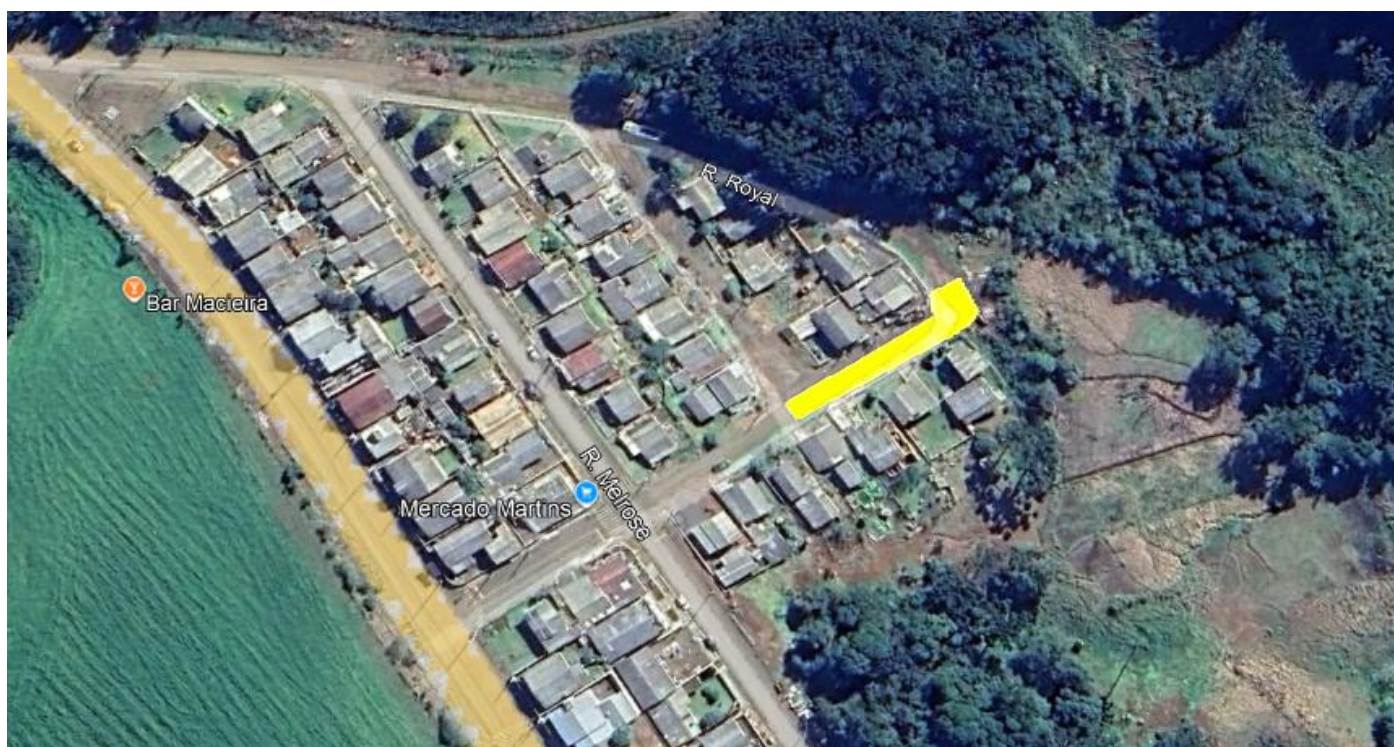
Figura 1 - Rua a pavimentar
