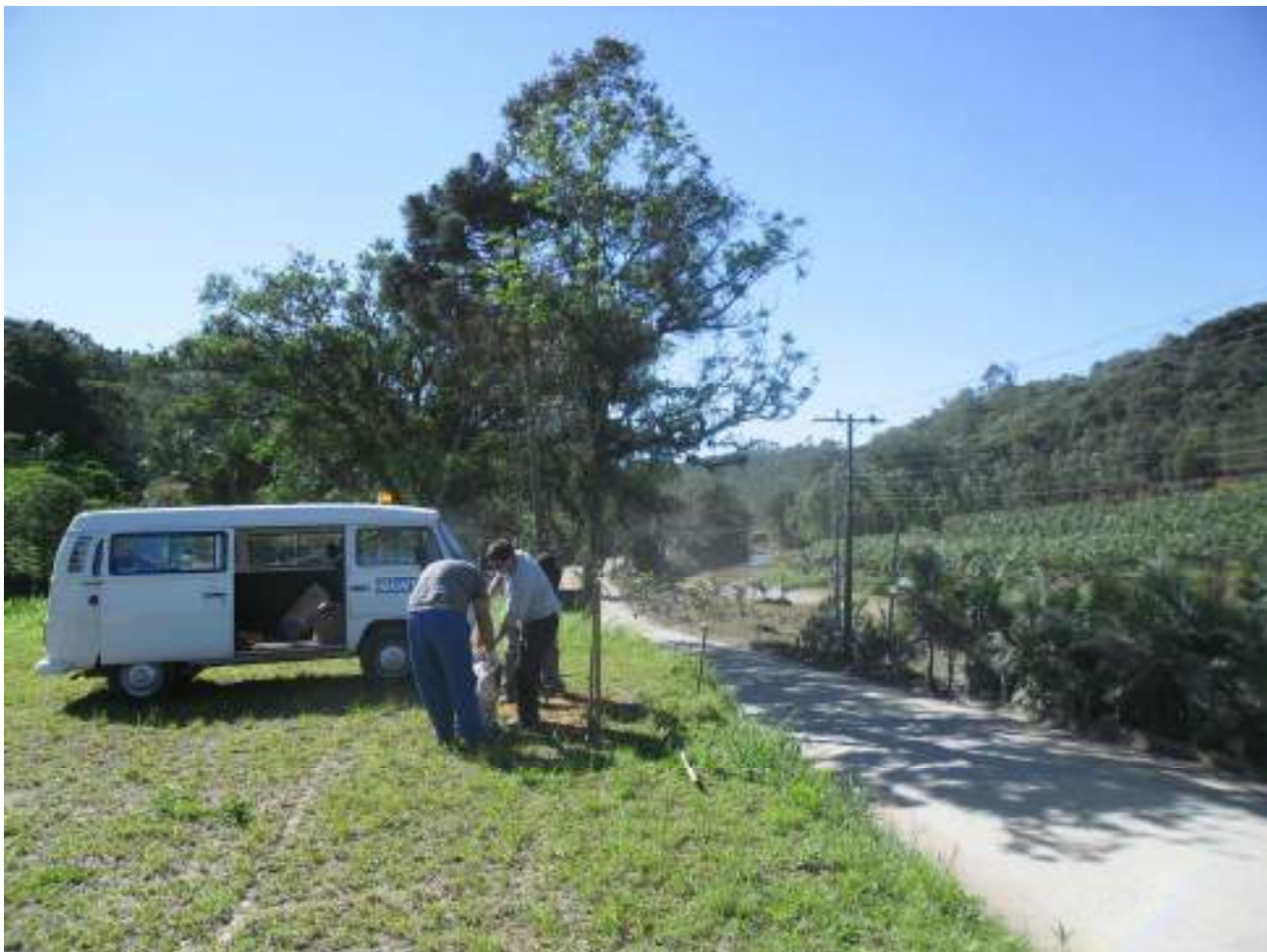
Figura 2.5.1 – Execução de sondagem a trado
