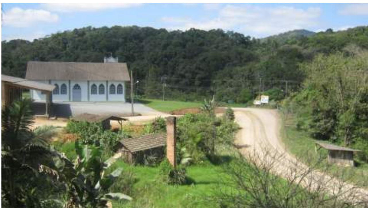
Figura 2.6.21: Vista da estrada existente – Igreja e edificações – Travessia Urbana comunidade Braço Direito (km 34+900).
