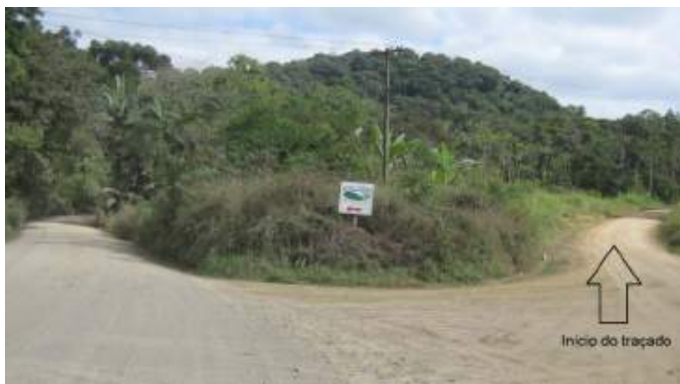
Figura 2.6.12: Início do trecho onde a rodovia será implantada – vegetação existente (km 30+400)
