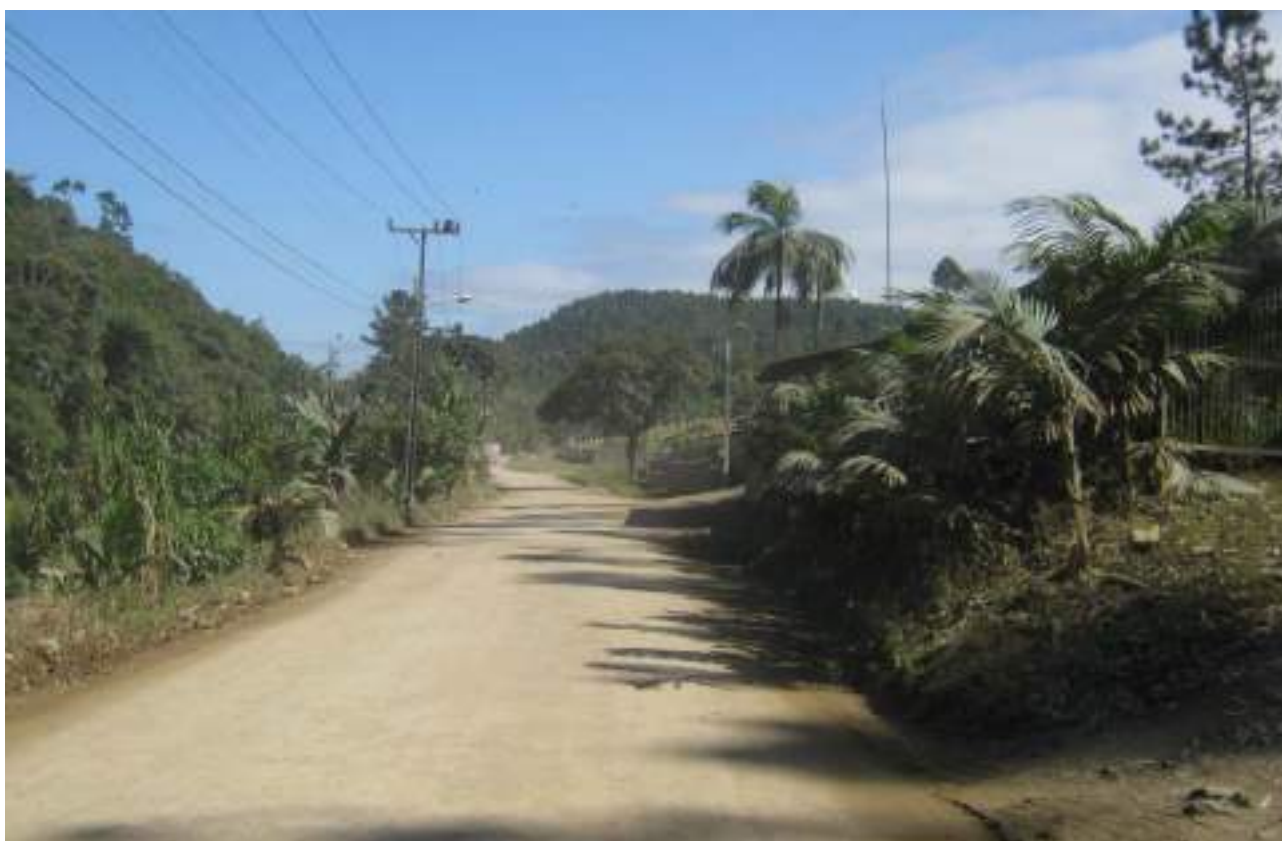
Figura 2.6.29: Postejamento com distribuição de rede elétrica às margens da estrada existente.
