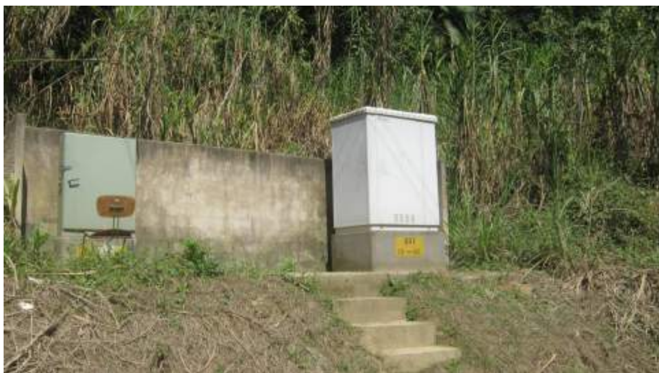
Figura 2.6.30: Distribuição da rede de telefonia fixa às margens da estrada existente.
