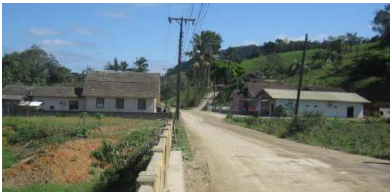
Figura 2.6.18: Edificações às margens da estrada existente – Travessia Urbana
