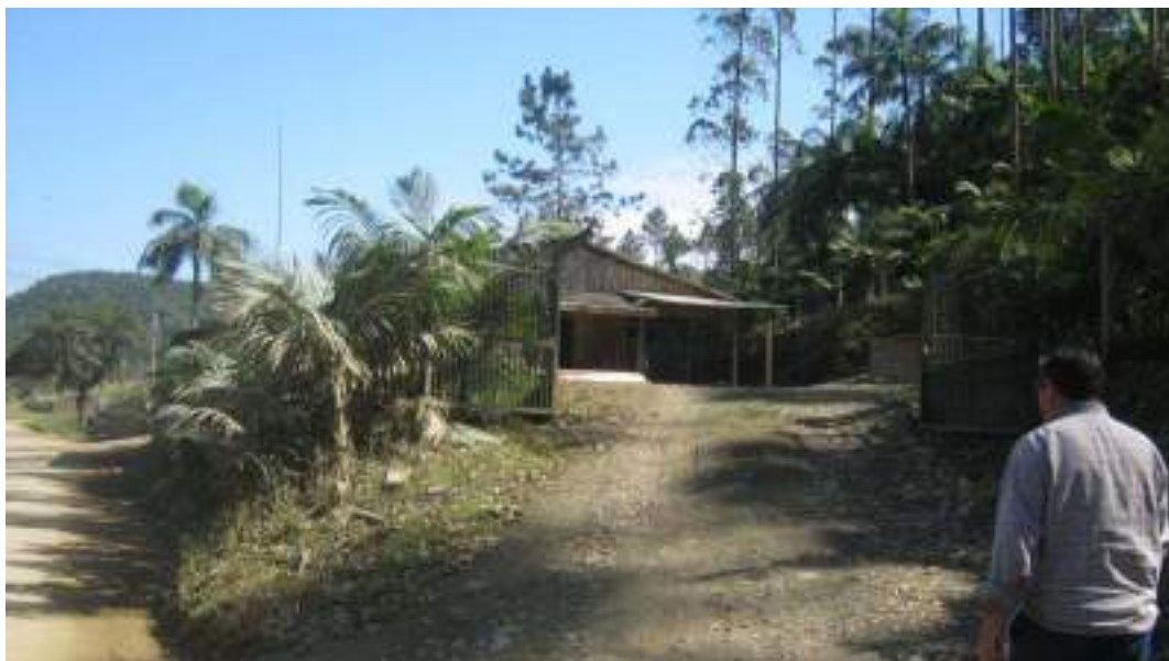
Figura 2.6.15: Galpão às margens da estrada existente e que será desapropriado para a implantação da rodovia (km 31+050, LD).
