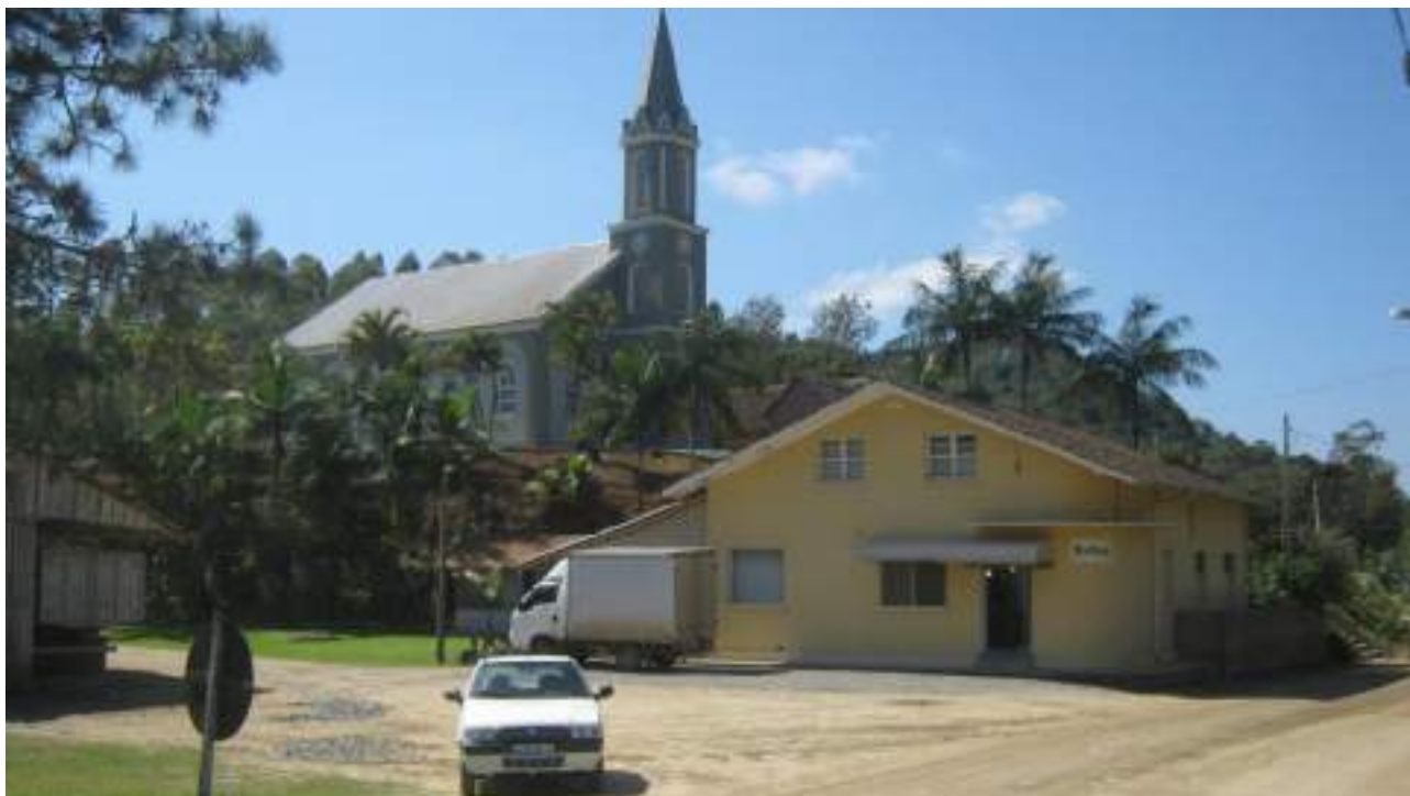
Figura 2.6.19: Travessia urbana – Comunidade de São José (km 32+600 – 33+420).
