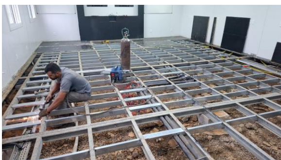
Foto 7: Reforço metálico no piso.
