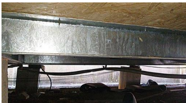
Foto 16: Passagem dos eletrodutos abaixo do piso OSB.
