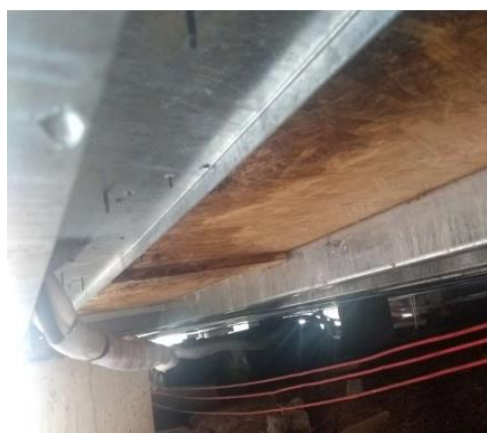
Foto 10: Chapa de OSB com umidade.
