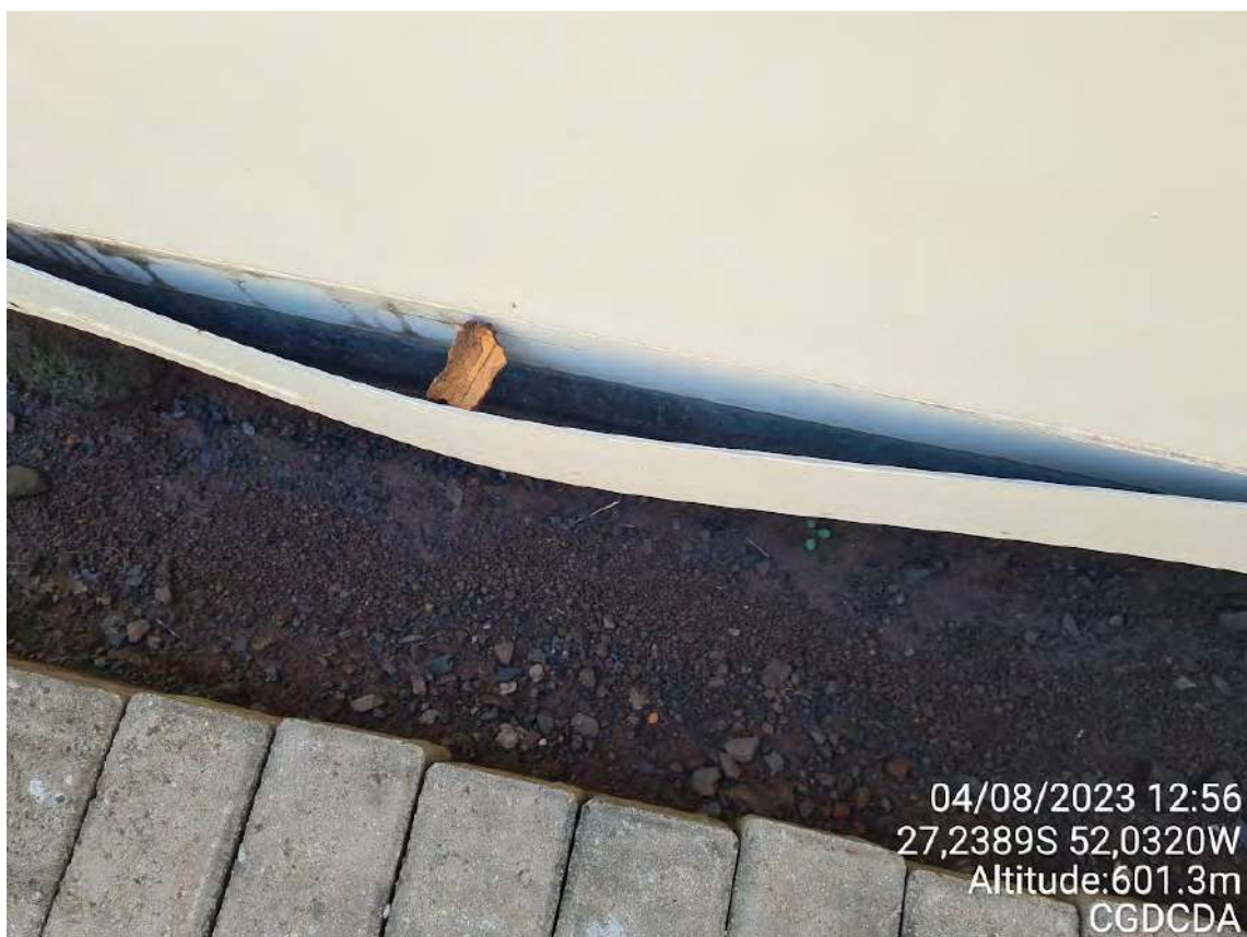
Figura 5 - Parede dos fundos
