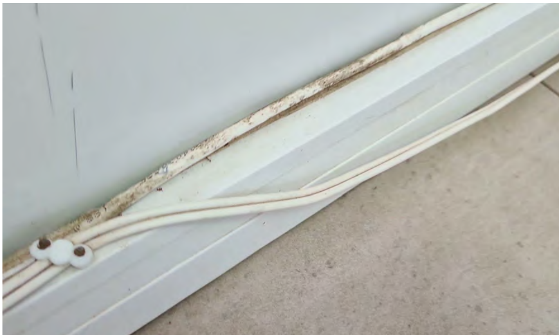
Figura 16 - Cabeamento elétrico provisório
