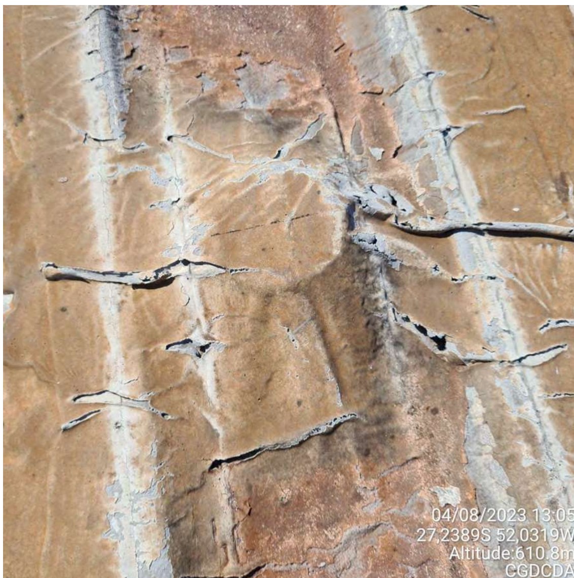
Figura 9 - Isolamento danificado
