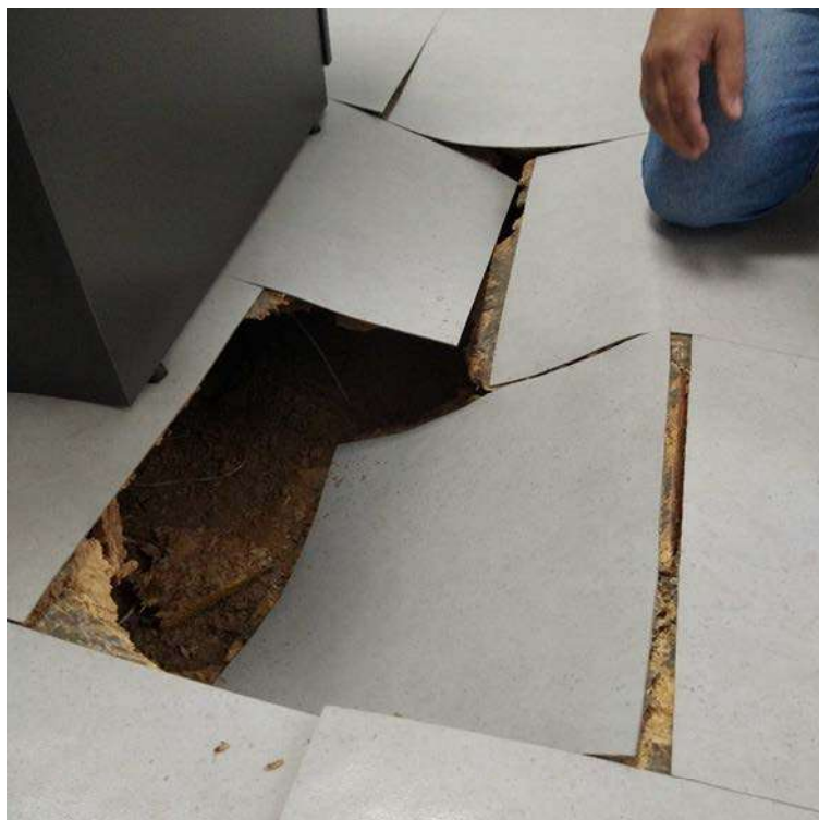
Figura 32. Piso sala Coordenador.
