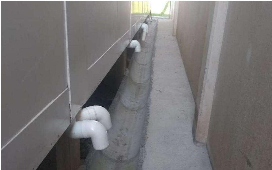
Figura 53. Coleta da água das descidas e contrapiso.
