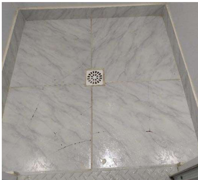
Figura 40. Piso cerâmico do box anexo ao dormitório.
