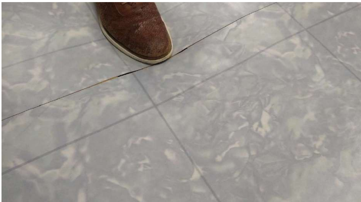
Figura 30. Perda de resistência da placa OSB.
