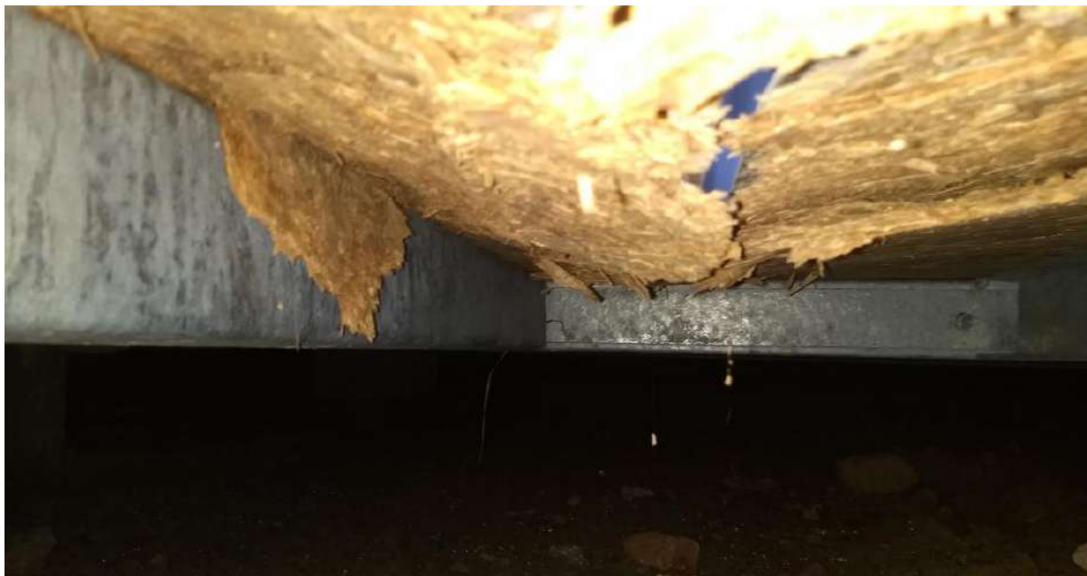
Distância de 50 a 200mm entre o solo e o OSB
