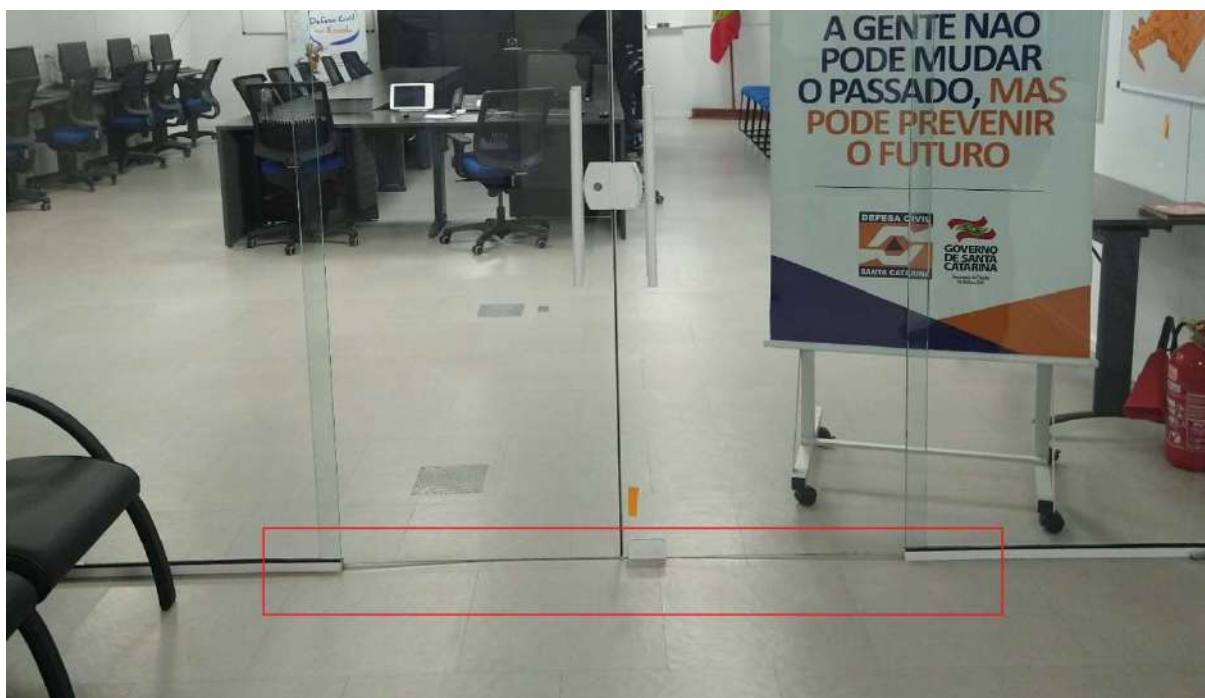
Figura 41. Levantamento do piso na porta da sala de situação.
