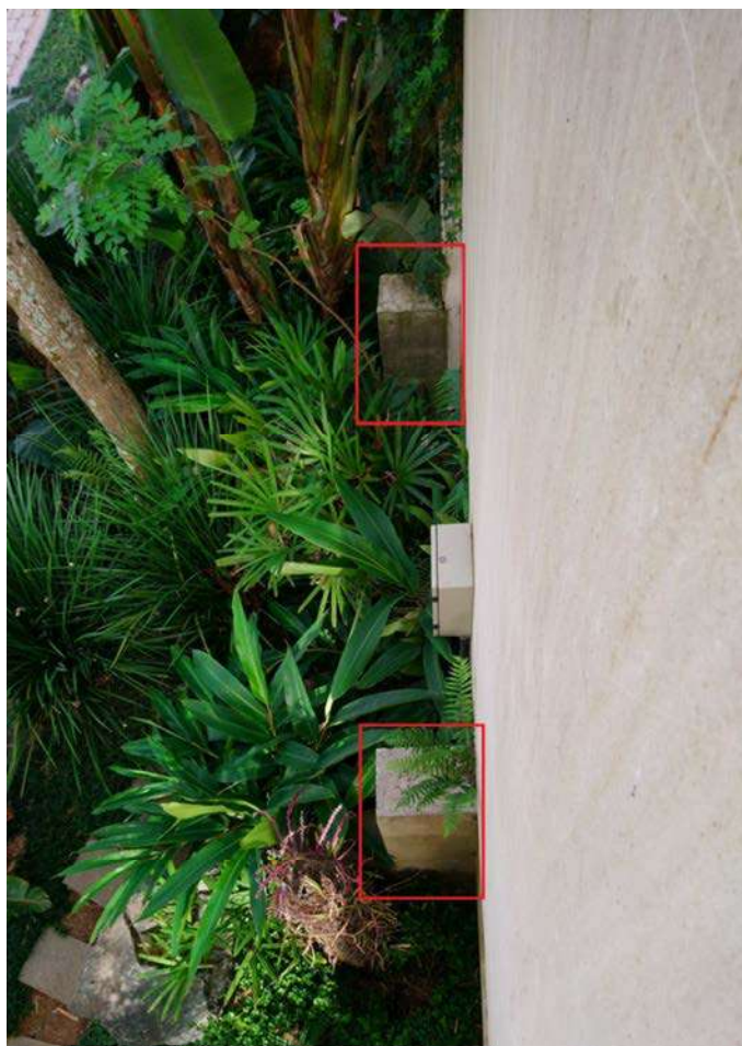
Figura 54. Colunas de travamento do muro – vista superior.
