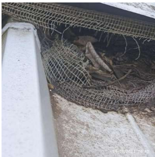
Figuras 11 e 12. Cumeeira metálica enviesada e tela rasgada.
