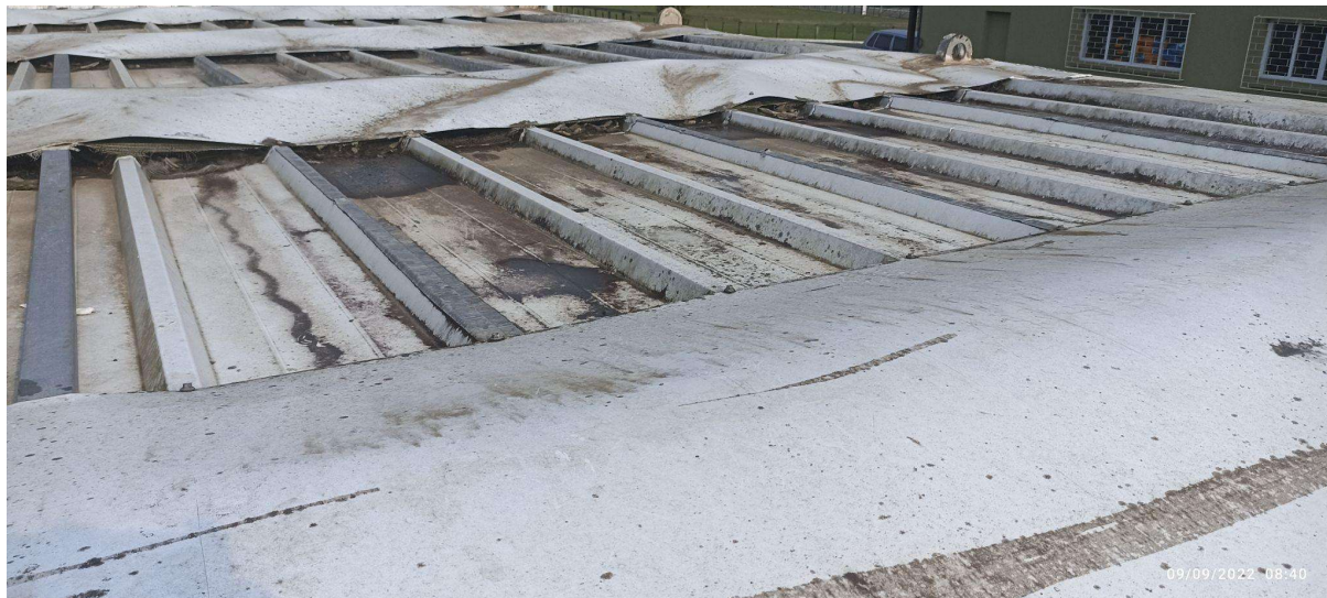
Figura 10. Cobertura, Cumeeira metálica, autores
