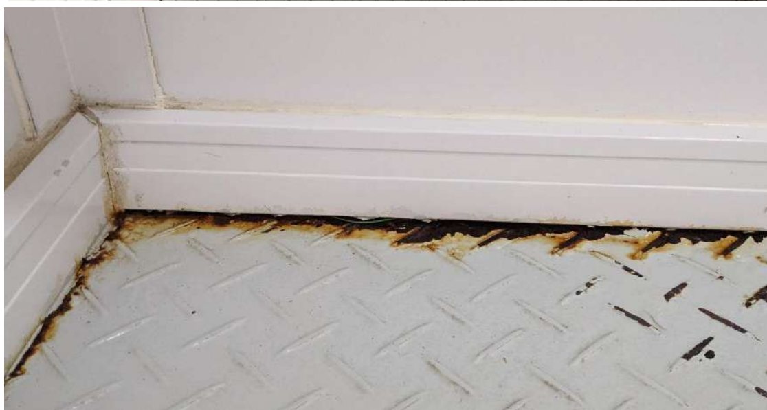
Figura 22. A infiltração vem acelerando o surgimento de ferrugem no piso xadrez, autores.
