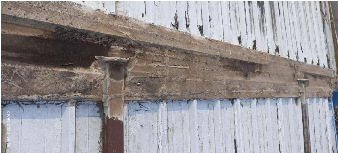
Figura 9. Piso da laje da cobertura, autores
