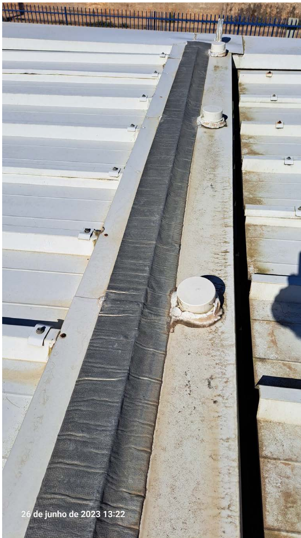
Figura 5 - Cobertura metálica - Detalhe da manta aluminizada, visando estanca as infiltrações entre os módulos
