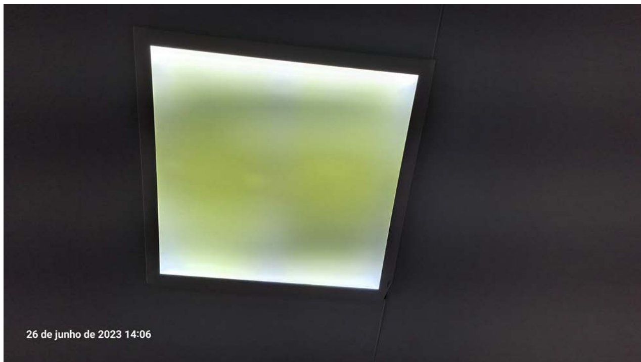
Figura 21 - Luminária com mancha d'água
