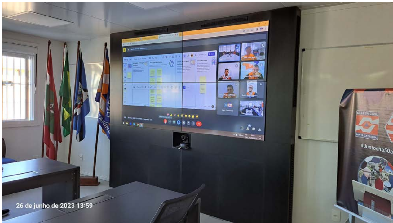
Figura 24 - Painéis sujeitos a danos em função das infiltrações
