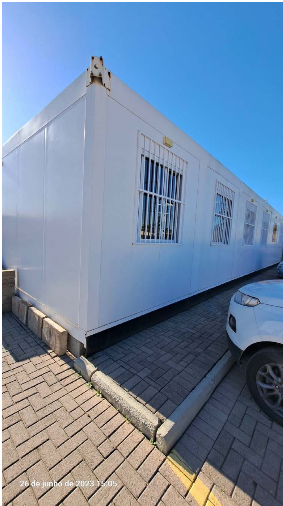
Figura 8 – Ferrugem nos cantos da edificação
