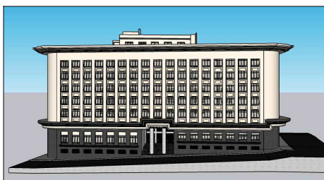
FACHADA FRONTAL - RUA TENENTE SILVEIRA
