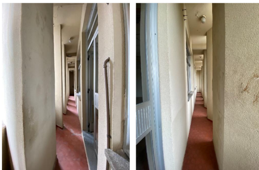
Figura 2 - Visão geral da sacada
