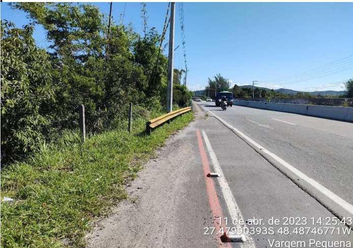
FOTO 11 - Interrupção de ciclofaixa devido à ponte estreita
