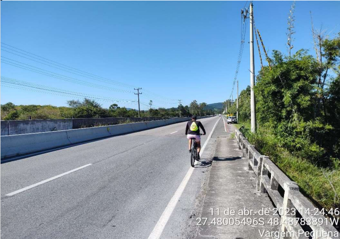
FOTO 09 - Tráfego inadequado de ciclista em razão do estreitamento de pista (antes da instalação da barreira)
