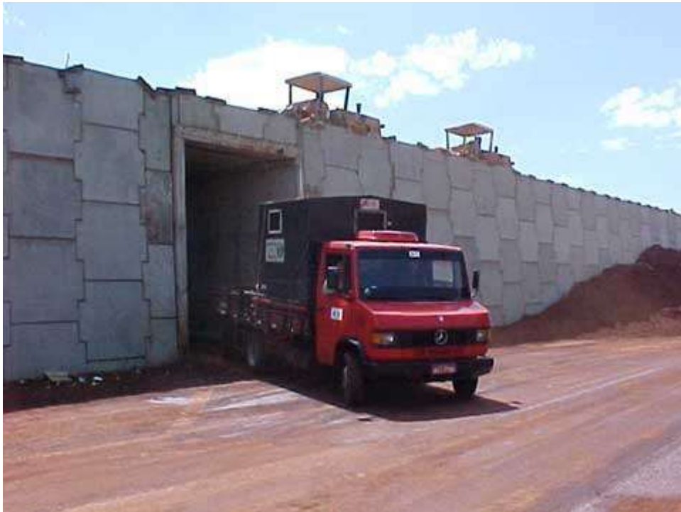
Figura 8: Vista de uma obra em Terra Armada em final de execução.
