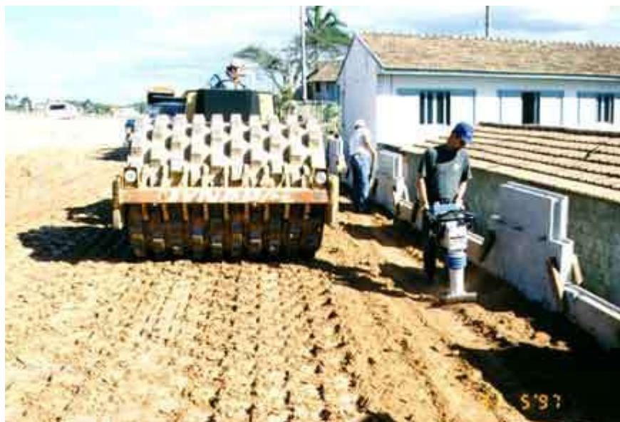
Figura 7: Detalhe da compactação manual e mecanizada.
