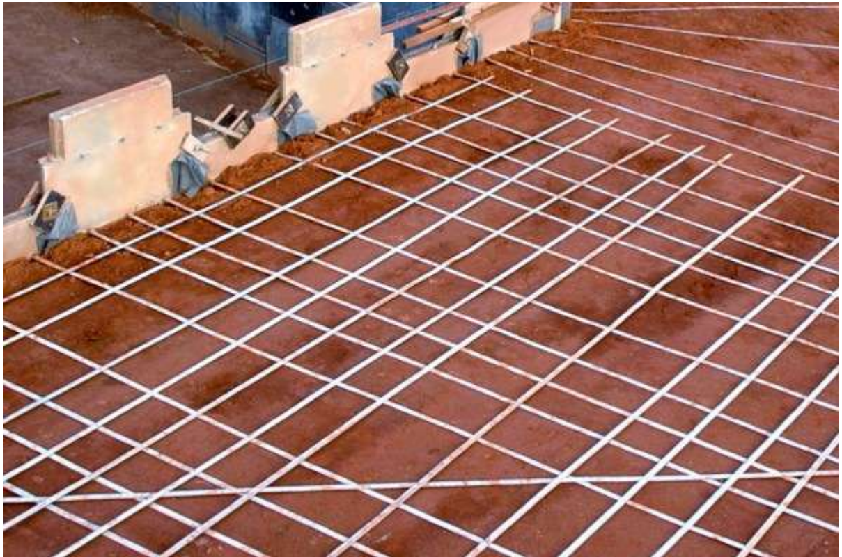
Figura 6: Detalhe das armaduras na região dos encontros de OAE's.
