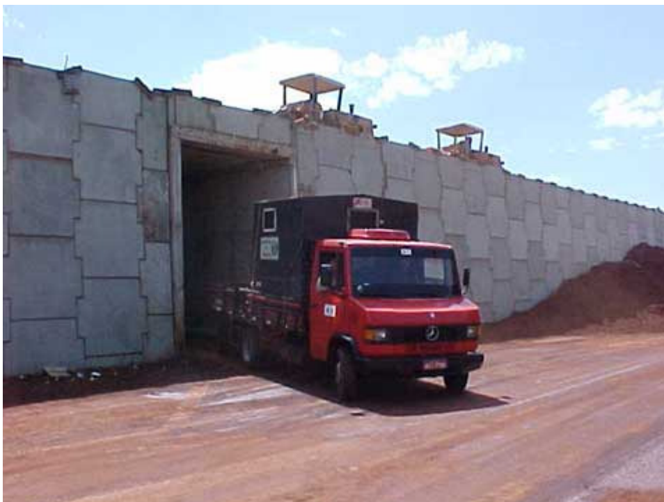
Figura 7: Vista de uma obra em Terra Armada em final de execução.
