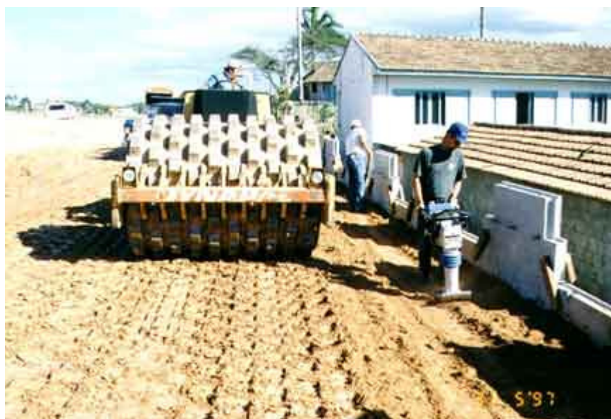
Figura 6: Detalhe da compactação manual e mecanizada.
