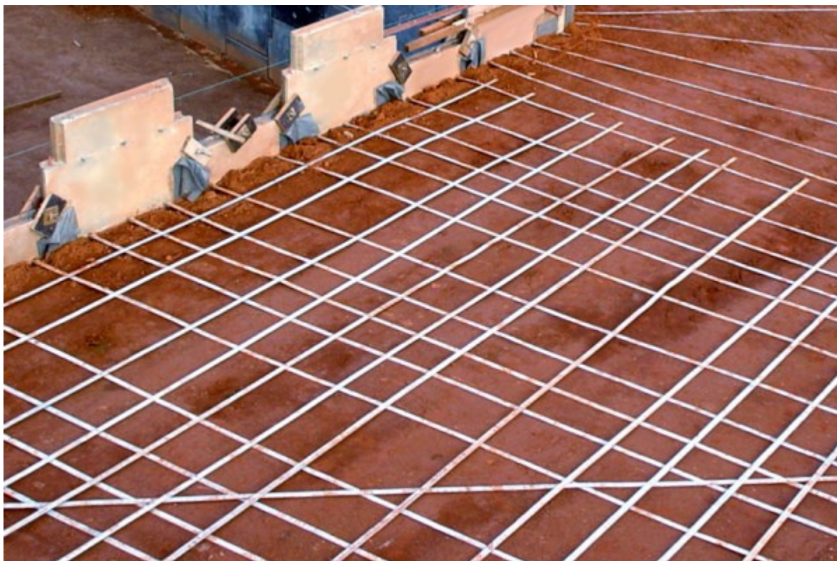
Figura 5: Detalhe das armaduras na região dos encontros de OAE's.
