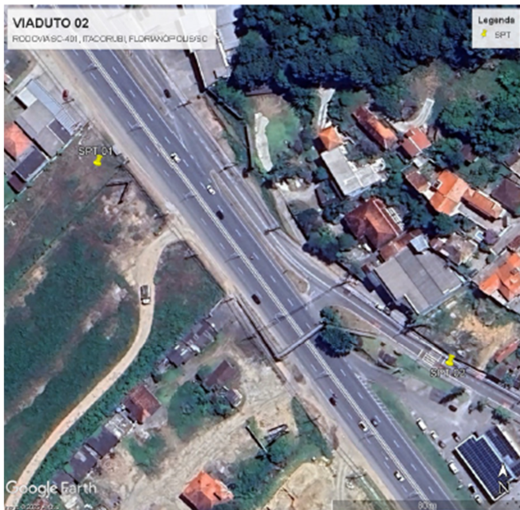
Figura 2: Localização das Sondagens SPT realizadas.
