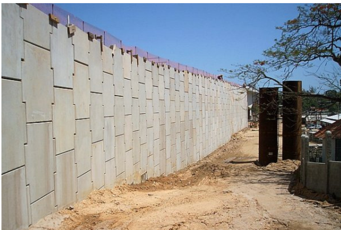
Figura 8: Vista frontal de um muro finalizado.
