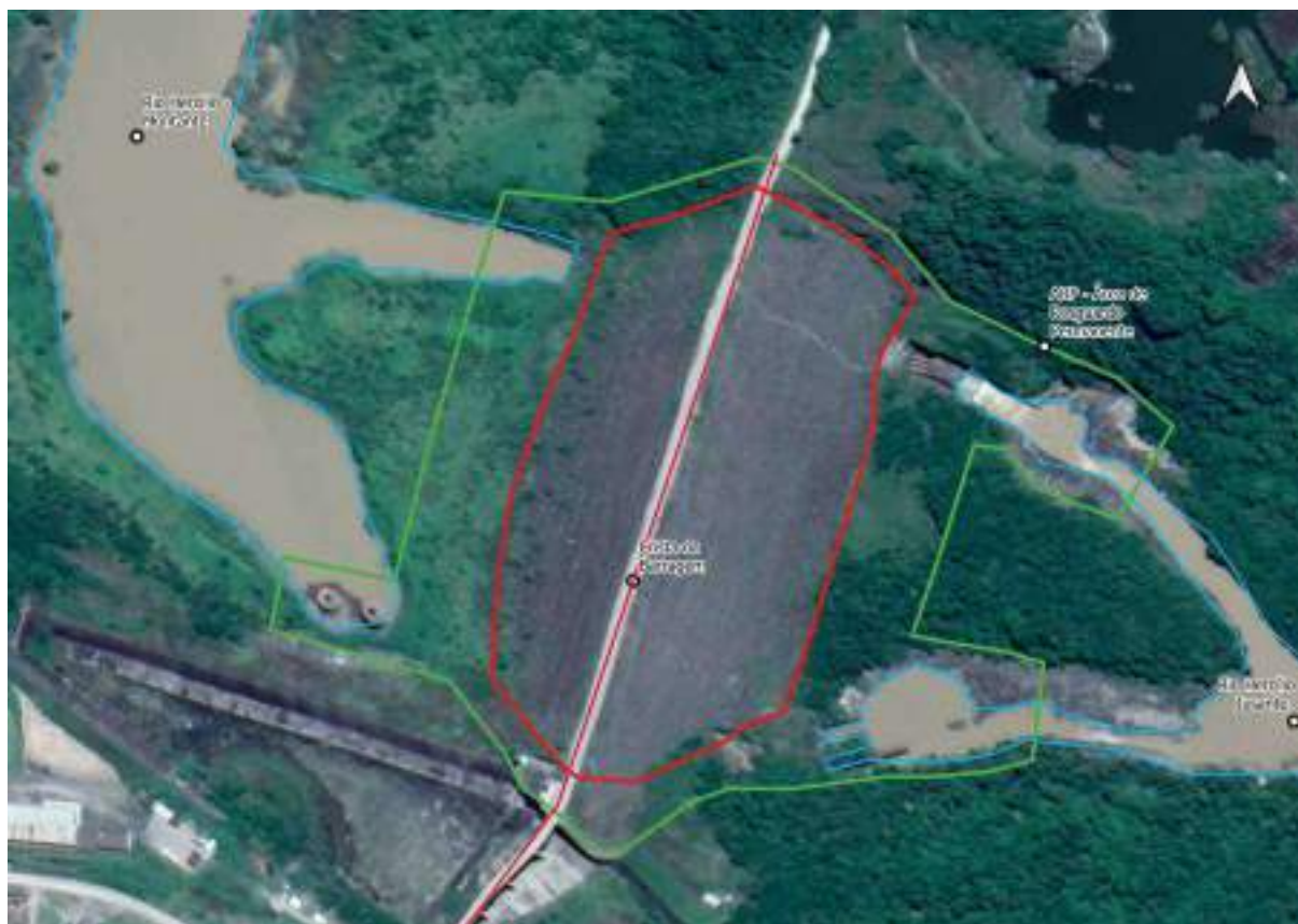
Figura 8.1-2 - Arranjo Geral Esquemático – ARP – Área de Resguardo Permanente da Barragem (Imagem Google Earth)
