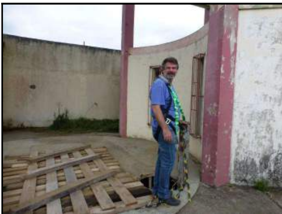
Foto 98 – Fechamento Provisório da abertura de carga e descarga do Poço de Acesso à Galeria das Comportas.
