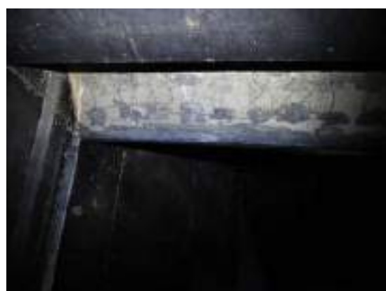
Foto 26 – Parte Inferior da comporta do Túnel Interno.
