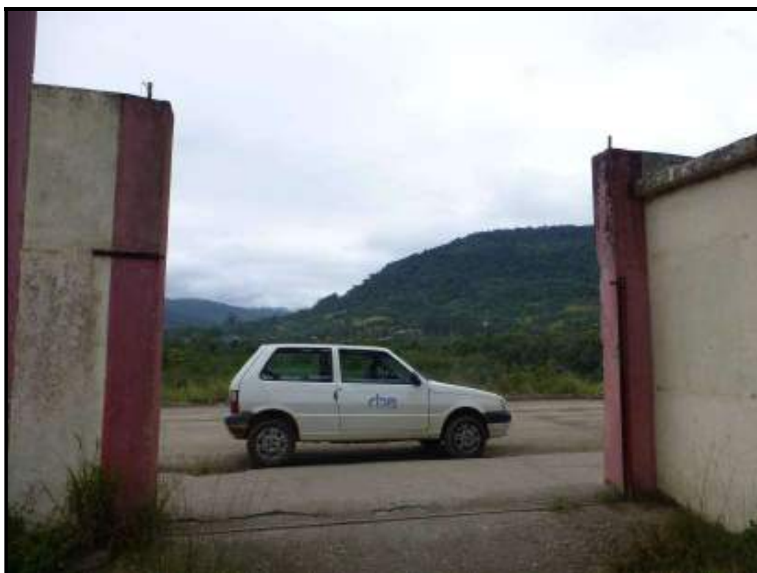
Foto 47 – Ausência de Portão da Plataforma de Operação das Comportas(devido às depredações ocorridas)
