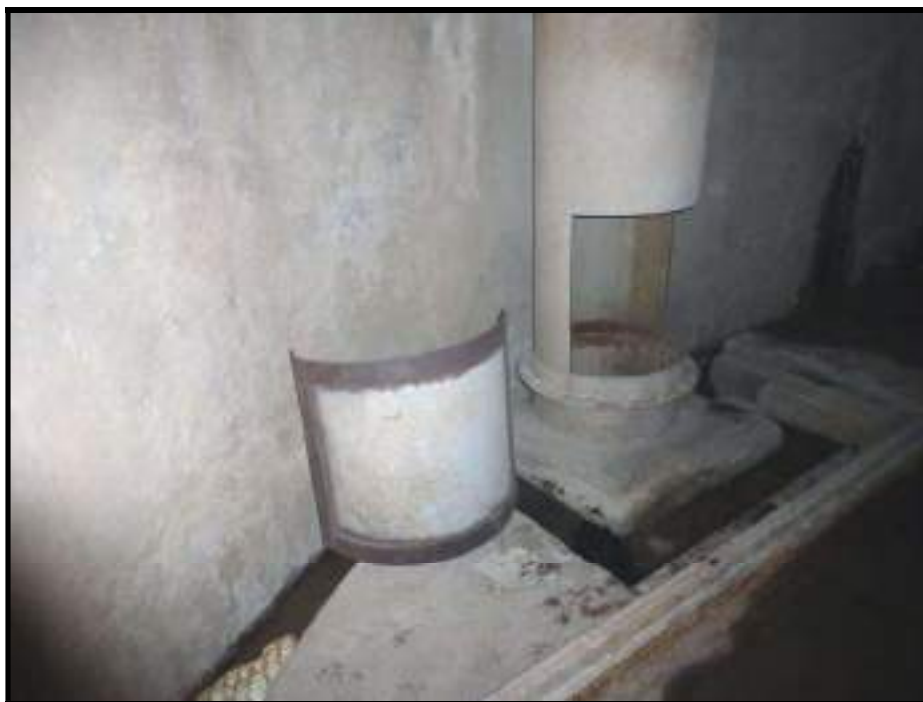
Foto 82 – “Janela” do Duto de Aeração da Comporta Deslizante Esquerda
