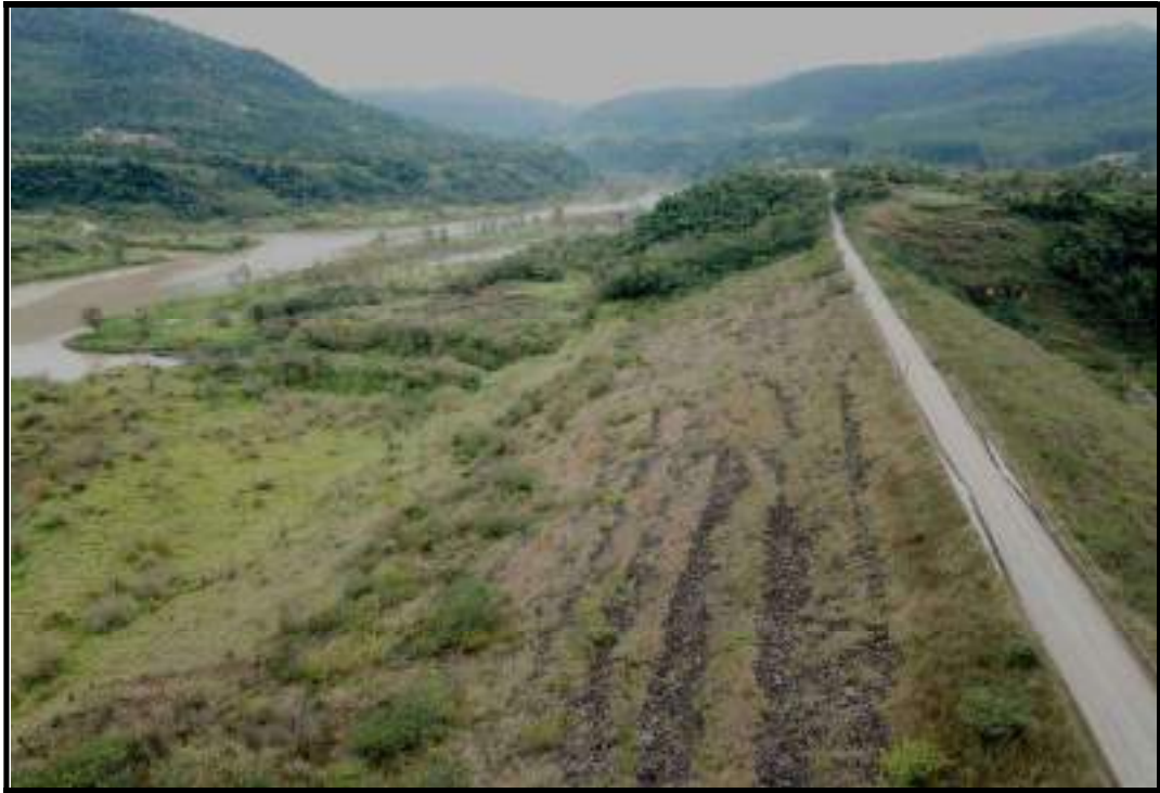
Foto 1 - Vista Geral do Talude de Montante com Vegetações Arbustiva e Gramínea
