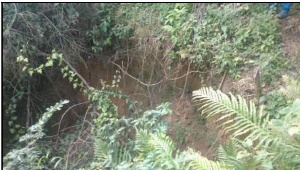
Foto 55 - Erosão em estrada de serviço abandonada da margem esquerda coord.: 26°53'30.60"S, 49°40'31.10"O.
