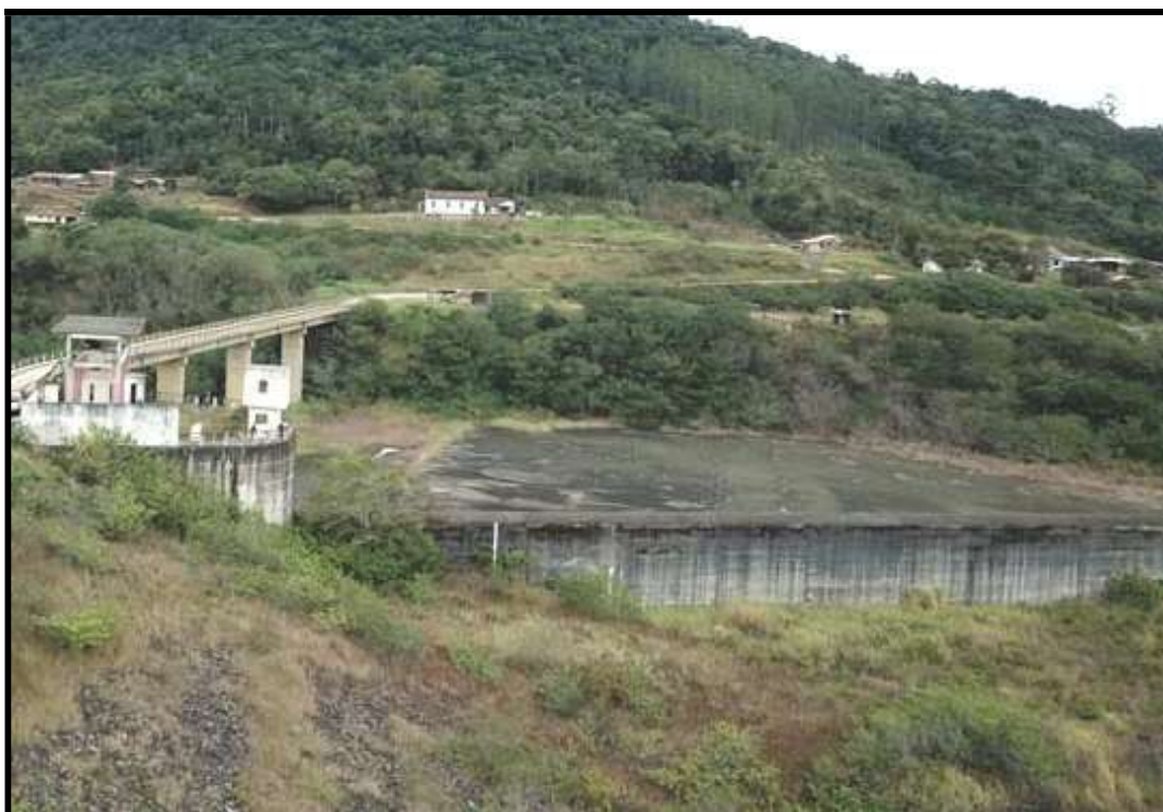
Foto 8 – Montante da Ombreira Esquerda, com a Porção Inferior em Terreno Natural, com Presença de Árvores e Arbustos
