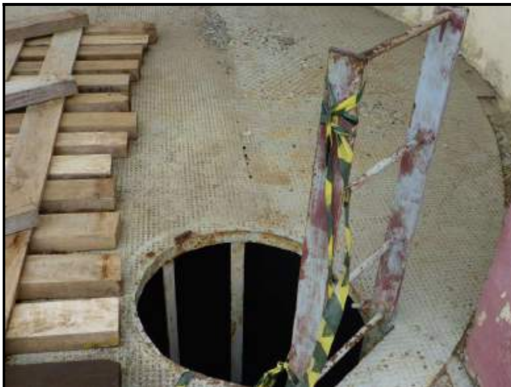
Foto 100 – Boca de Acesso à Escada de Marinheiro do poço de acesso à Galeria das Comportas
