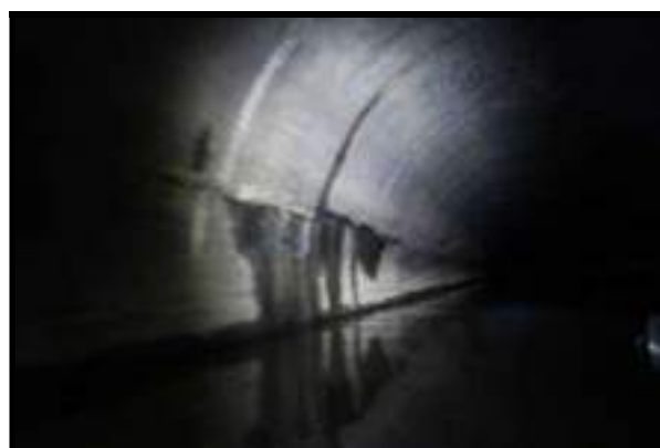
Foto 24 – Infiltração em junta horizontal de construção próximo a boca de saída.
