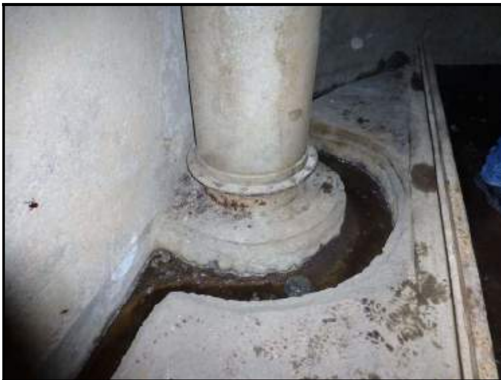
Foto 86 – Canaleta de Drenagem da Galeria das Comportas Deslizantes
