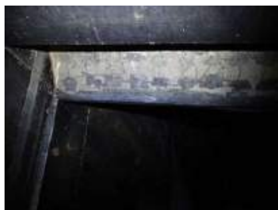
Foto 26 – Parte Inferior da comporta do Túnel Interno.
