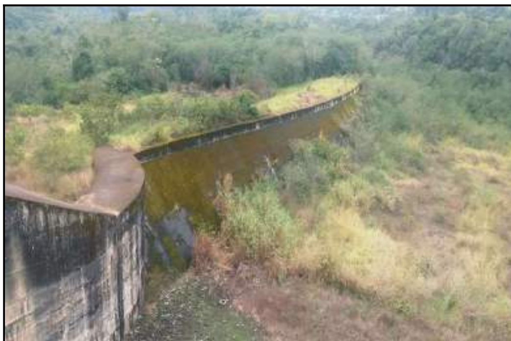
Foto 13 - Muro Lateral Esquerdo do Canal de Restituição com Vegetação de Pequeno e Médio Portes
