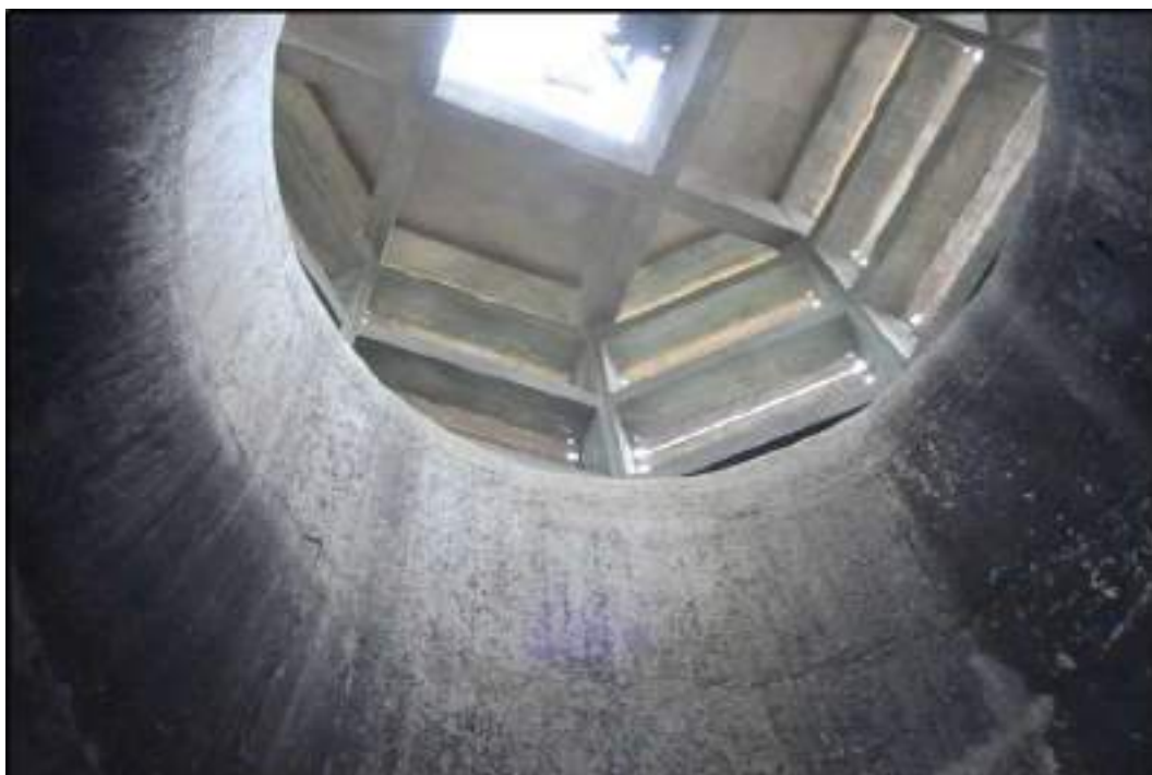
Foto 37 – Parte Interna da Estrutura de Emboque Tipo Tulipa do Túnel Direito (túnel externo - em bom estado)
