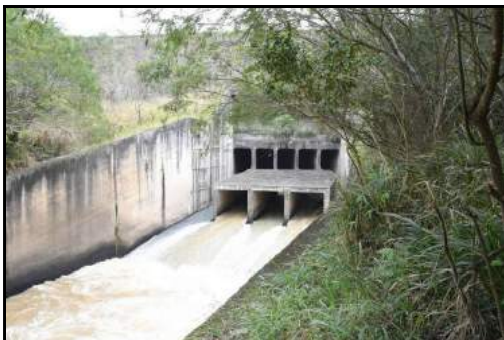
Foto 17 - Vista de jusante da Estrutura de Saída da Galeria de Descarga com presença de Árvores e Arbustos junto à Parede Laterais do Canal de Restituição
