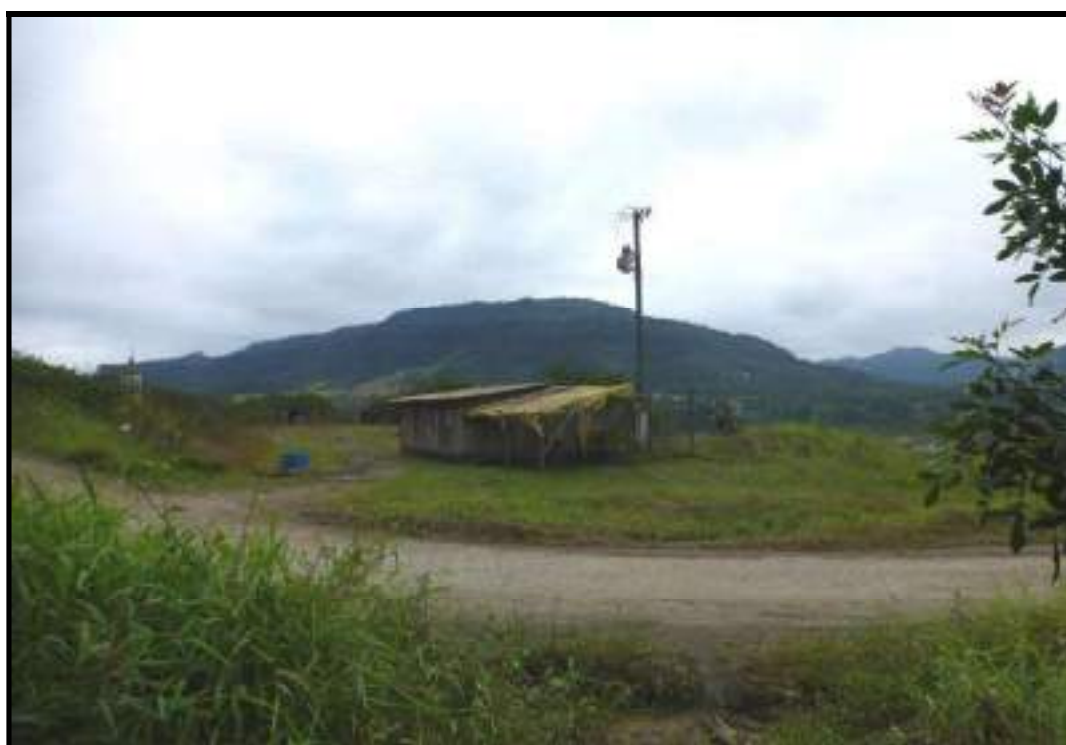
Foto 9 - Construção Irregular na Ombreira Direita, junto à Ponte sobre o Canal do Vertedouro
