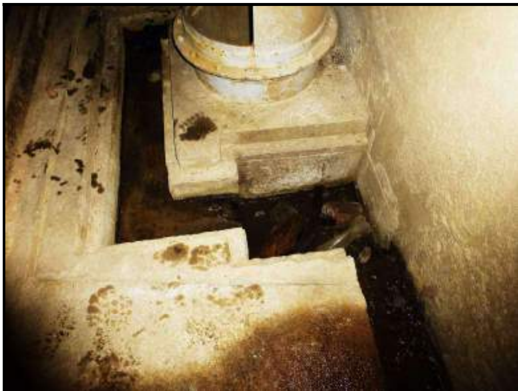
Foto 83 – “Janela” do Duto de Aeração da Comporta Deslizante Esquerda
