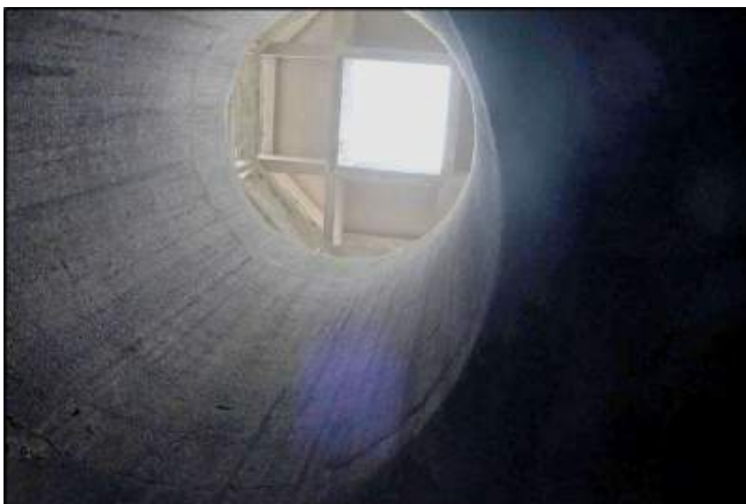
Foto 34 – Parte Interna da Estrutura de Emboque do Túnel Esquerdo (em bom estado)
