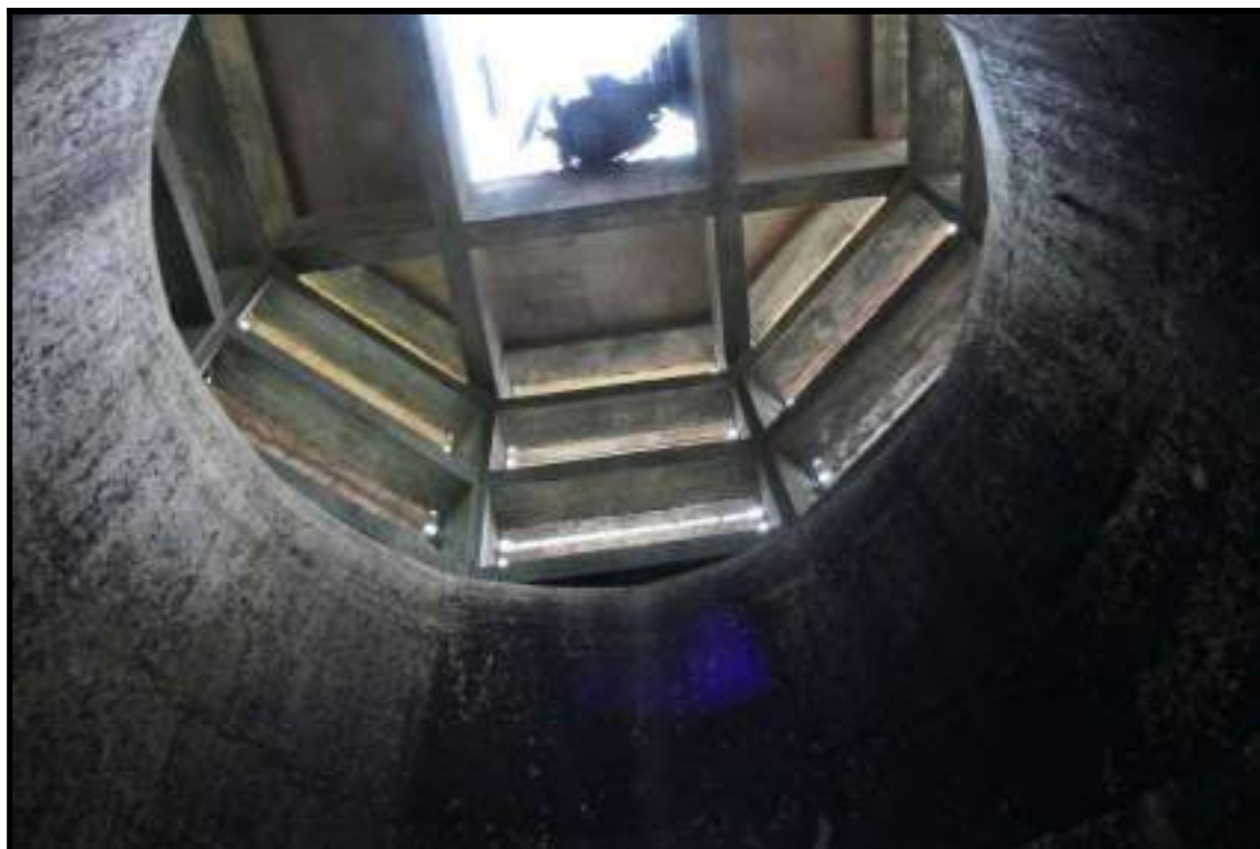
Foto 93 –Vista Inferior da Grade da Laje Superior da Estrutura de Emboque Tipo Tulipa do Túnel Externo de Descarga (Direito)
