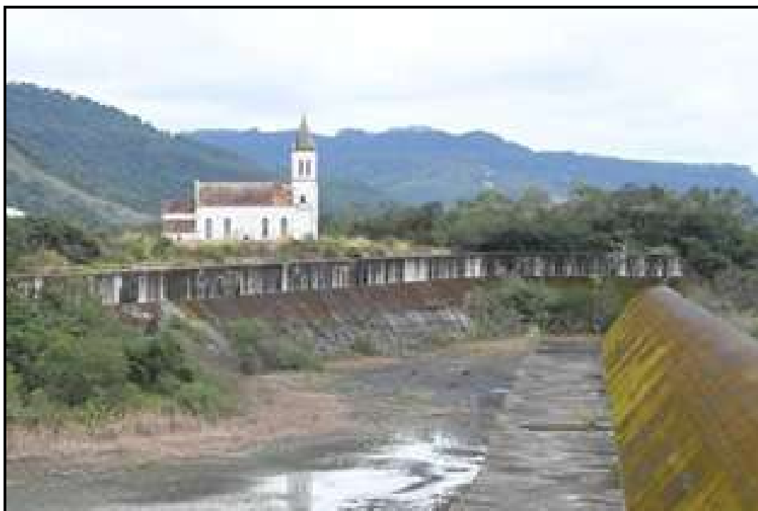
Foto 11 – Vista do Muro de Contenção do Canal de Restituição com Vegetação de Médio Porte
