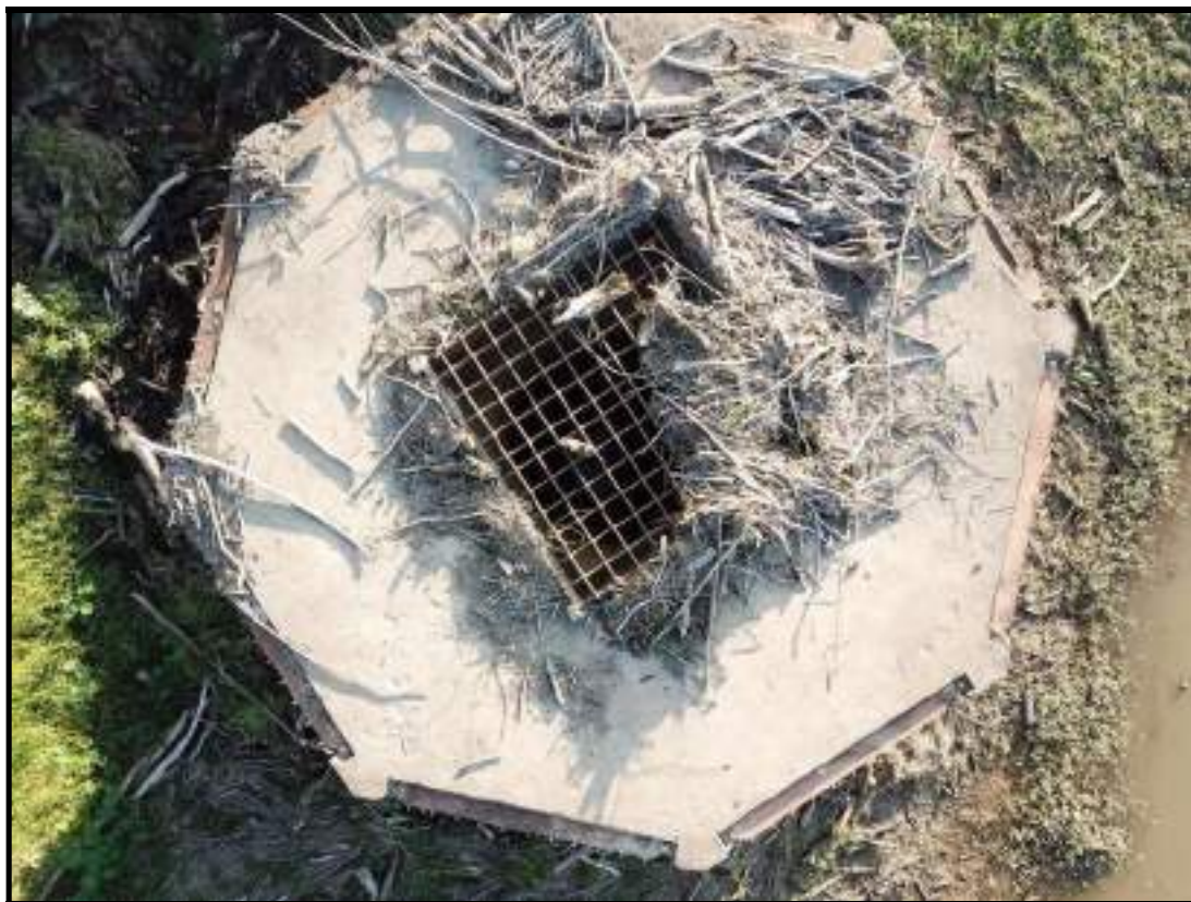
Foto 92 –Grade da Laje Superior da Estrutura de Emboque Tipo Tulipa do Túnel Externo de Descarga (Direito)
