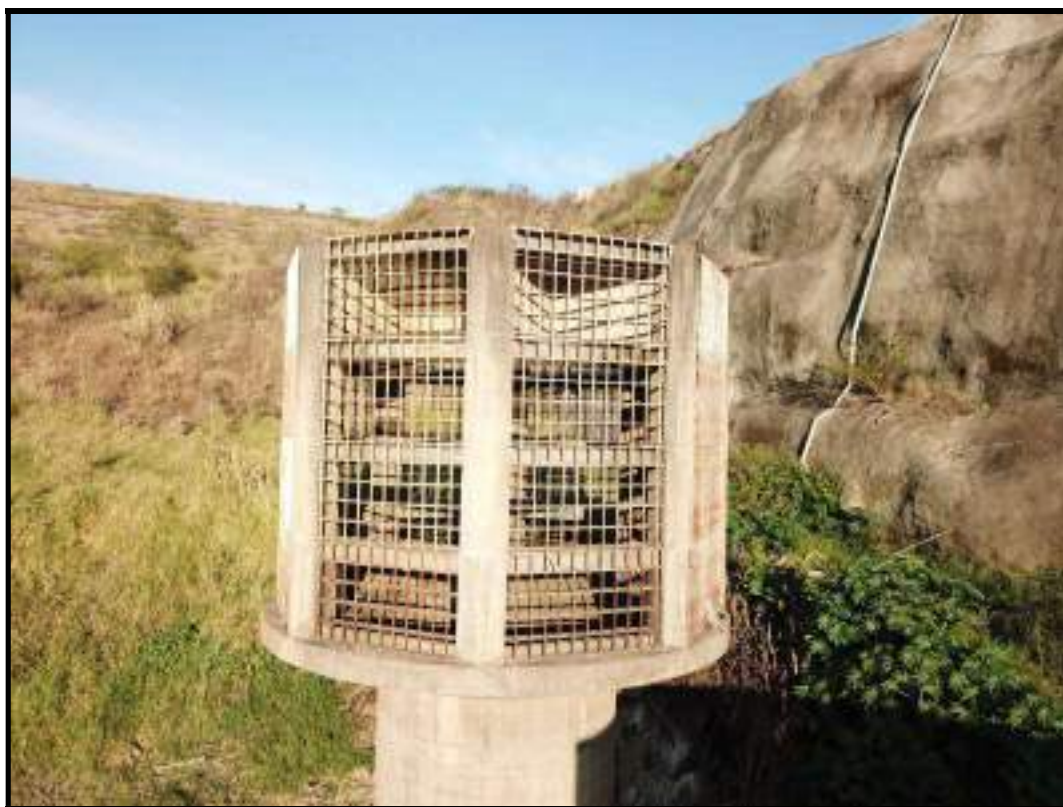
Foto 88 – Estruturas de emboque tipo tulipa do túnel de descarga esquerdo
