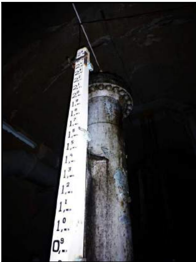
Foto 79 – Régua de Medição da Abertura da Comporta situada na Galeria das Comportas Deslizantes
