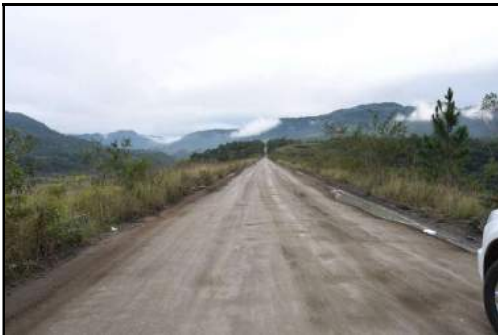
Foto 3 - Vista Geral da Crista com Presença de Depressões e Problemas de Drenagem
