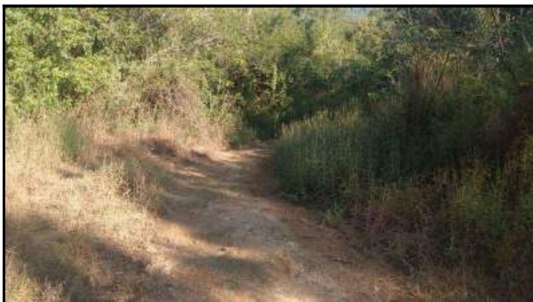
Foto 53 - Trecho a ser recuperado da estrada a jusante da barragem, na margem esquerda (coord.: 26°53'23.90"S, 49°40'22.01"O).
