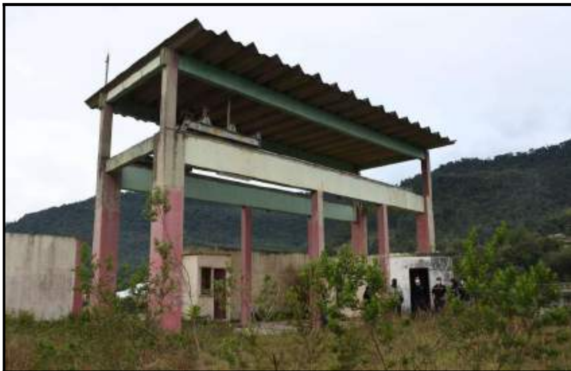
Foto 42 – Estrutura de Concreto da Ponte Rolante de Manutenção das Comportas
