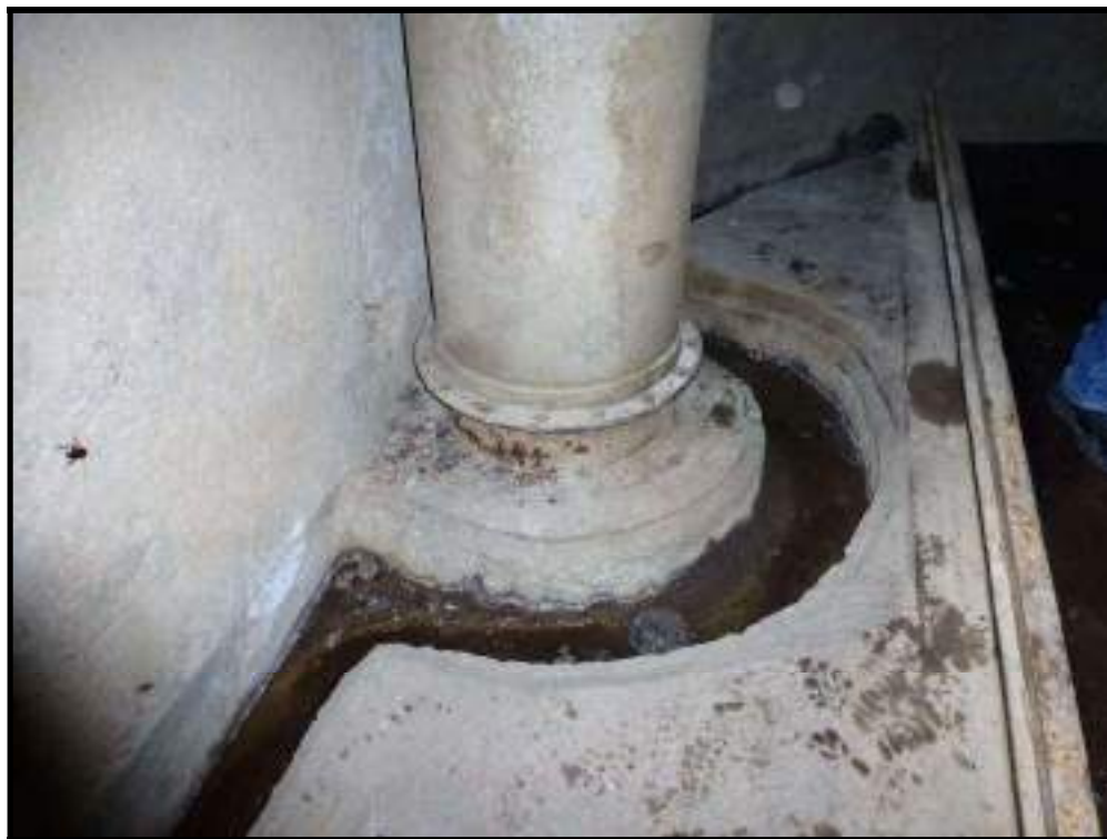
Foto 85 – “Janela” do Duto de Aeração da Comporta Deslizante Direita
