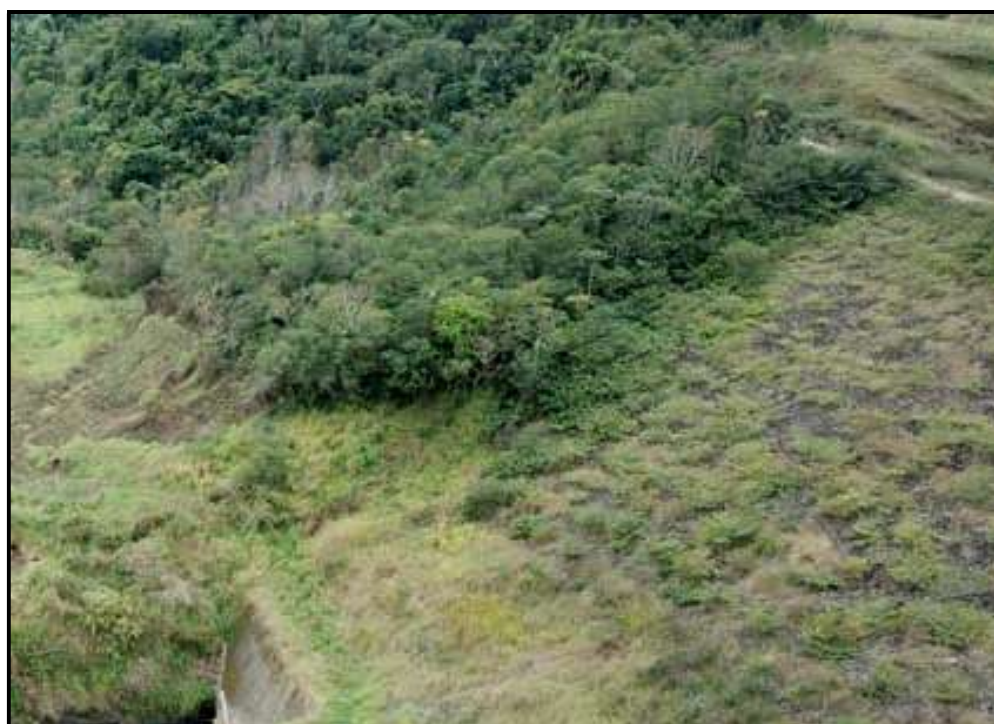
Foto 6 – Montante da Ombreira Esquerda com Presença de Vegetação Exuberante
