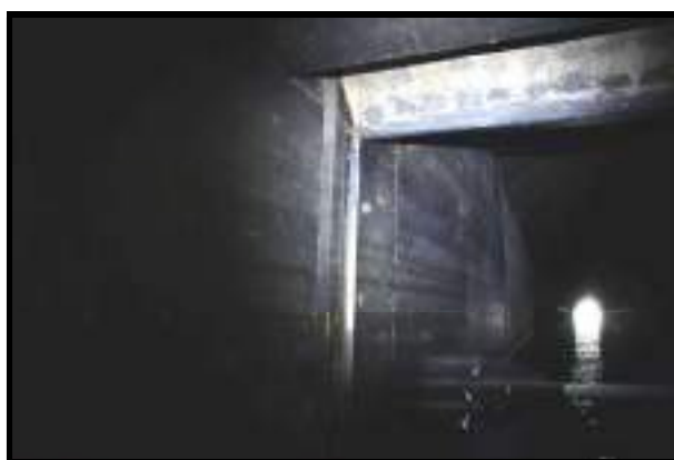
Foto 25 – Batente do Túnel Interno em bom estado.
