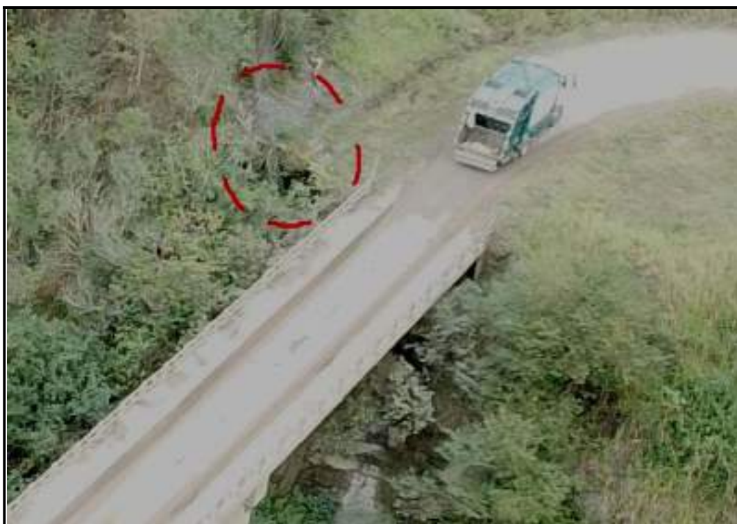
Foto 50 – Vista geral do encontro direto da ponte com drenagem da estrada terminando no talude.
