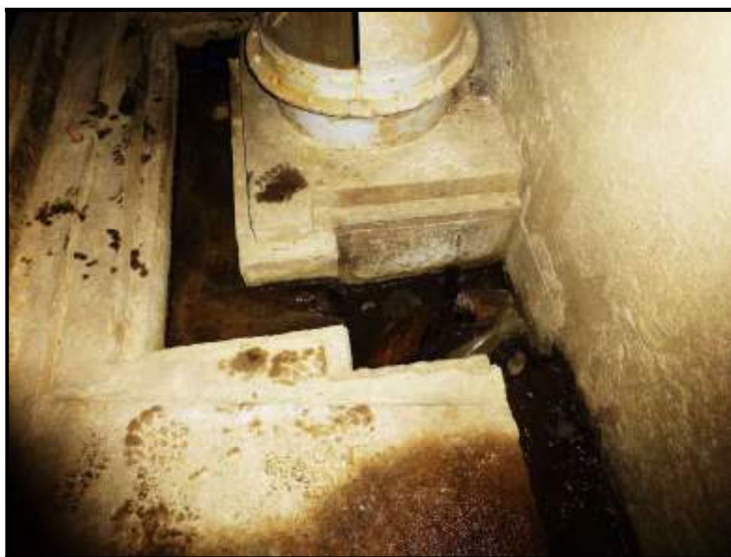
Foto 85 – Canaleta e Orifício de Drenagem da Galeria das Comportas Deslizantes
