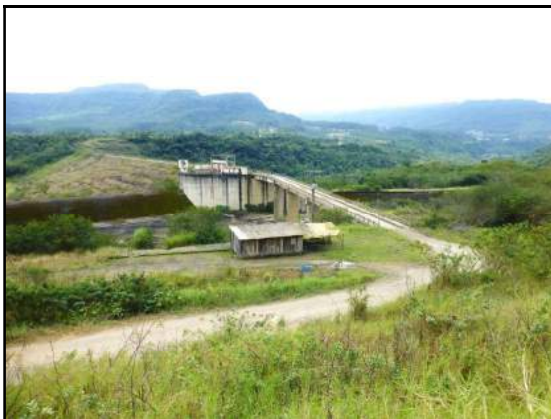
Foto 106 – Vista Geral da Barragem e Posto de Transformação/Medição de Energia Elétrica
