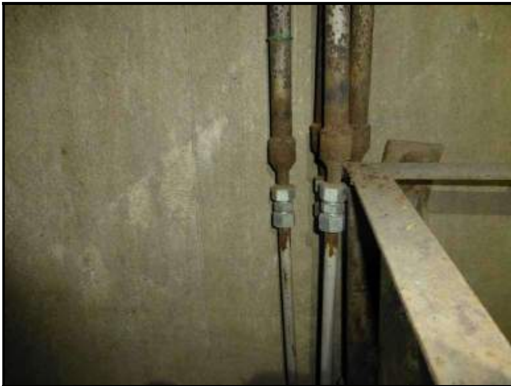
Foto 72 – Condutores Metálicos de Óleo do Sistema Óleo-Hidráulico de Acionamento das Comportas em Bom Estado, com Necessidade Manutenção e Pintura.
