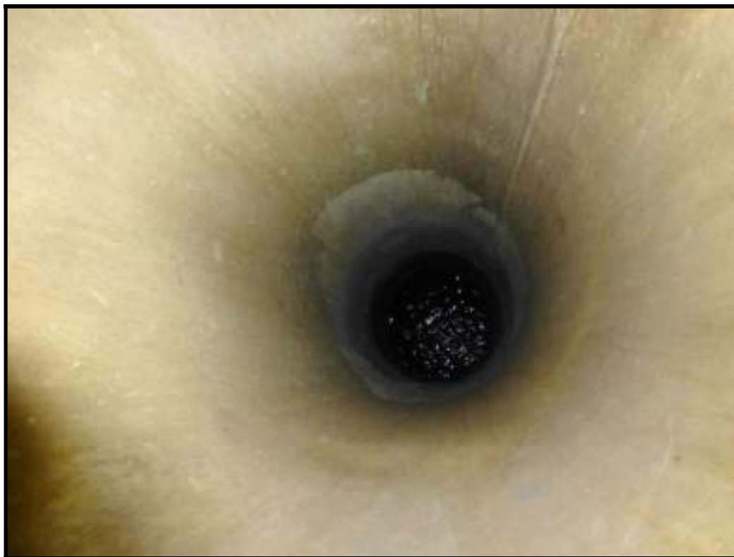
Foto 84 – “Poço” do Duto de Aeração da Comporta Deslizante Esquerda
