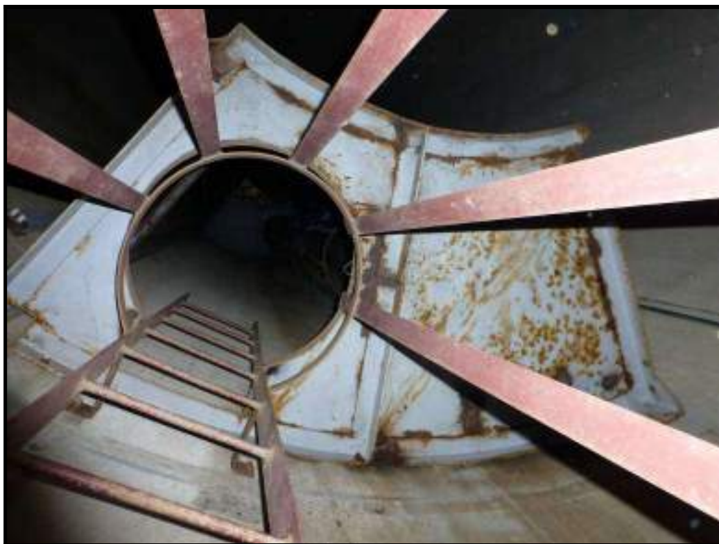
Foto 102 – Escada Tipo Marinheiro e Patamar de Descanso do Poço de Acesso à Galeria das Comportas (vista de baixo para cima)
