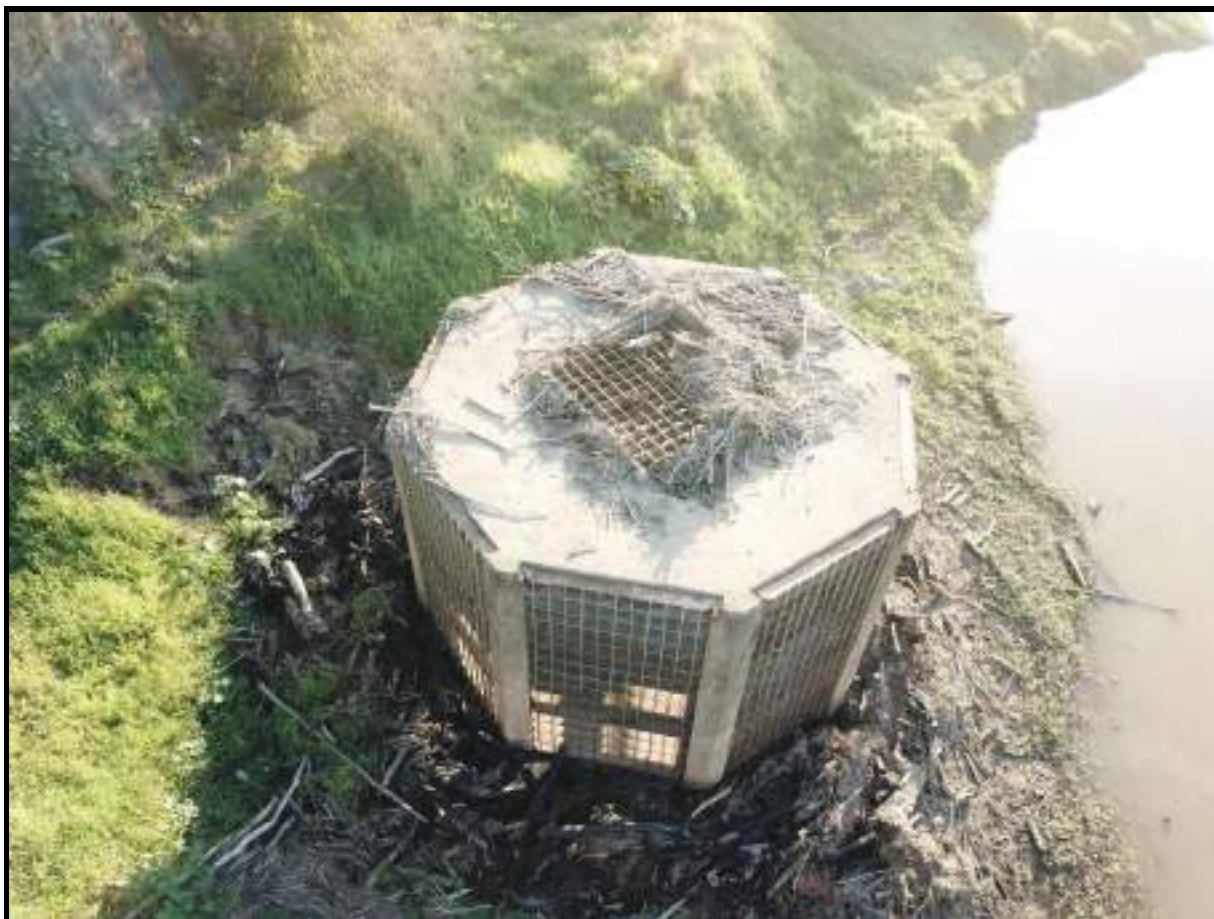
Foto 91 –Grade da Laje Superior da Estrutura de Emboque Tipo Tulipa do Túnel Externo de Descarga (Direito)
