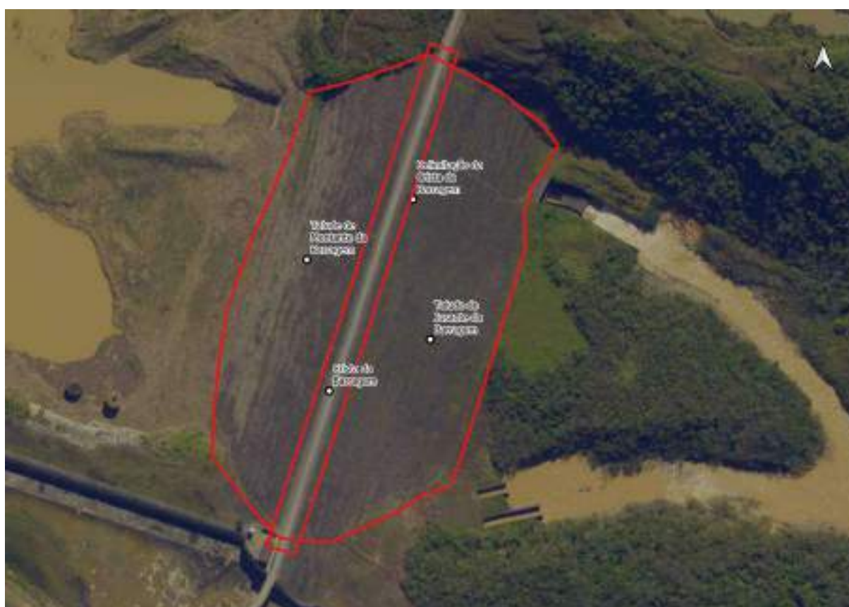
Figura 8.1-1 - Arranjo Geral Esquemático - Crista e Taludes de Montante e Jusante da Barragem (Imagem Landsat)
