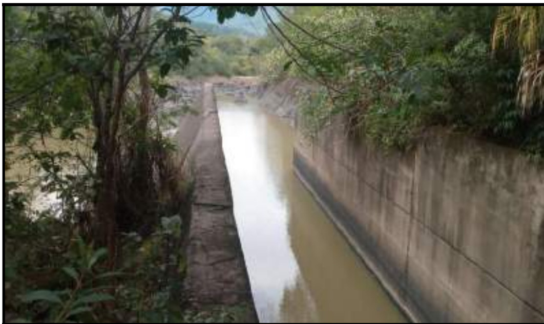
Foto 41 – Boca de Saída do Túnel Externo (com vista do talude rochoso na lateral direita da do canal escavado a jusante)
