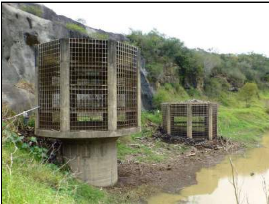
Foto 87 – Estruturas de emboque dos túneis de descarga tipo tulipa dos túneis direito e esquerdo
