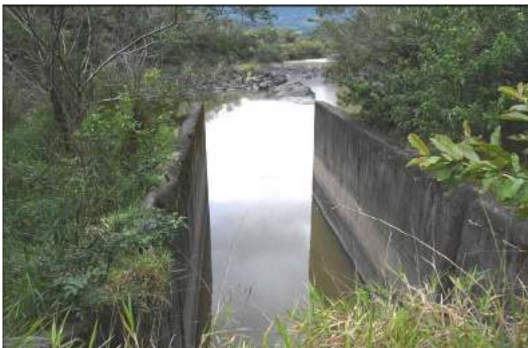
Foto 40 – Boca de Saída do Túnel Interno (com excesso de vegetação no entorno)
