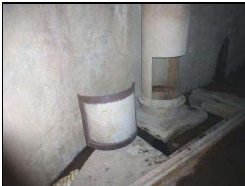
Foto 82 – “Janela” do Duto de Aeração da Comporta Deslizante Esquerda
