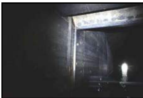
Foto 25 – Batente do Túnel Interno em bom estado.
