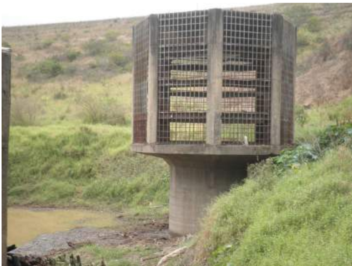
Foto 38 - Base da Estrutura de Emboque Tipo Tulipa do Túnel Interno (túnel esquerdo - em bom estado)
