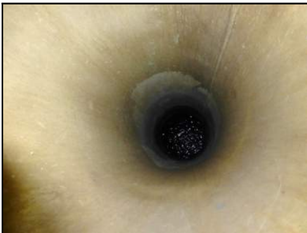
Foto 28 – “Poço” do Duto de Aeração da Comporta Deslizante Esquerda
