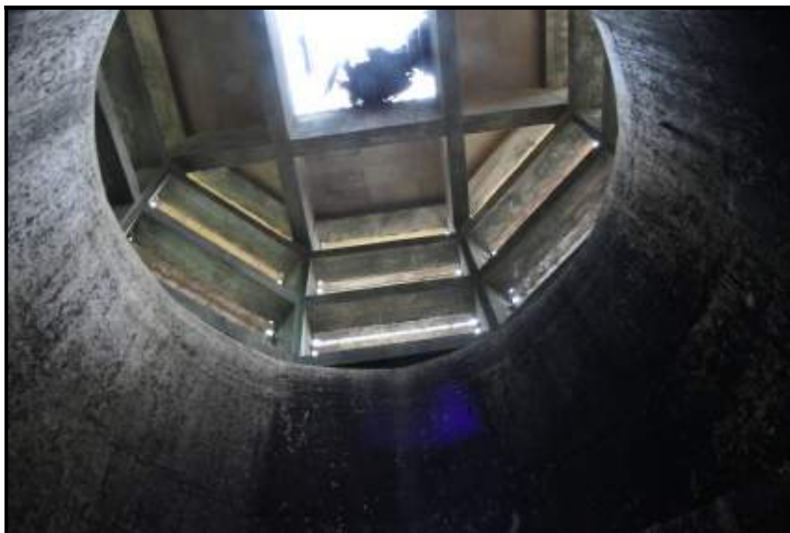
Foto 37 –Vista Inferior da Grade da Laje Superior da Estrutura de Emboque Tipo Tulipa do Túnel Externo de Descarga (Direito)
