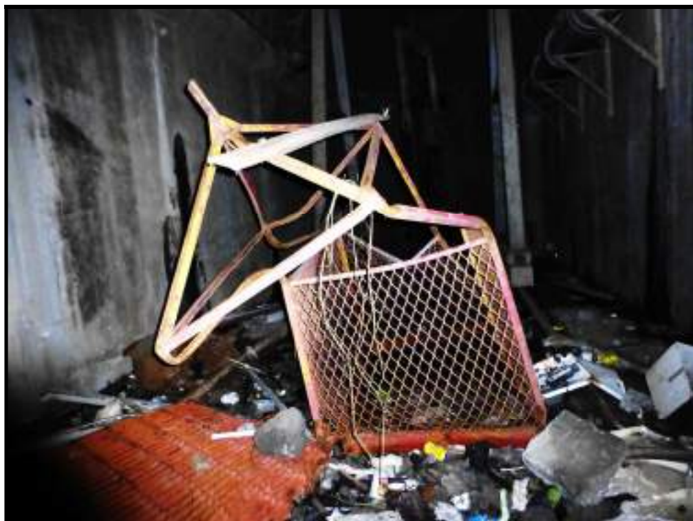
Foto 7 – Gaiola (Totalmente Depredada) de Transporte de Pequenas Cargas e Trabalhadores da Ponte Rolante Totalmente Depredada de Manutenção das Comportas
