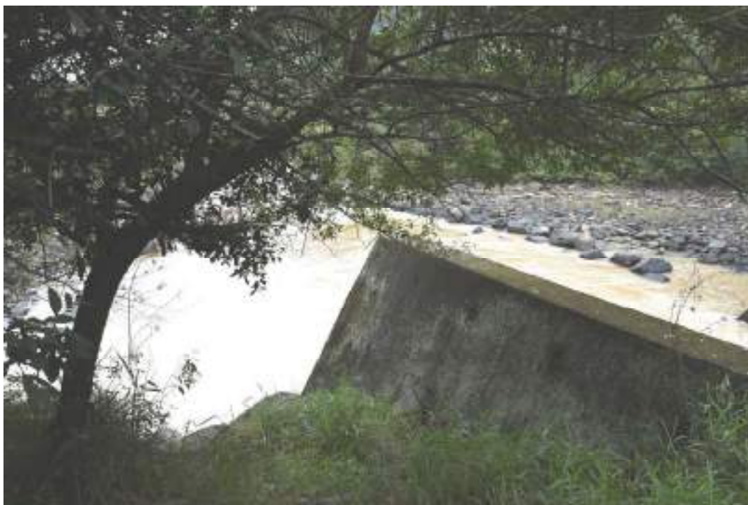
Foto 18 - Vista para Jusante da Estrutura de Saída da Galeria de Descarga
