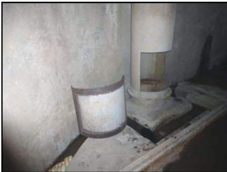
Foto 26 – “Janela” do Duto de Aeração da Comporta Deslizante Esquerda
