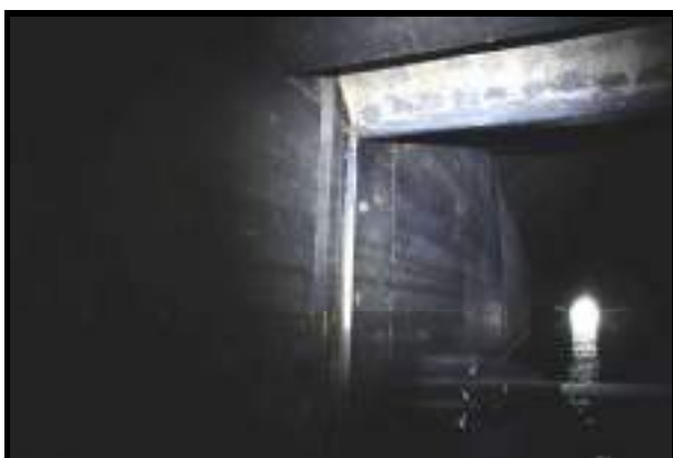
Foto 25 – Batente do Túnel Interno em bom estado.
