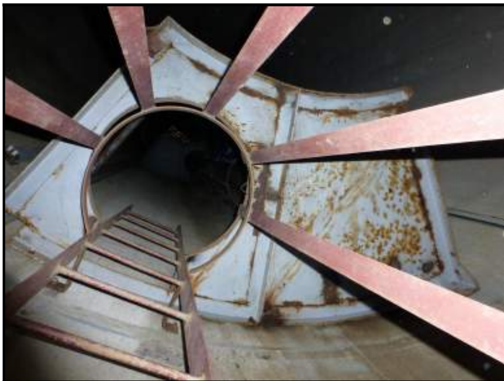
Foto 46 – Escada Tipo Marinheiro e Patamar de Descanso do Poço de Acesso à Galeria das Comportas (vista de baixo para cima)
