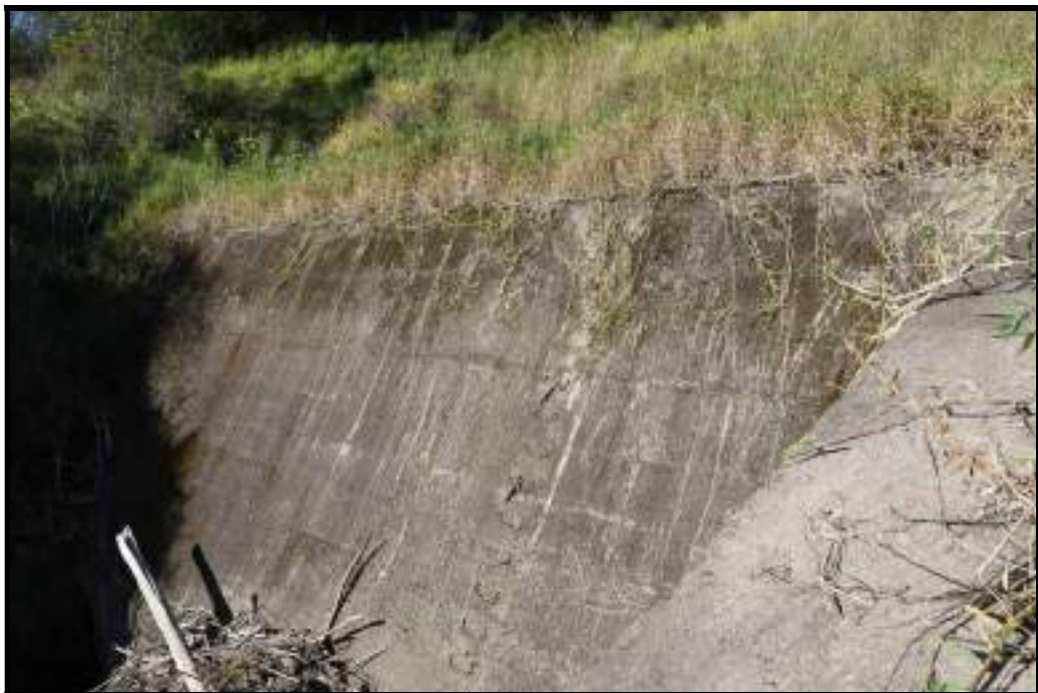
Foto 15 - Parede Lateral da Estrutura de Entrada d'Água da Galeria de Descarga (em bom estado)
