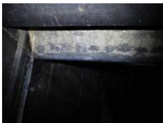
Foto 26 – Parte Inferior da comporta do Túnel Interno.
