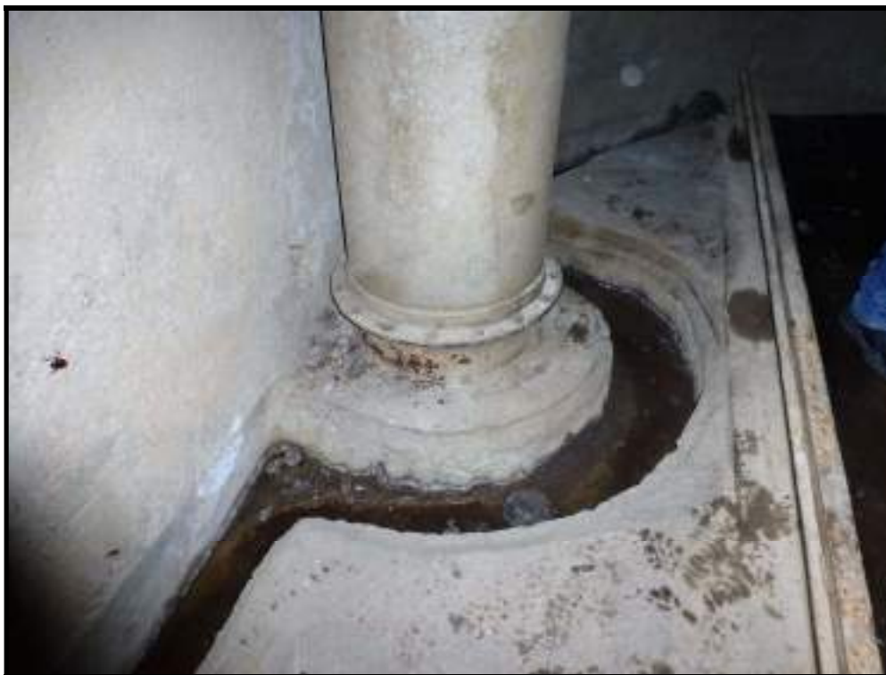
Foto 30 – Canaleta de Drenagem da Galeria das Comportas Deslizantes
