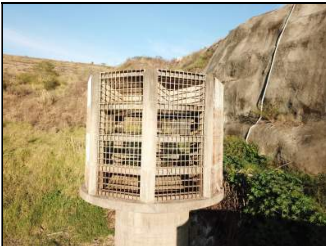
Foto 32 – Estruturas de emboque tipo tulipa do túnel de descarga esquerdo
