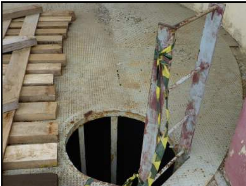
Foto 44 – Boca de Acesso à Escada de Marinheiro do poço de acesso à Galeria das Comportas
