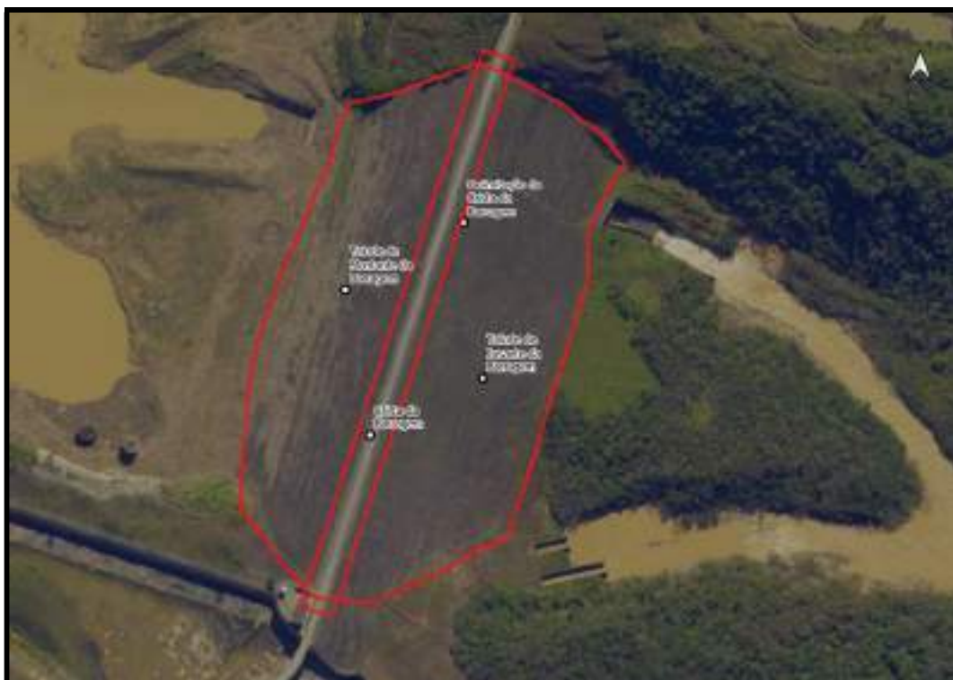
Figura 5.1-1 - Arranjo Geral Esquemático - Crista e Taludes de Montante e Jusante da Barragem (Imagem Landsat)
