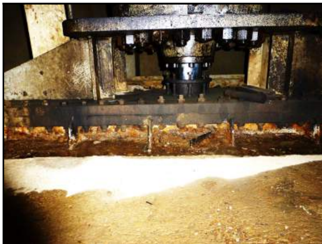
Foto 21 – Detalhe da Haste do Servomotor de Acionamento da Comporta
