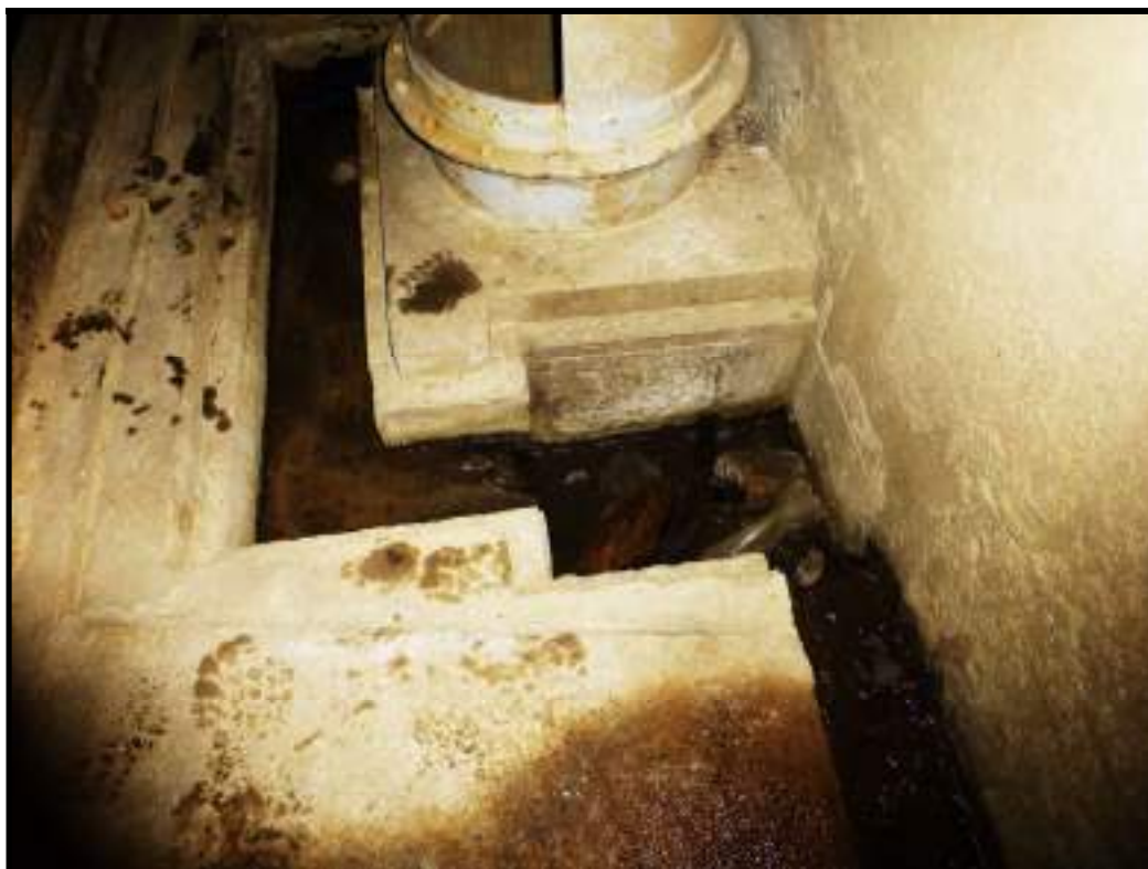
Foto 29 – Canaleta e Orifício de Drenagem da Galeria das Comportas Deslizantes
