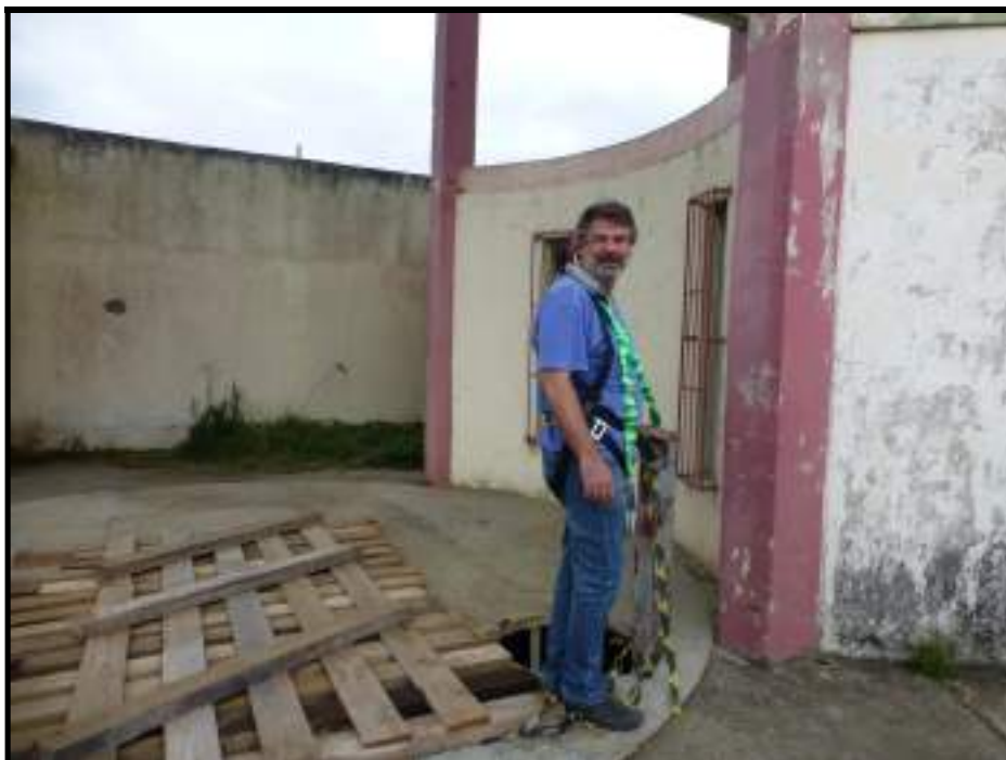
Foto 42 – Fechamento Provisório da abertura de carga e descarga do Poço de Acesso à Galeria das Comportas.
