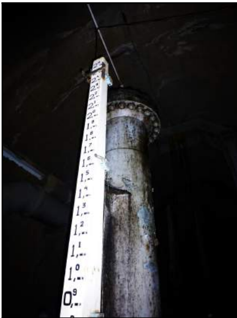
Foto 23 – Régua de Medição da Abertura da Comporta situada na Galeria das Comportas Deslizantes
