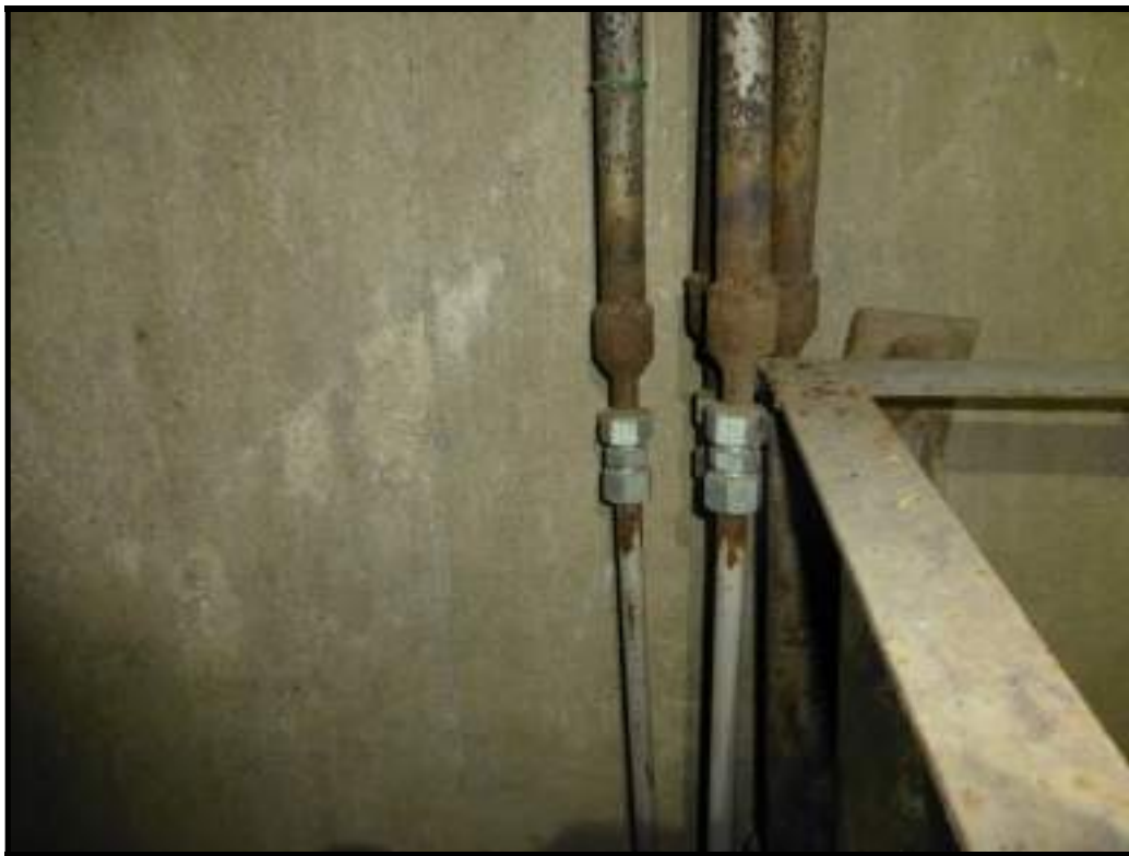
Foto 16 – Condutores Metálicos de Óleo do Sistema Óleo-Hidráulico de Acionamento das Comportas em Bom Estado, com Necessidade Manutenção e Pintura.
