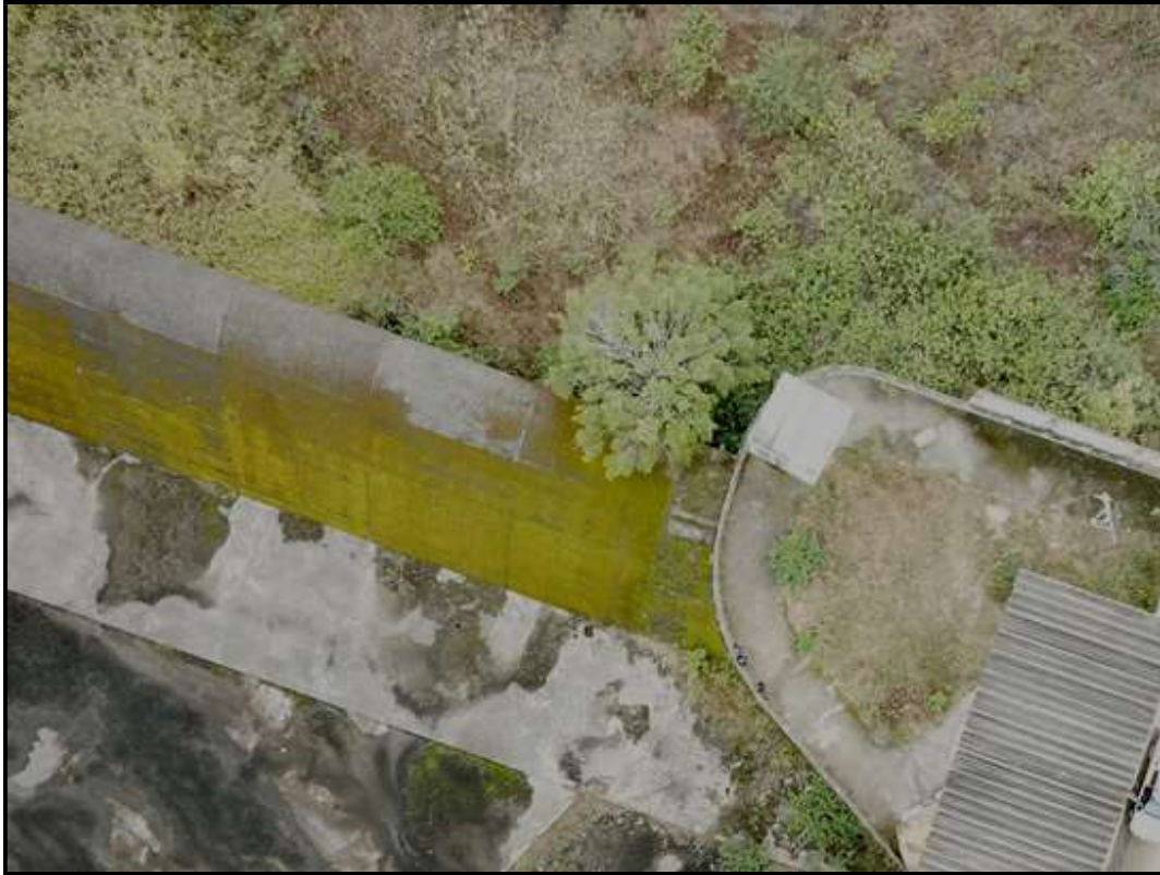
Foto 10 – Vista Aérea da Crista Vertente do Vertedouro, com Presença de Árvores de Grande Porte
