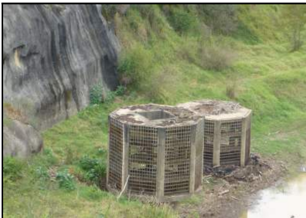
Foto 31 – Estrutura de Emboque Tipo Tulipa dos Túneis de Descarga.
