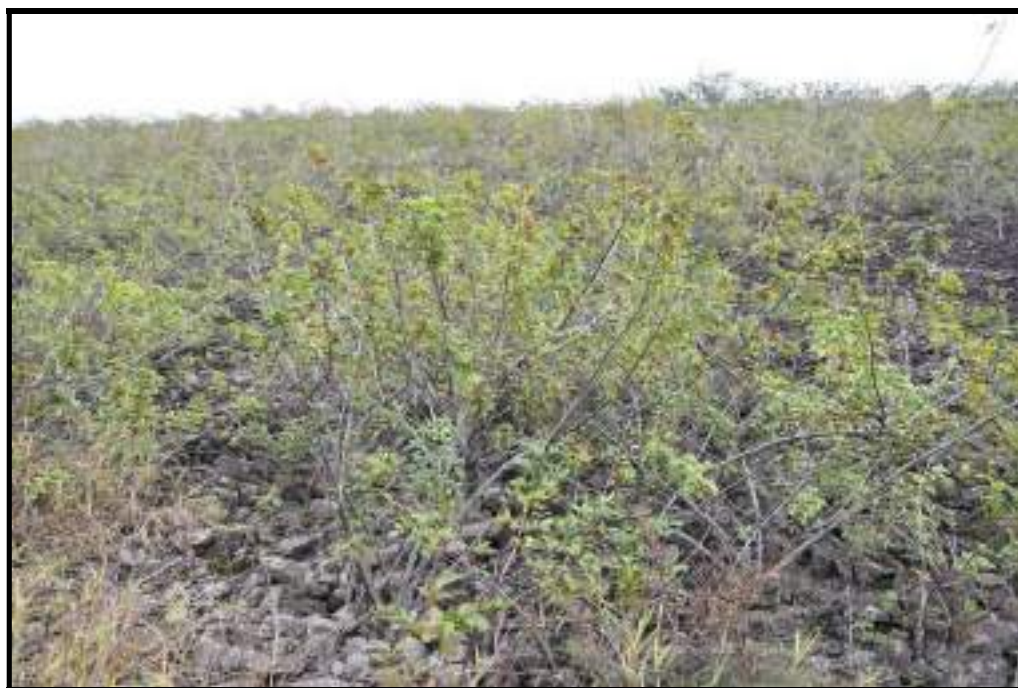
Foto 5- Vista Geral do Talude de Jusante com Grande Quantidade de Vegetação Arbustiva
