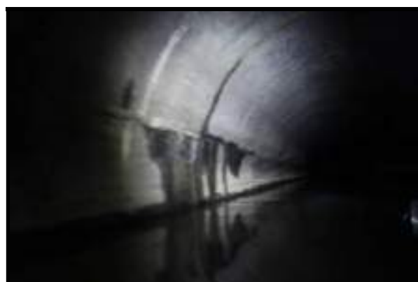
Foto 24 – Infiltração em junta horizontal de construção próxima a boca de saída.
