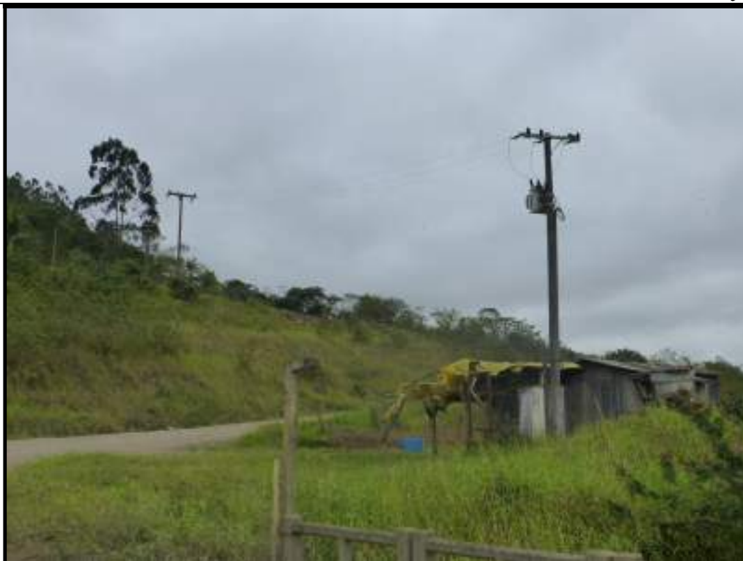
Foto 51 – Linha de Alimentação Elétrica e Posto de Transformação/Medição de Energia Elétrica
