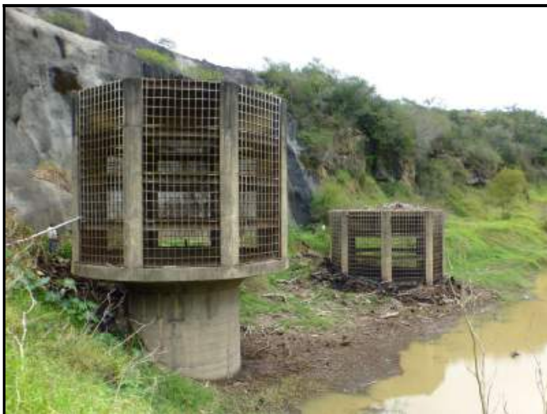
Foto 31 – Estruturas de emboque dos túneis de descarga tipo tulipa dos túneis direito e esquerdo
