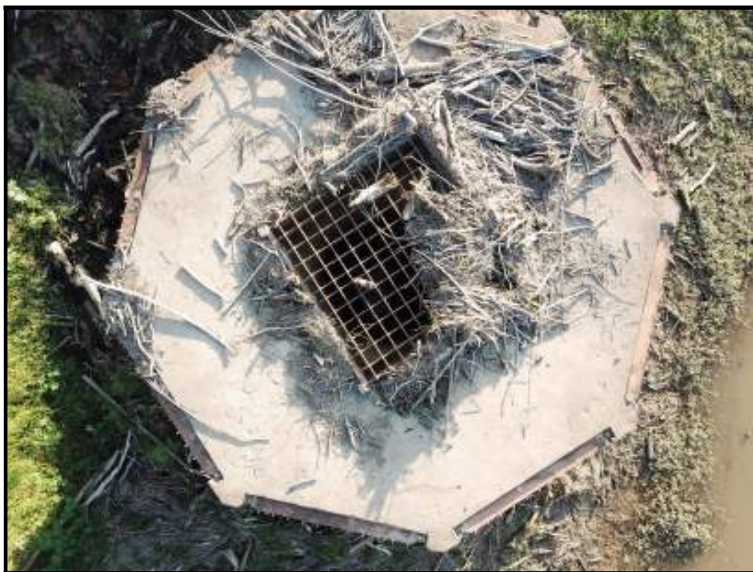
Foto 36 –Grade da Laje Superior da Estrutura de Emboque Tipo Tulipa do Túnel Externo de Descarga (Direito)
