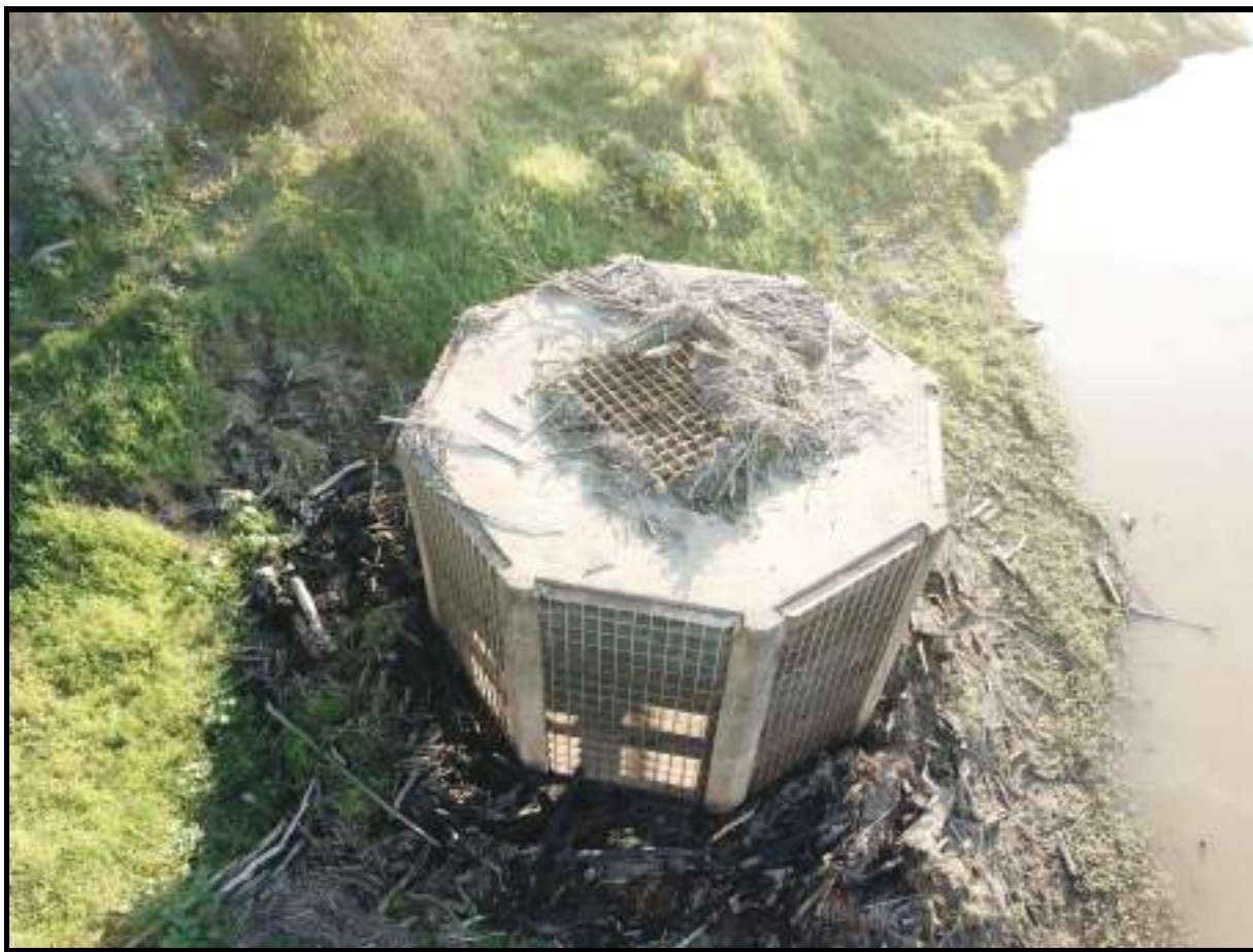
Foto 35 –Grade da Laje Superior da Estrutura de Emboque Tipo Tulipa do Túnel Externo de Descarga (Direito)
