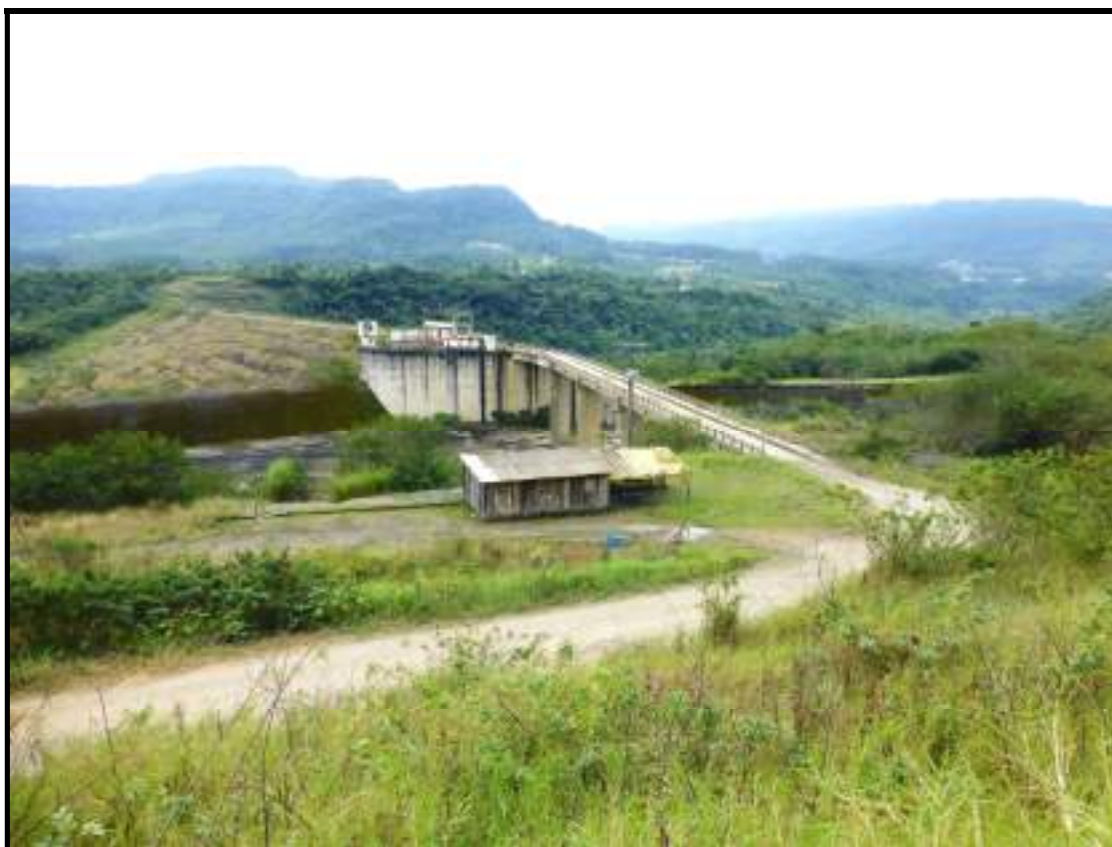
Foto 50 – Vista Geral da Barragem e Posto de Transformação/Medição de Energia Elétrica
