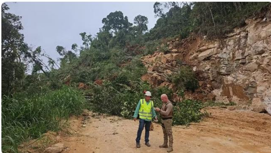
Deslizamento de terra em Angelina, SC, deixa trabalhador soterrado — Foto: Prefeitura de Angelina/Divulgação
