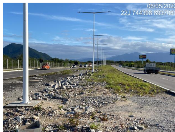
Figura 5.26: Área do canteiro central (Km 37+000 ao Km 37+712).
