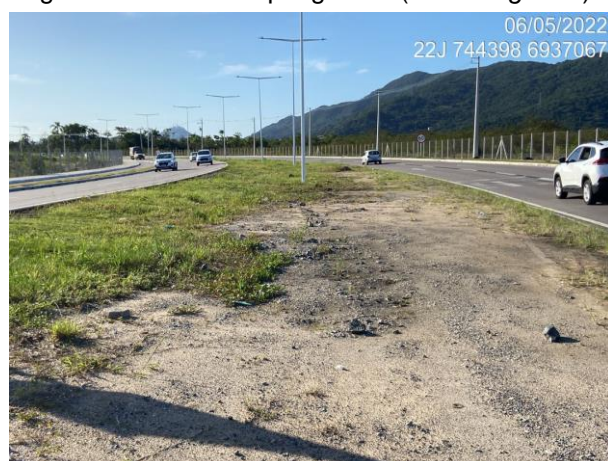
Figura 5.22: Área do canteiro central (Km 37+000 ao Km 37+712).
