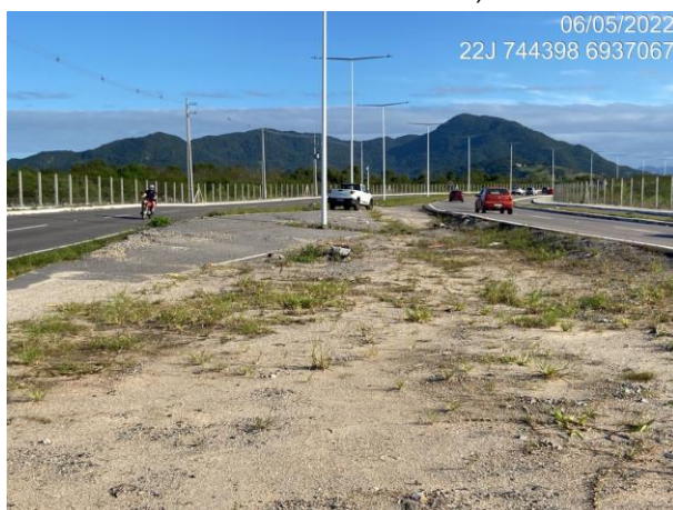
Figura 5.23: Área do canteiro central (Km 37+000 ao Km 37+712).
