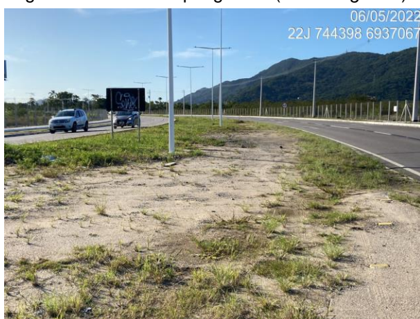
Figura 5.21: Área do canteiro central (Km 37+000 ao Km 37+712).
