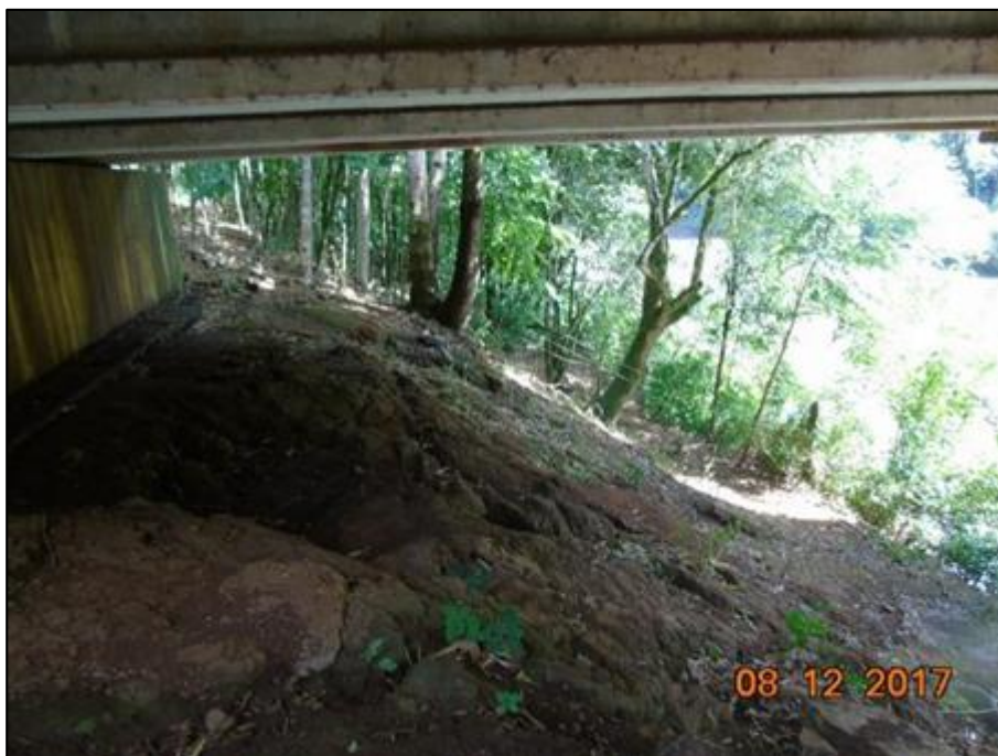
Figura 5. Foto de local apropriado para passagem da fauna sob a ponte do rio Irani (margem direita).
