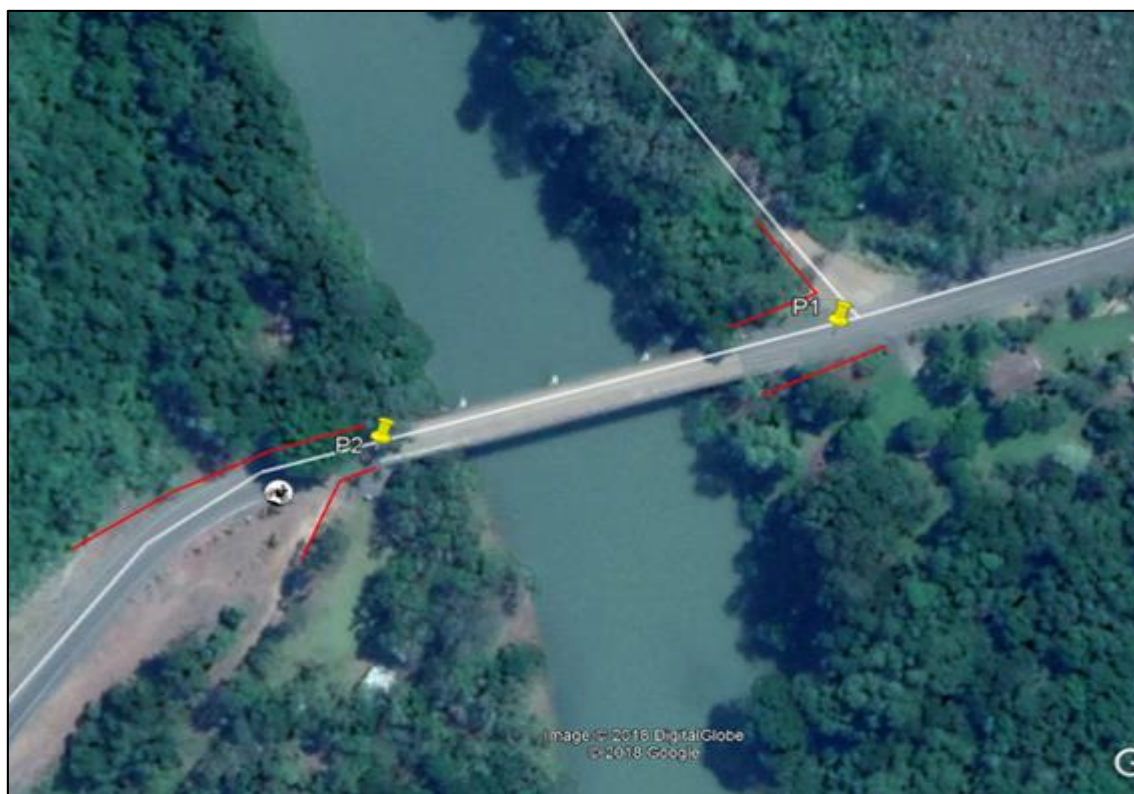
Figura 3. Local de implantação do passa fauna sob ponte, com detalhamento da localização da cercas direcionadoras.
