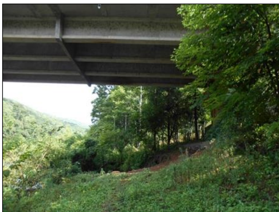
Figura 4. Foto de local apropriado para passagem da fauna sob a ponte do rio Irani (margem esquerda).
