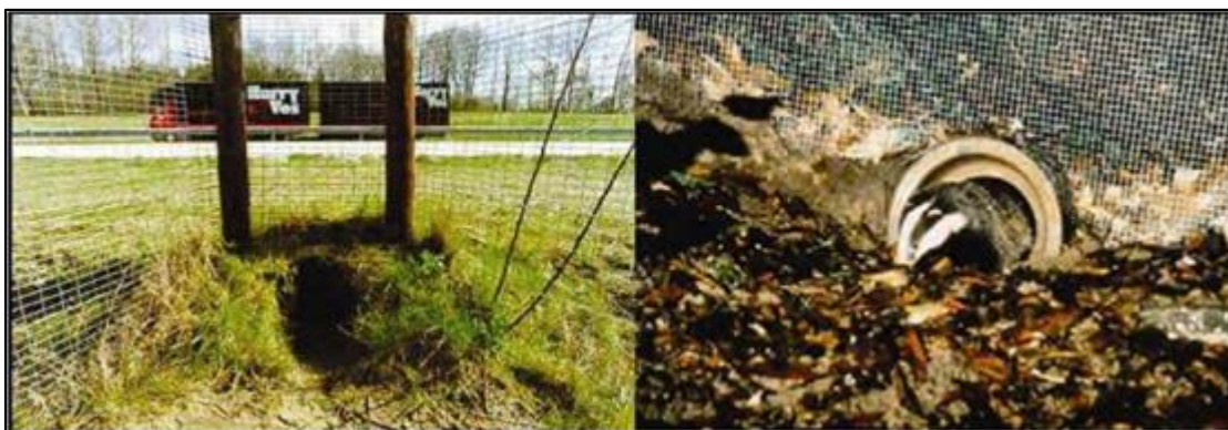
Figura 6. Exemplos de passagens para pequenos animais associada a telas de proteção.
