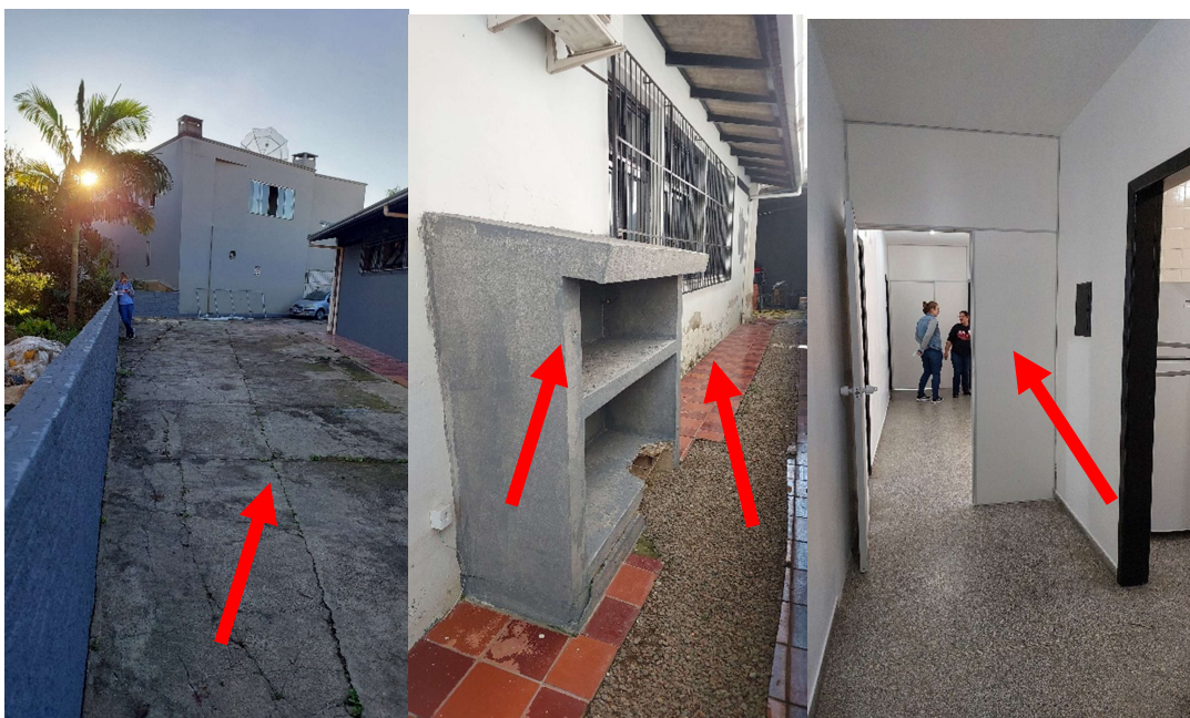
Figura 03: Áreas de Remoção de Piso de Concreto, Piso Cerâmico, Lixeira e Divisória Leve
