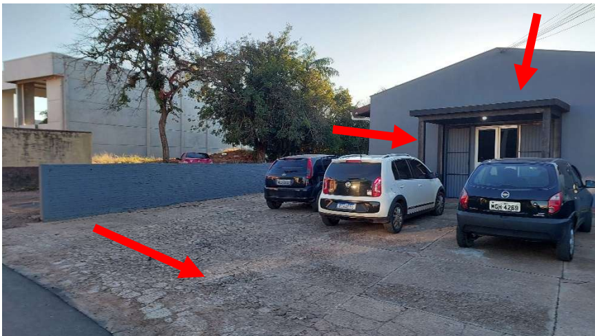
Figura 02: Áreas de Remoção de Piso de Concreto, Marquise e Pilares da Fachada
