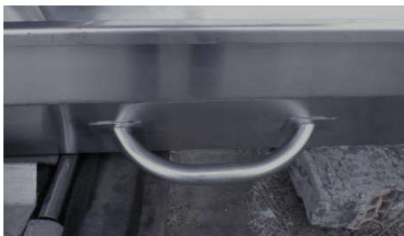
Foto 01 - Alças fixas em formato cilíndrico com base soldada.
