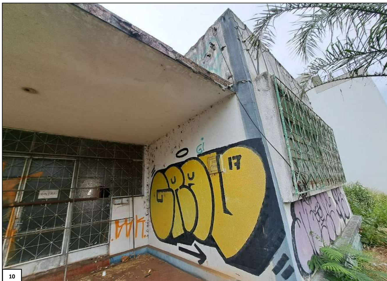
Imagem 10 – Vista da edificação existente no terreno avaliando
