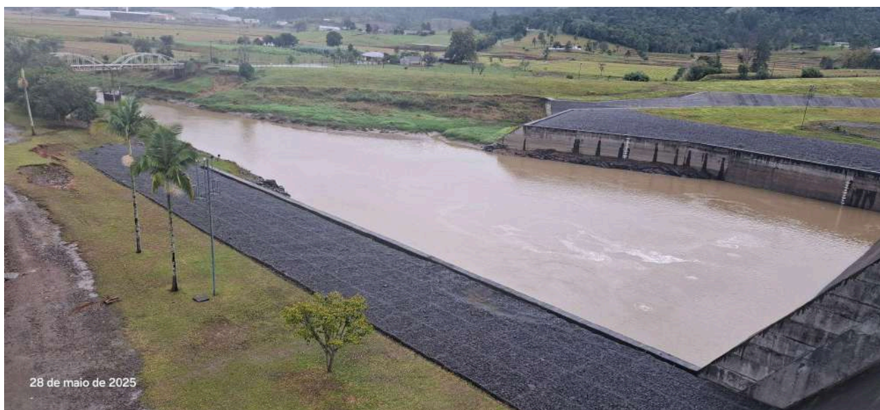
Figura 7. Comportas de fundo sob vertedouro.
