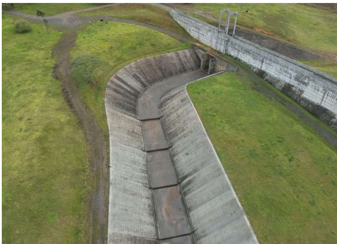
Figura 15. Vista de jusante do canal extravasor.
