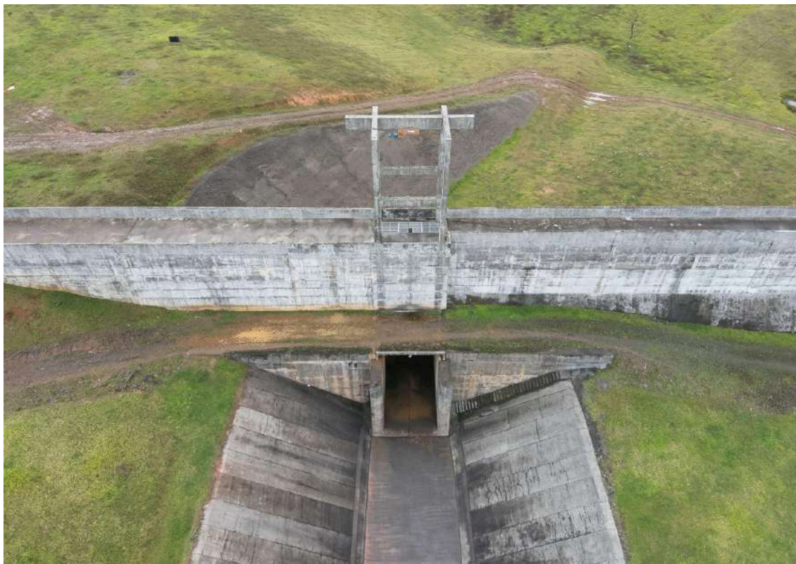
Figura 16. Revestimento concreto da jusante do canal extravasor.
