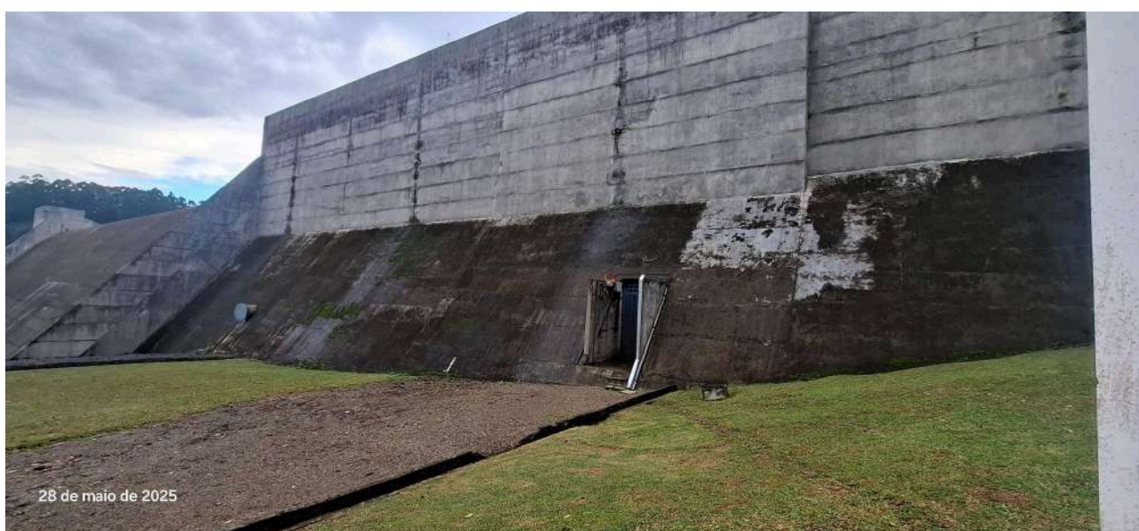
Figura 10. Barragem margem esquerda – acesso à galeria das comportas.
