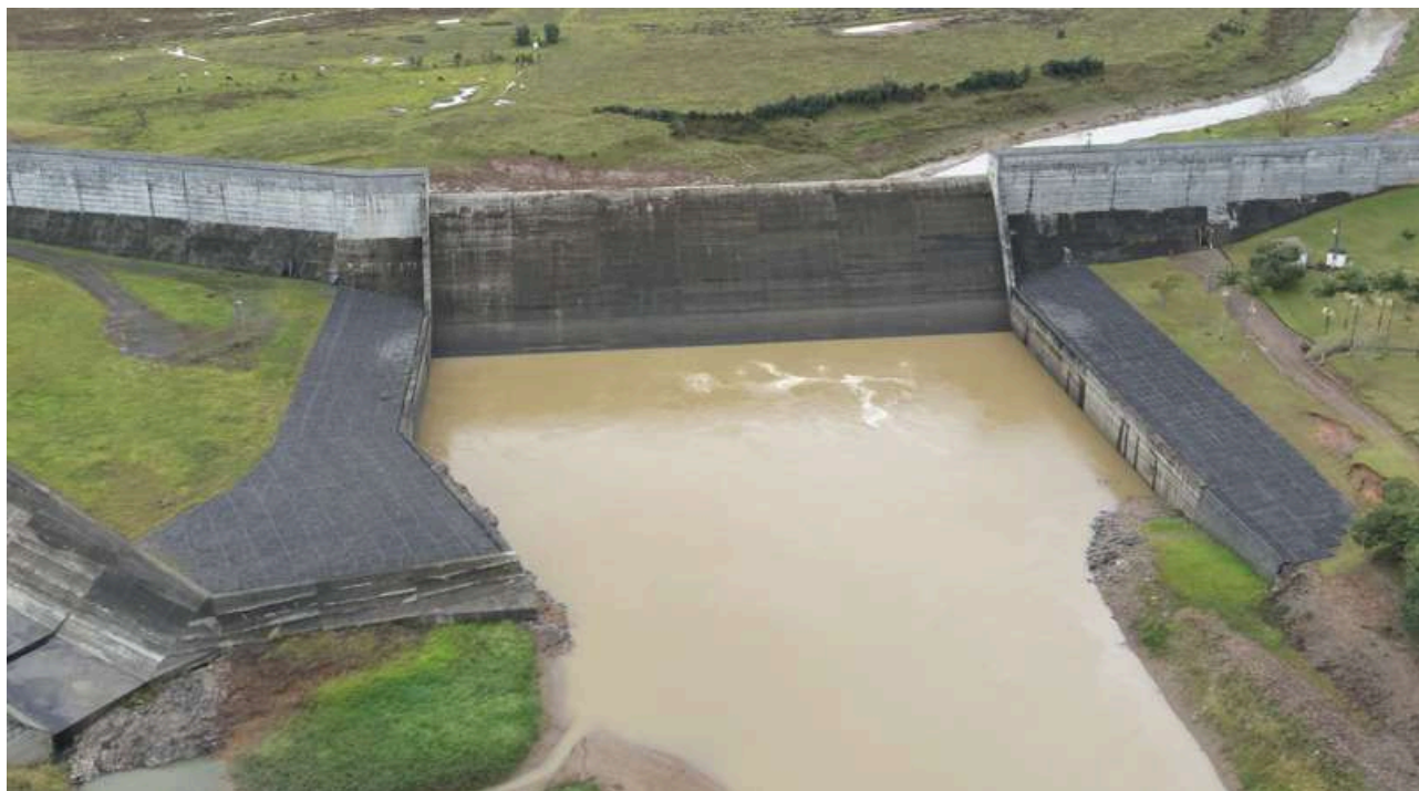
Figura 5. Vertedouro de soleira livre.
