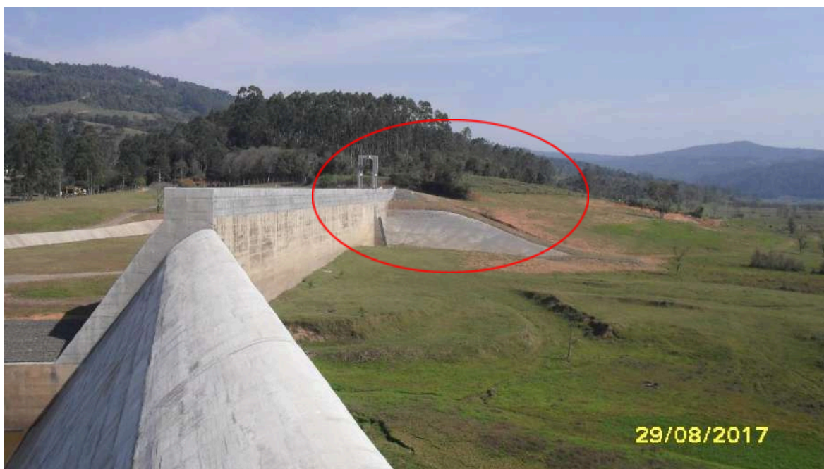
Figura 12. Montante da Tomada d'água do canal extravasor.
