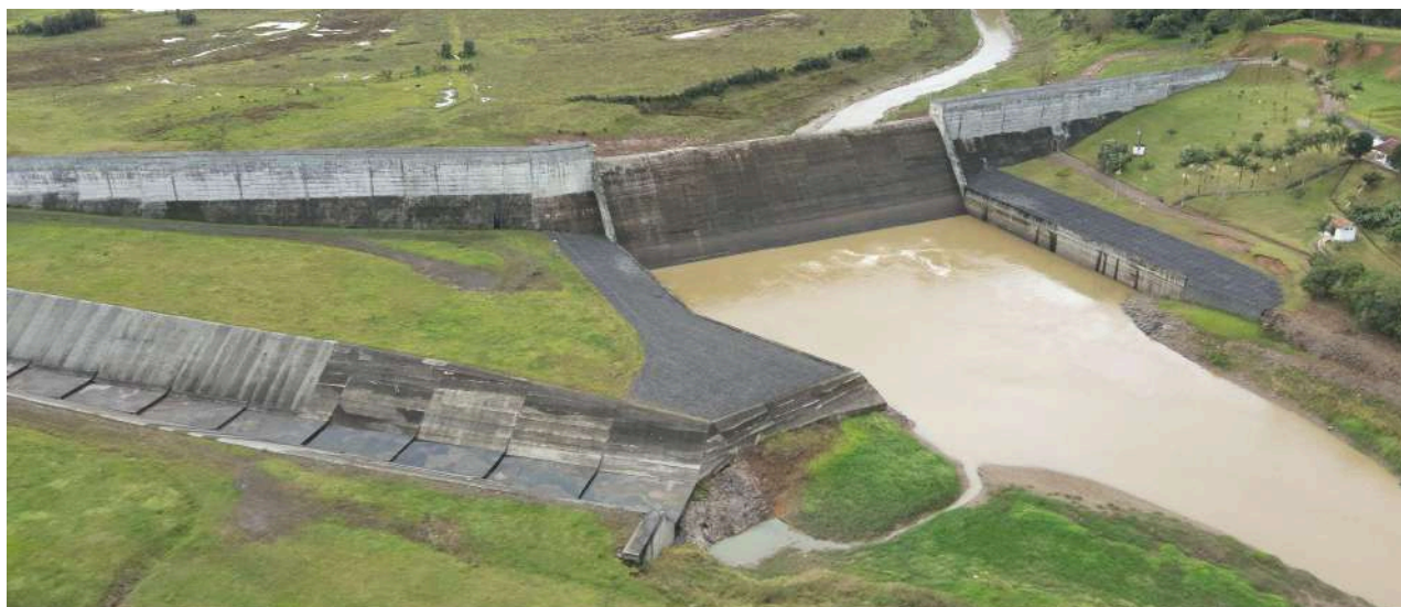
Figura 2. Vista geral do empreendimento, SPDC, 2025.
