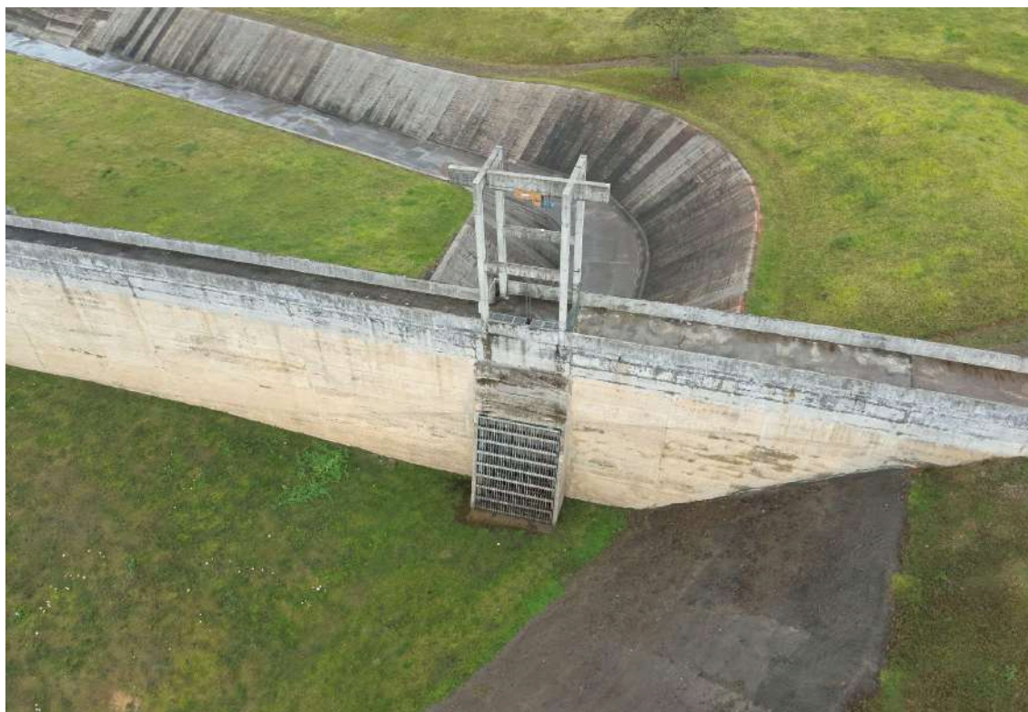
Figura 14. Canal extravasor - face de montante
