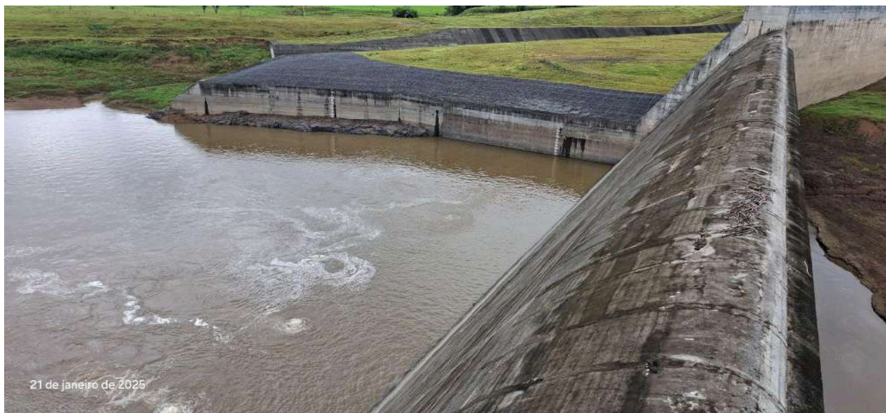
Figura 6. Detalhe da soleira alteada em 3,5 m.
