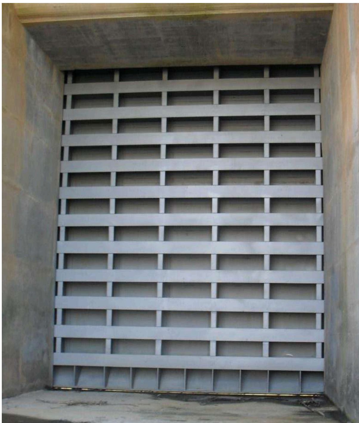
Figura 13. Vista de jusante da comporta canal extravasor.
