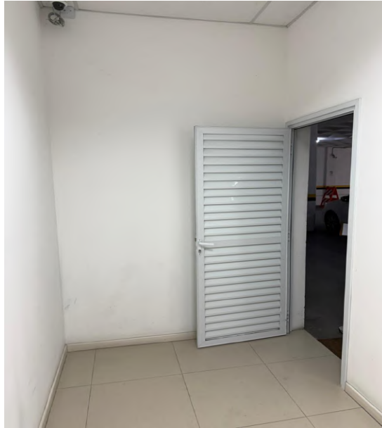
6- Local de instalação da porta de vidro
