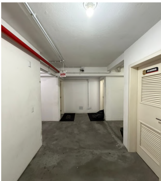
3 - Local de instalação do vidro fixo
