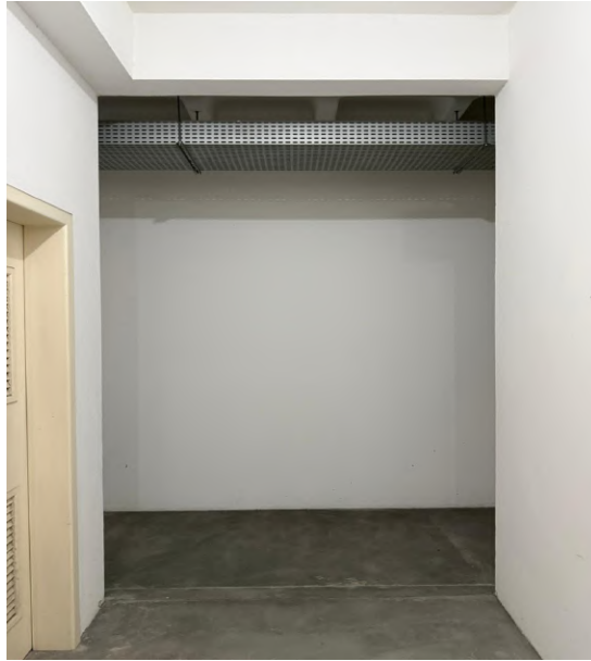
9 - Local de instalação do vidro fixo
