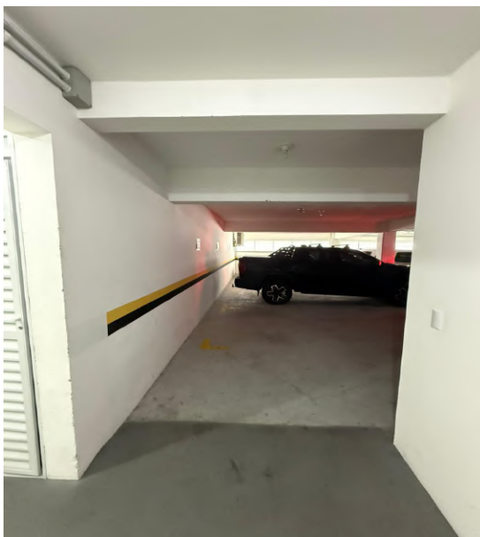
12 - Local de instalação do vidro fixo
