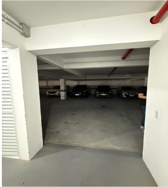
15 - Local de instalação do vidro fixo
