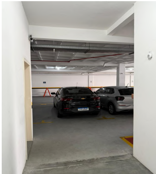
8- Local de instalação das portas de vidro
