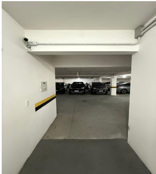
14- Local de instalação das portas de vidro
