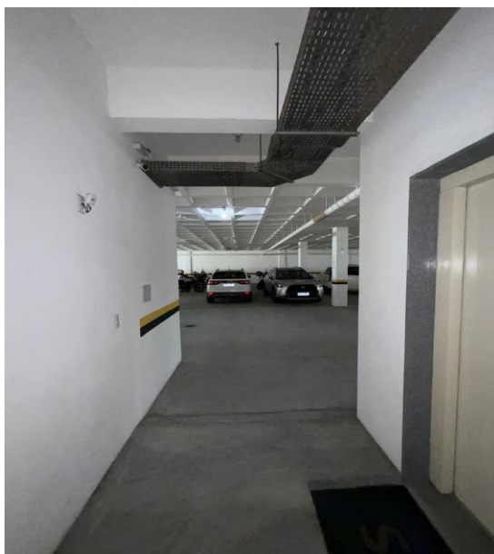
20- Local de instalação das portas de vidro
