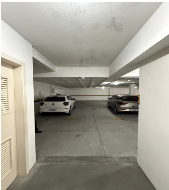
2- Local de instalação das portas de vidro
