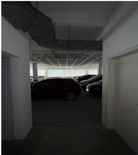
21 - Local de instalação do vidro fixo
