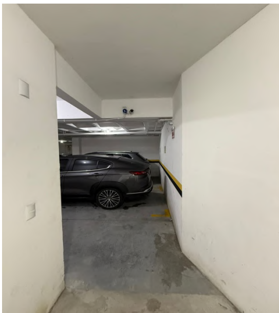
5 - Local de instalação do vidro fixo
