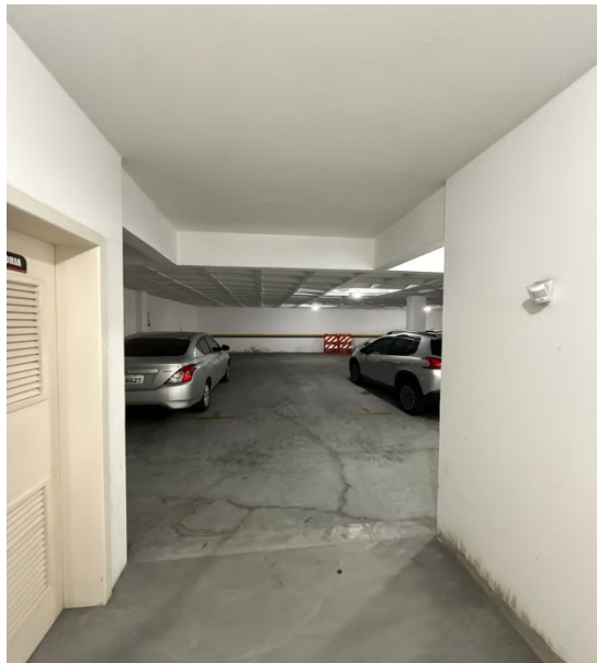
4- Local de instalação das portas de vidro
