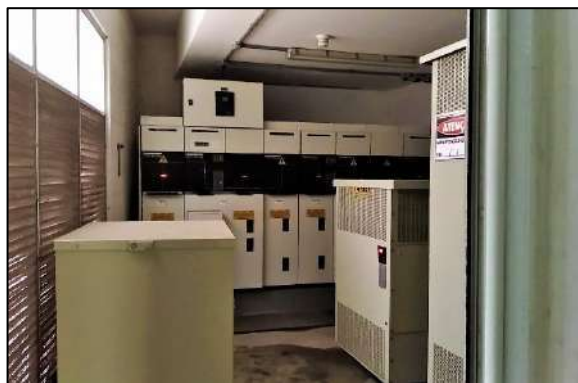
Fotos 21 e 22 – Os painéis de comando instalados no ambiente ao lado do sistema motogerador apresentam falta de componentes.
