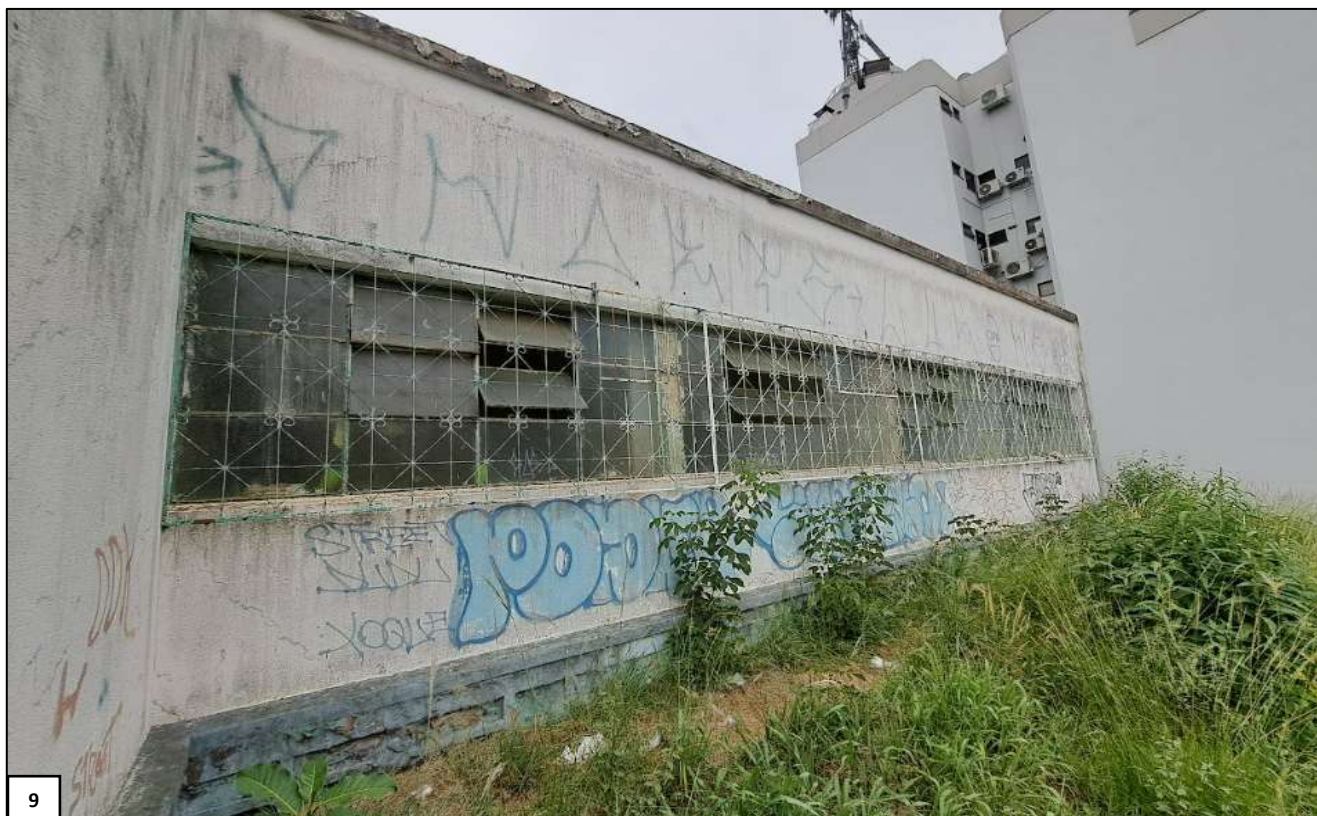
Imagem 9 – Vista da parte frontal do terreno avaliando, paralela à Av. General Osório
