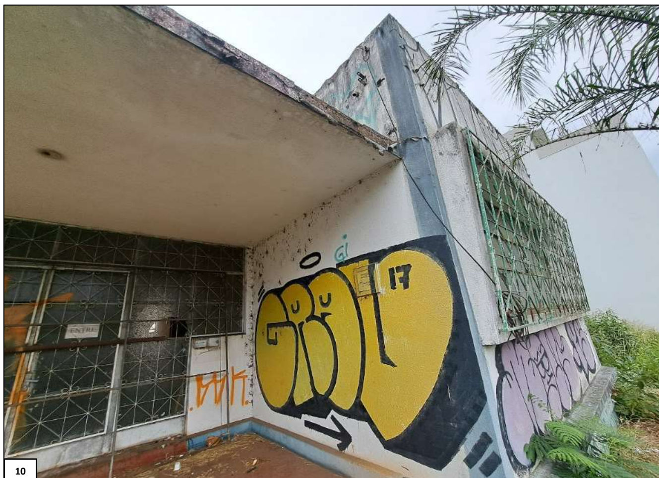
Imagem 10 – Vista da edificação existente no terreno avaliando
