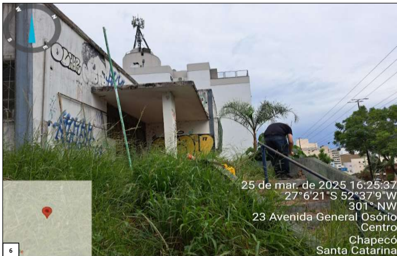
Imagem 6 – Vista da parte frontal do terreno avaliando, paralela à Av. General Osório
