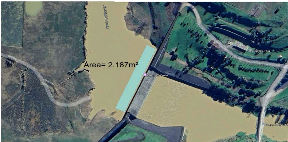
Figura 7 - Área da entrada da tomada d'água.
