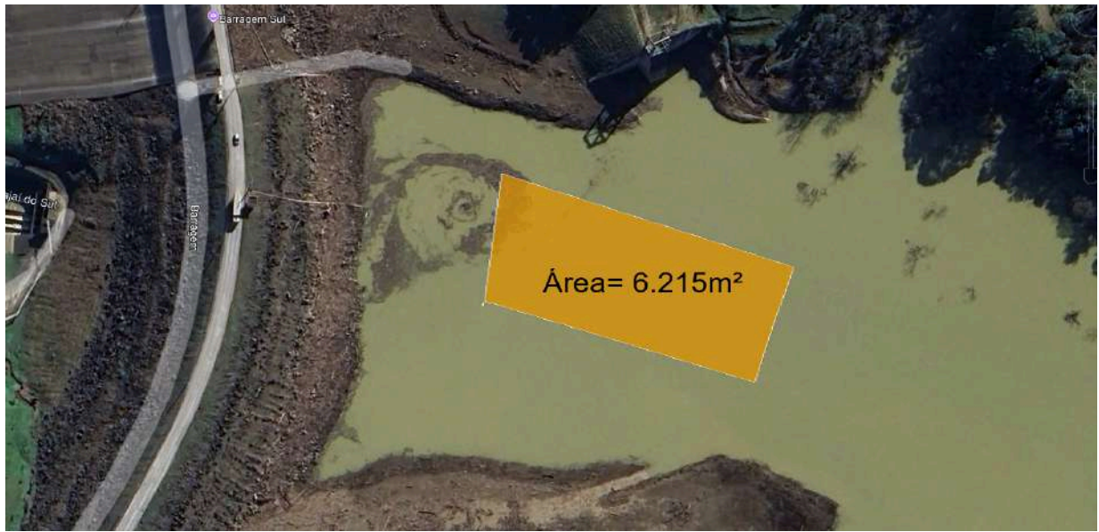
Figura 6 - Área de desassoreamento.
