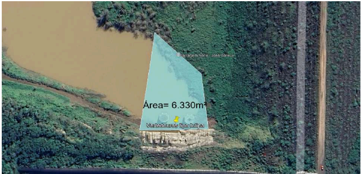
Figura 02 - Área do Vertedouros tipo tulipa.
