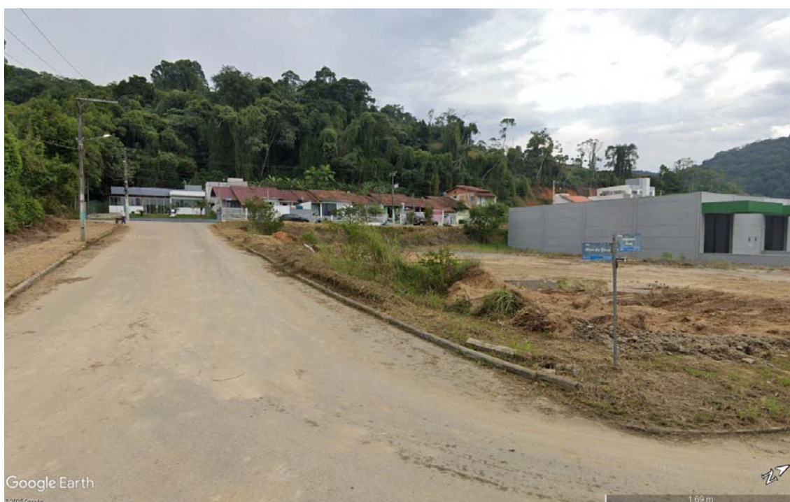
Figura 04 – Panorâmica do local de acesso para o local aonde realizamos as sondagens que se encontra após o morro, nos fundo da imagem. Cortesia Google Street View. Data da imagem jul/2023.
