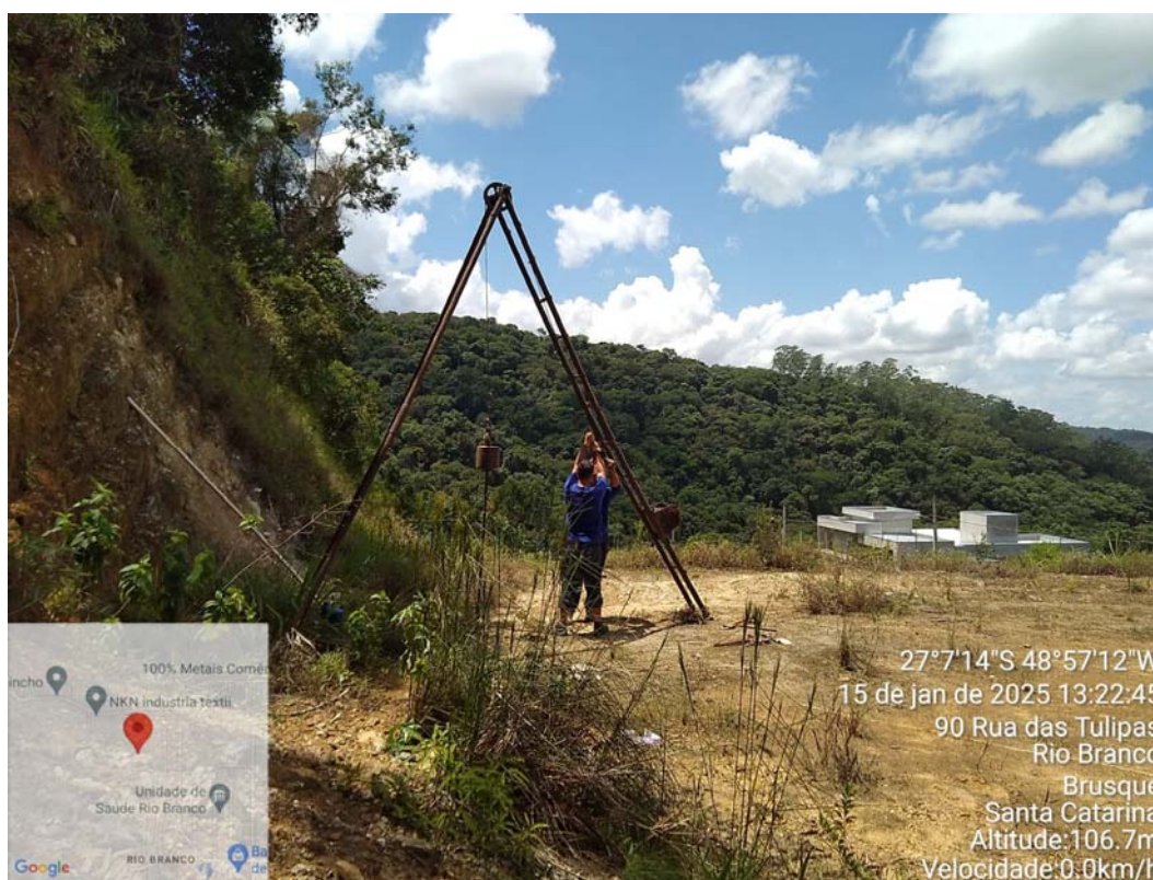
Foto 08 – Perfuração do furo SP-04 . Foto Sergio.
