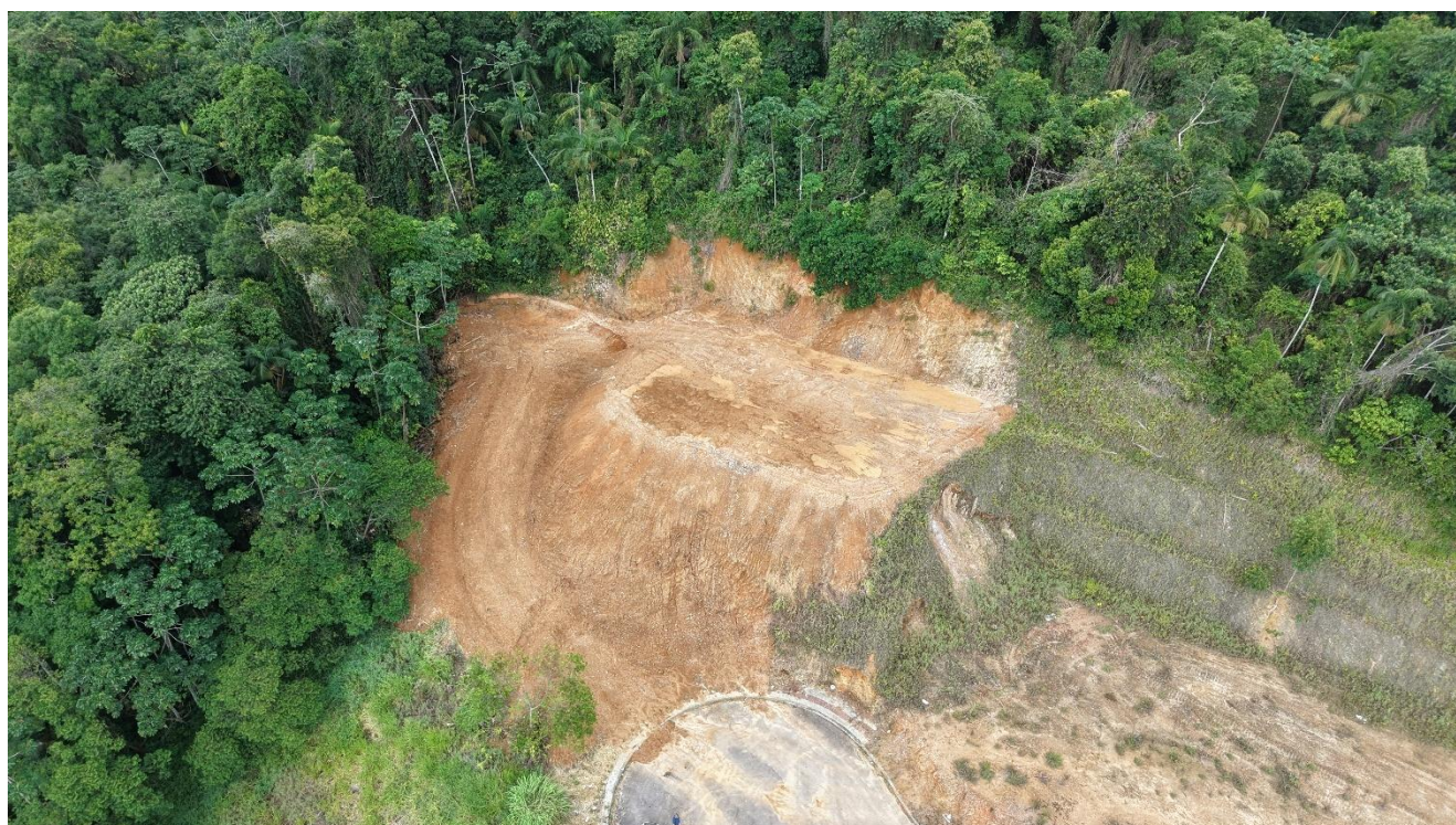
Figura 05. Imagem aérea para implantação do novo reservatório.
