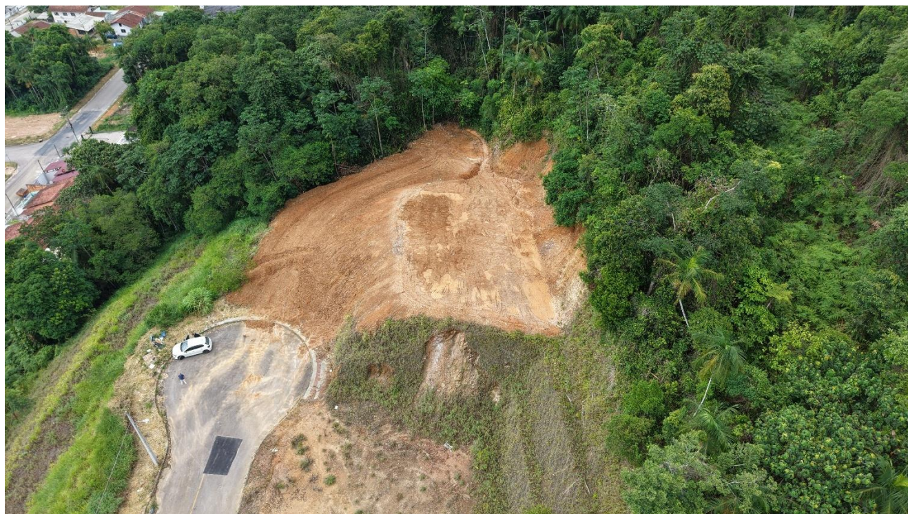
Figura 06. Imagem aérea para implantação do novo reservatório.
