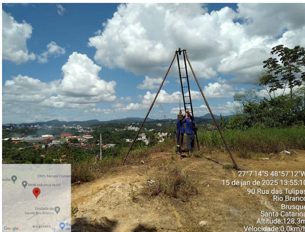
Foto 10 – Perfuração do furo SP-05 . Foto Sergio.
