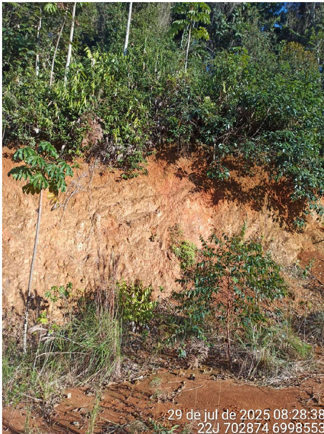
Fotografias 3 – Talude de corte no limite oeste da área onde será instalado o reservatório Rio Branco.
