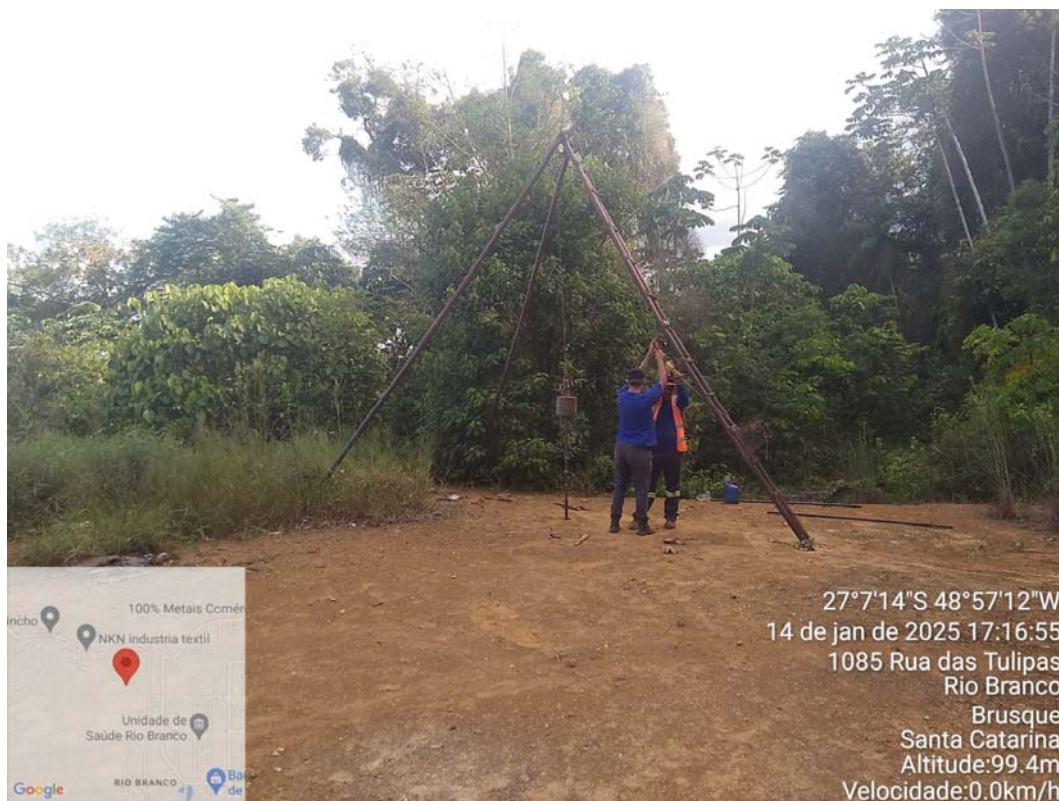
Foto 02 – Perfuração do furo SP-01 . Foto Sergio.
