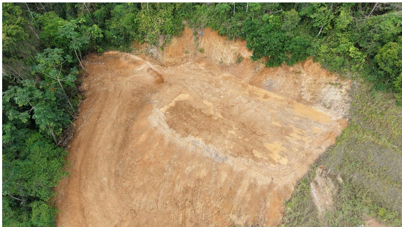
Figura 04. Imagem aérea para implantação do novo reservatório.
