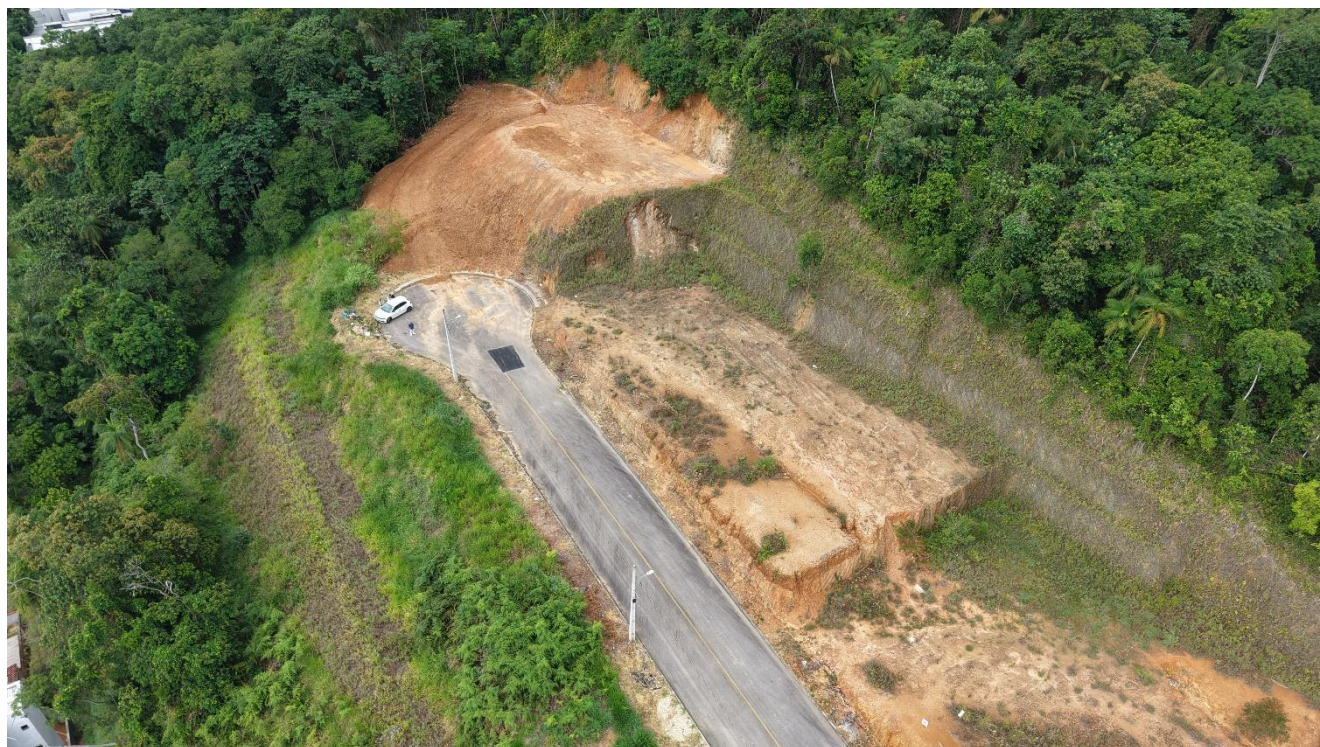
Figura 10. Estrutura da via de acesso da área do reservatório.
