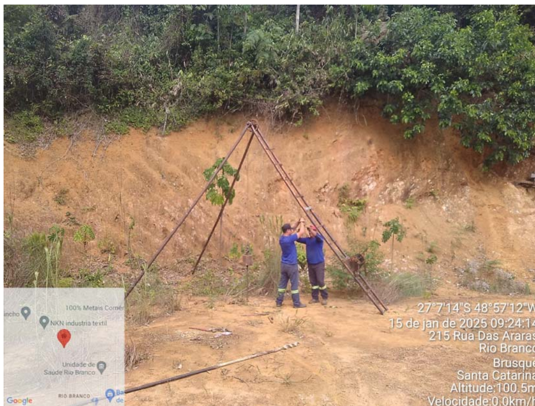
Foto 04 – Perfuração do furo SP-02 . Foto Sergio.
