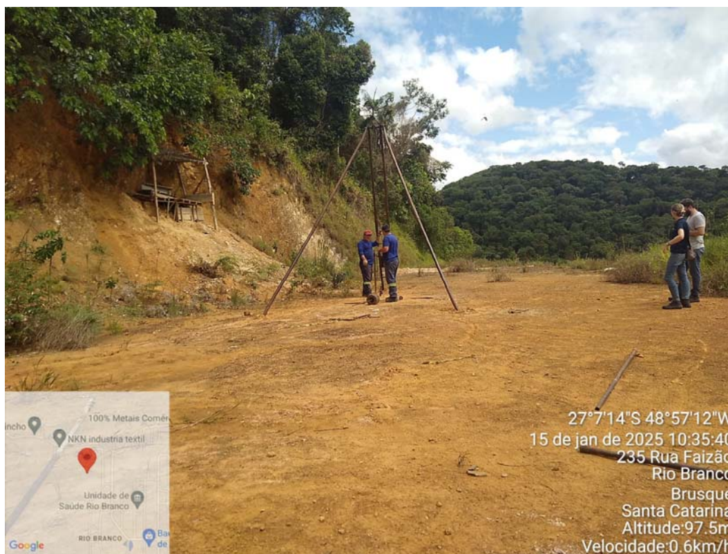
Foto 06 – Perfuração do furo SP-03 . Foto Sergio.
