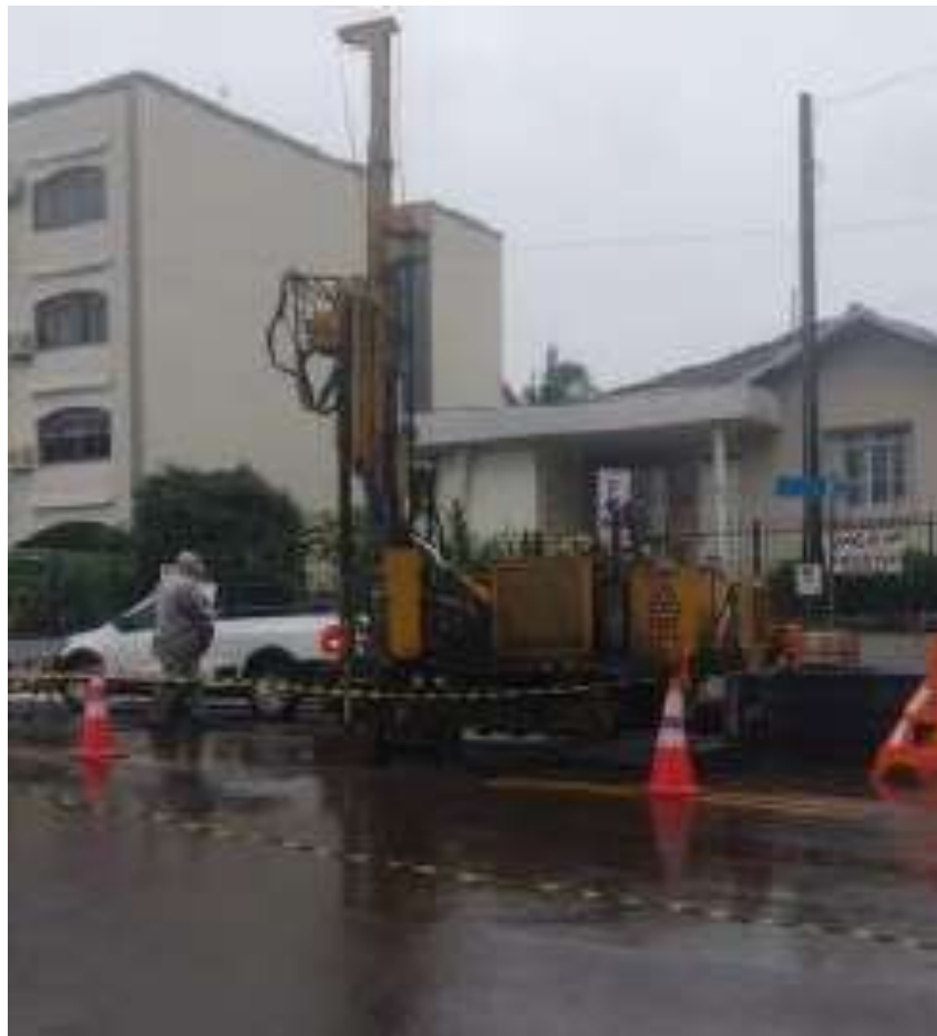
Figura 12: Execução de sondagem SM03.
