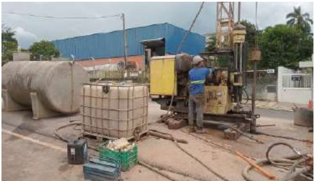
Figura 18: Execução de sondagem SM05.
