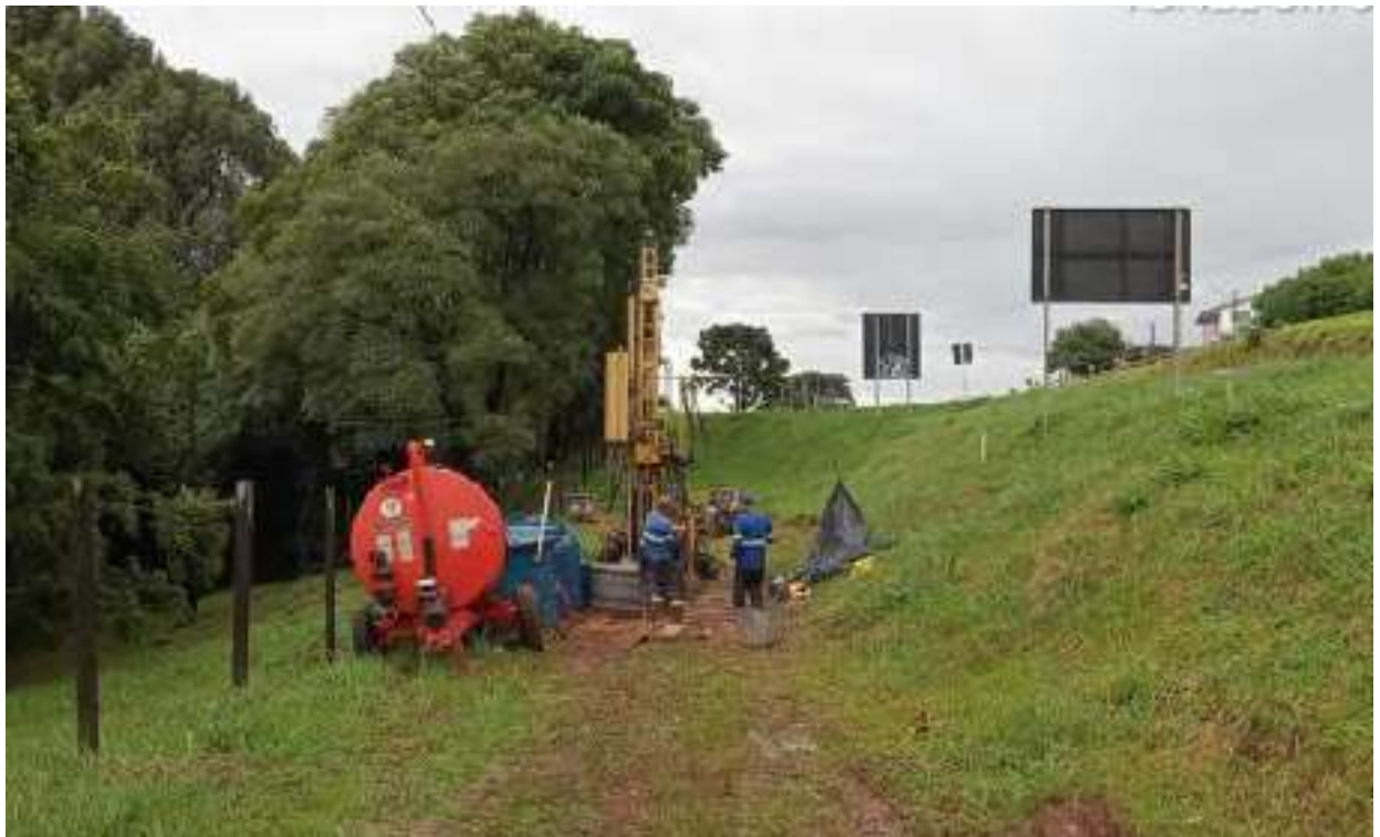
Figura 24: Execução de sondagem SM07.
