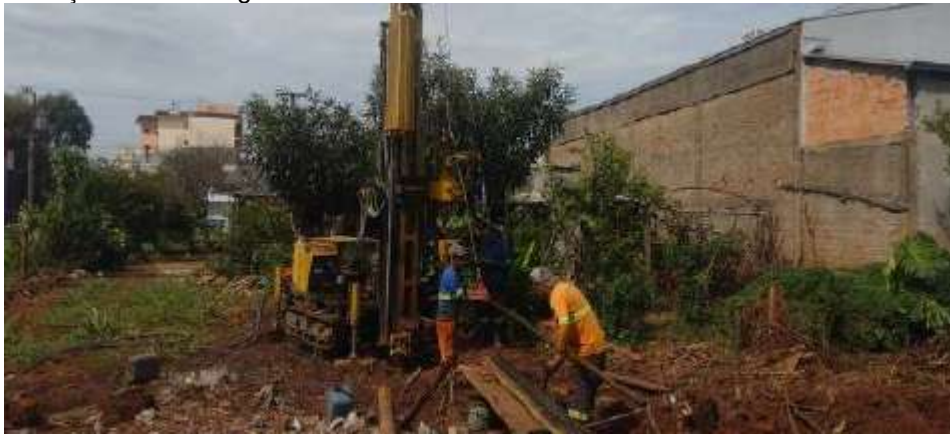
Figura 9: Execução de sondagem SM02.
