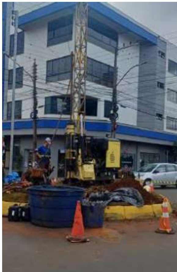
Figura 15: Execução de sondagem SM04.
