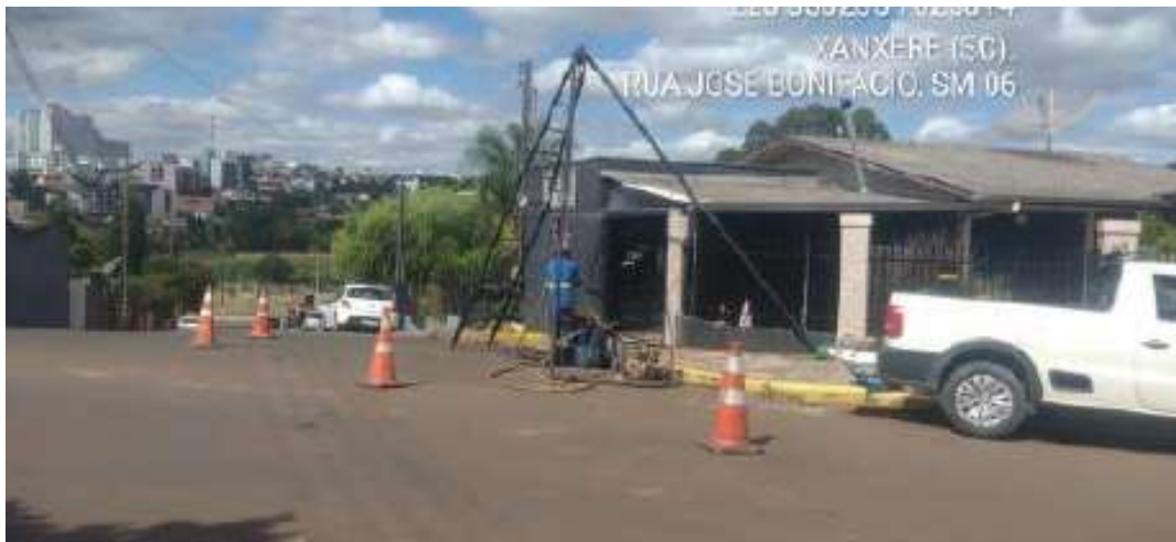
Figura 21: Execução de sondagem SM06.
