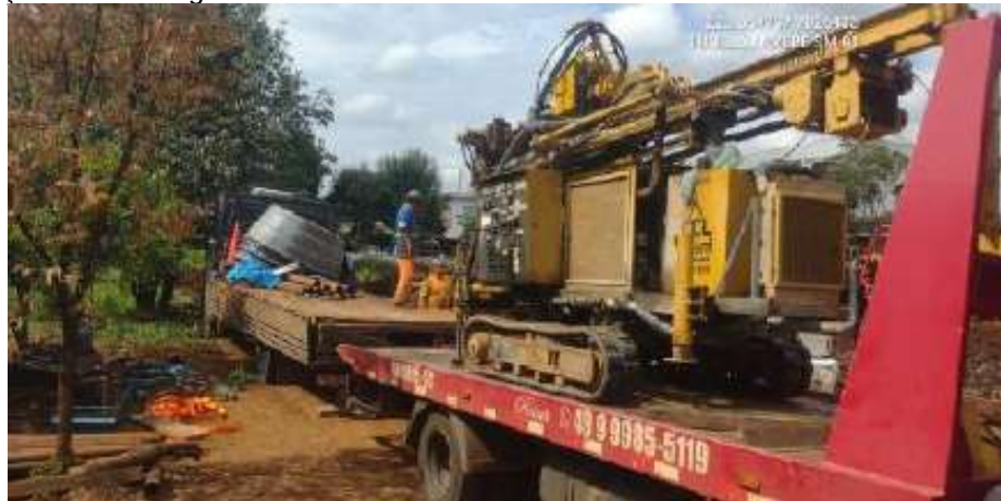
Figura 6: Execução de sondagem SM01.
