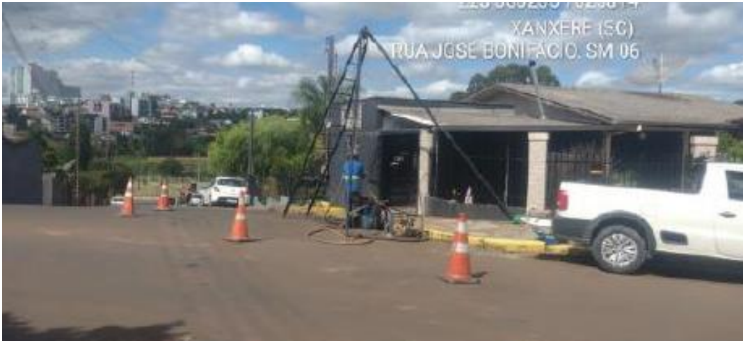
Figura 16: Execução de sondagem SM06.
