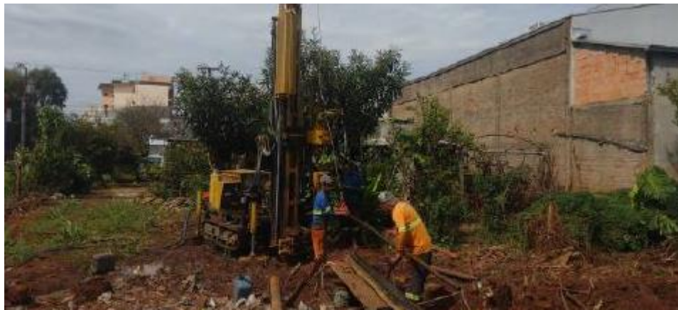
Figura 8: Execução de sondagem SM02.
