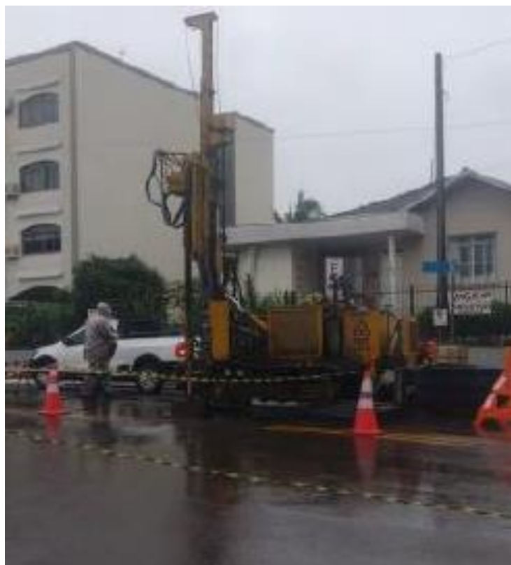
Figura 10: Execução de sondagem SM03.
