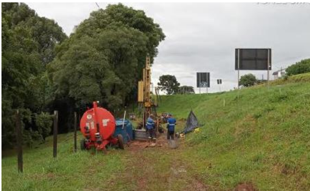
Figura 18: Execução de sondagem SM07.
