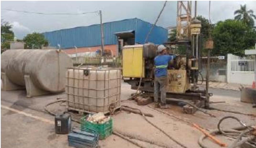
Figura 14: Execução de sondagem SM05.
