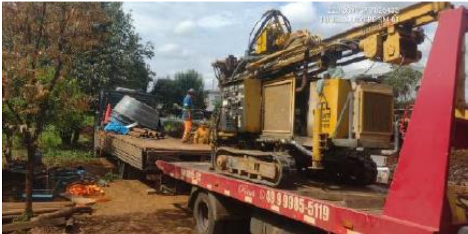
Figura 6: Execução de sondagem SM01.
