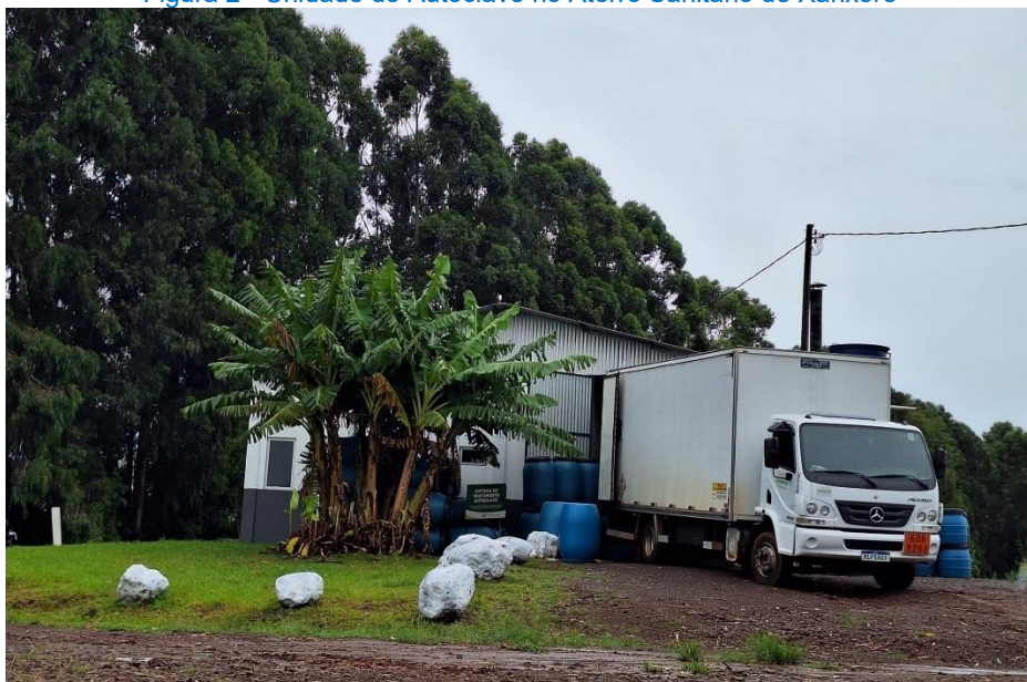
Figura 2 - Unidade de Autoclave no Aterro Sanitário de Xanxerê
