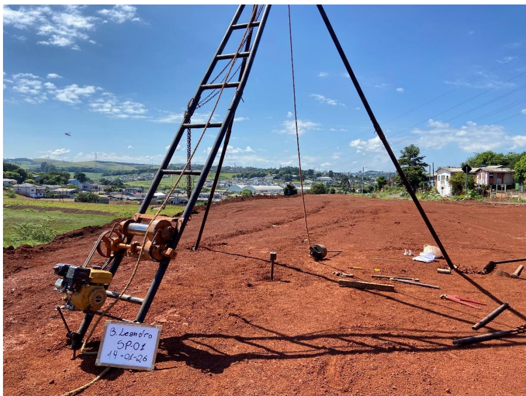
Figura 6. Execução da SP-01.
